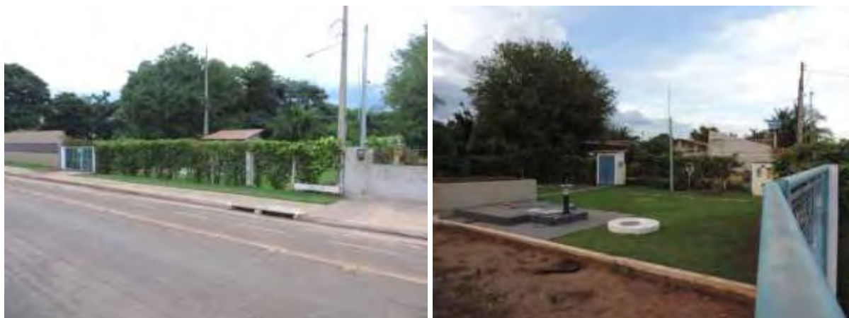
Figura 8: Vista geral da EEEB 012, Coxim, MS.
