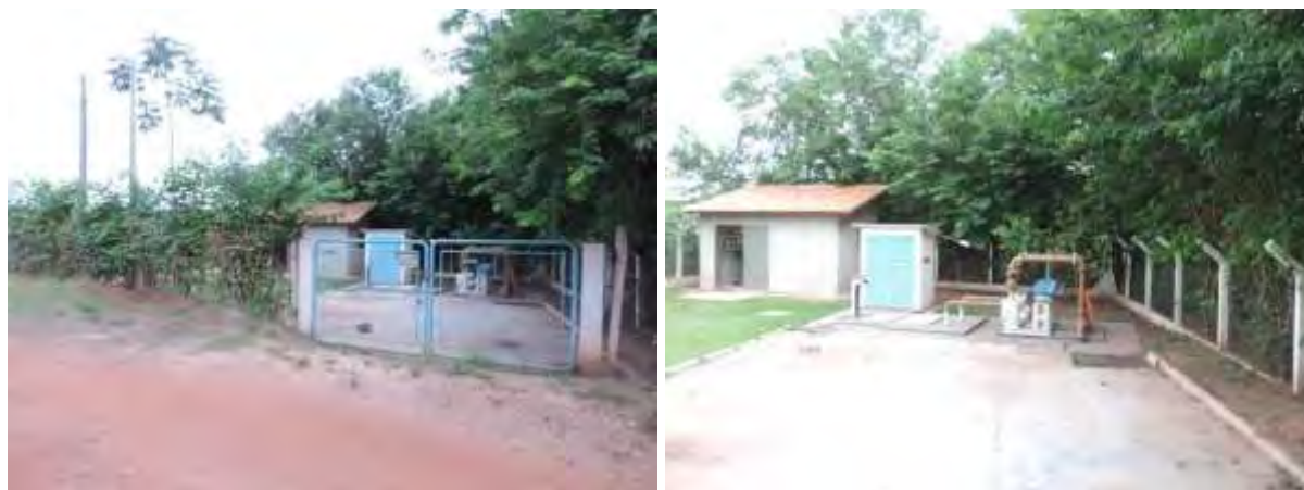
Figura 6: Vista geral da EEEB 009, Coxim, MS.
