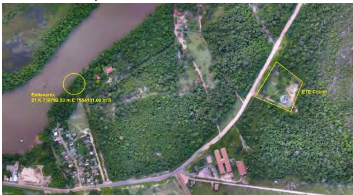
Figura 3a 3: Vista aérea da ETE Coxim e entorno, Coxim, MS.
