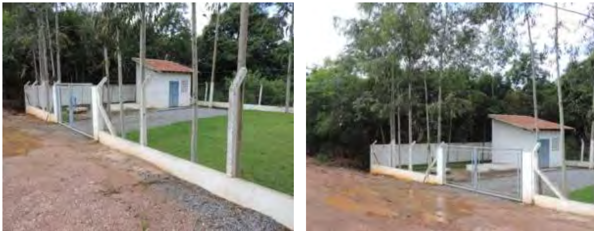
Figura 10: Vista geral da EEEB Tarumã II, Bonito, MS.
