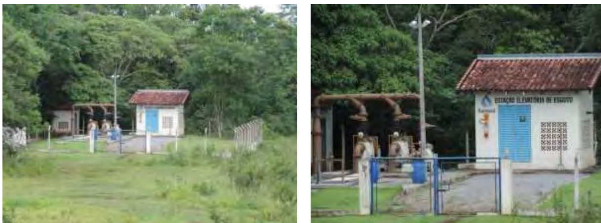
Figura 6: Vista geral da EEEB Final, Bonito, MS.
