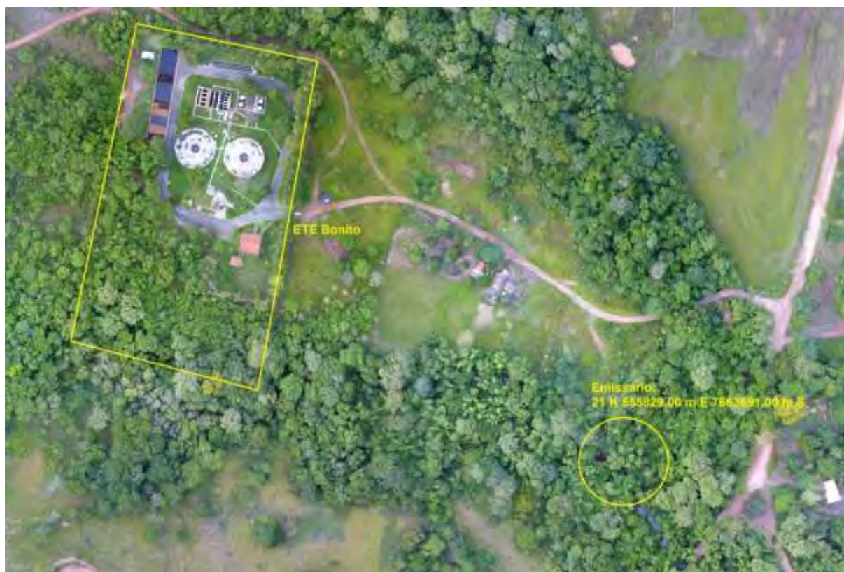
Figura 3: Vista aérea da ETE Bonito e entorno, Bonito, MS.
