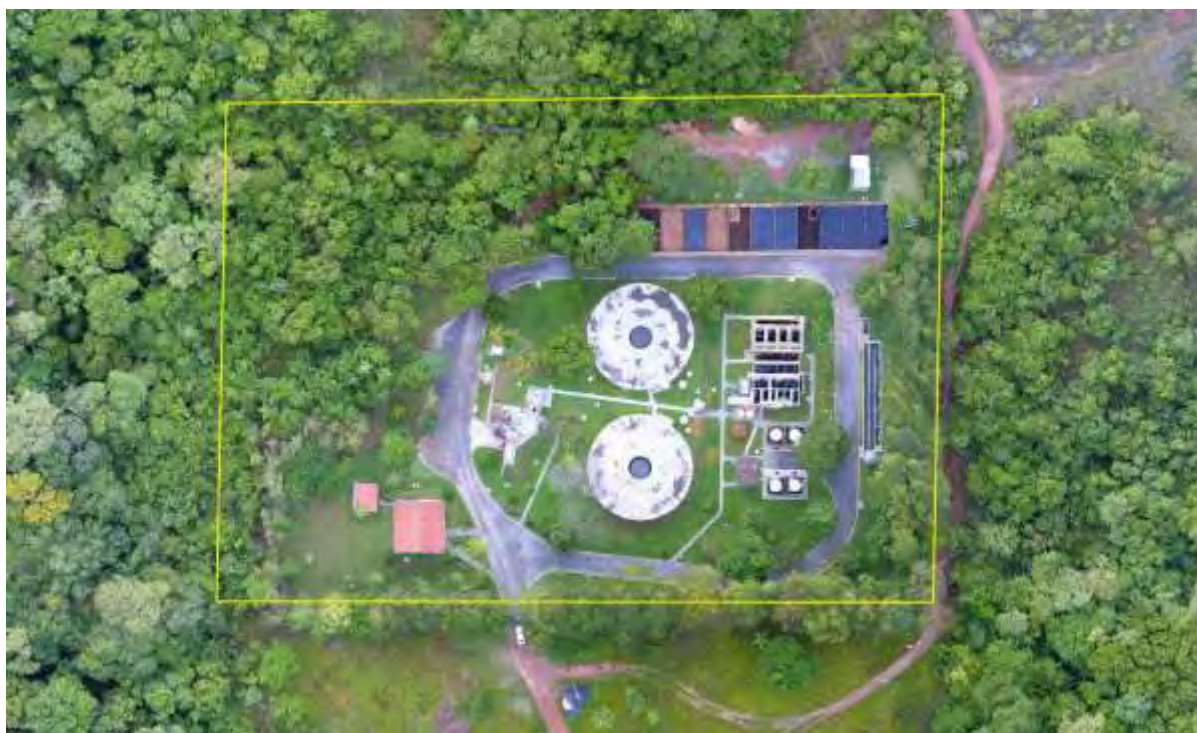
Figura 2: Vista aérea da ETE Bonito, Bonito, MS.
