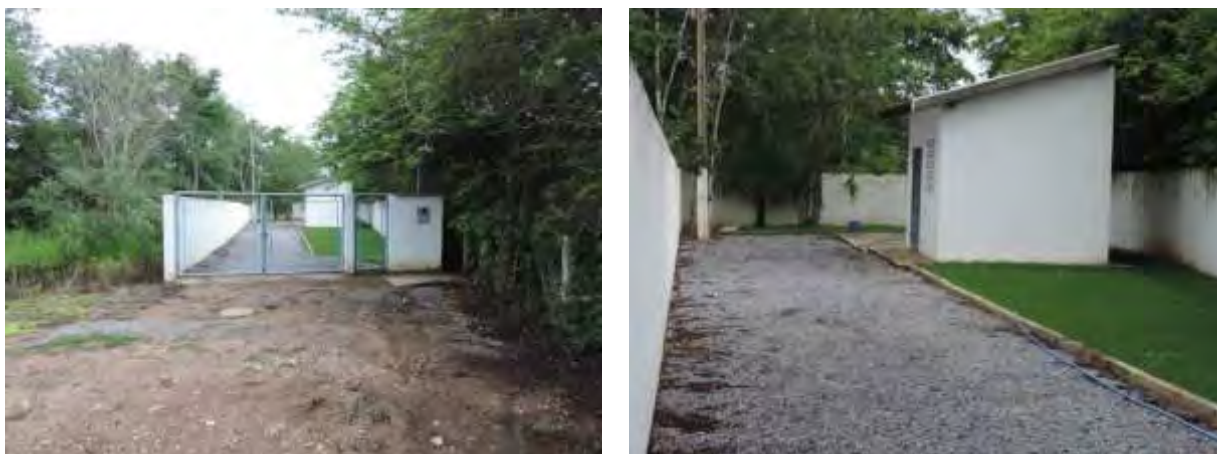
Figura 7: Vista geral da EEEB Portal do Rio Formoso, Bonito, MS.
