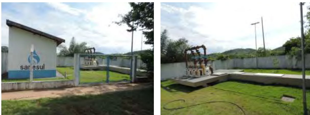
Figura 7: Vista geral da EEEB 003, Bodoquena, MS.
