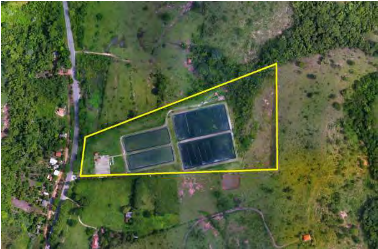
Figura 2: Vista aérea da ETE Bodoquena, Bodoquena, MS.
