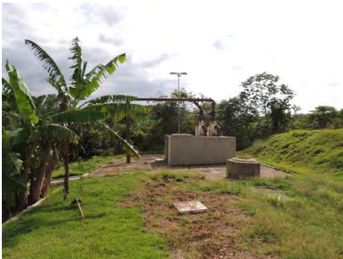
Figura 9: Vista geral da EEET, Bodoquena, MS.
