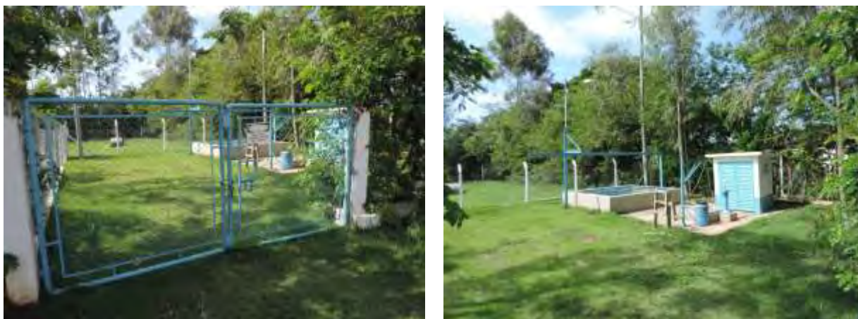
Figura 5: Vista geral da EEEB 001, Bodoquena, MS.
