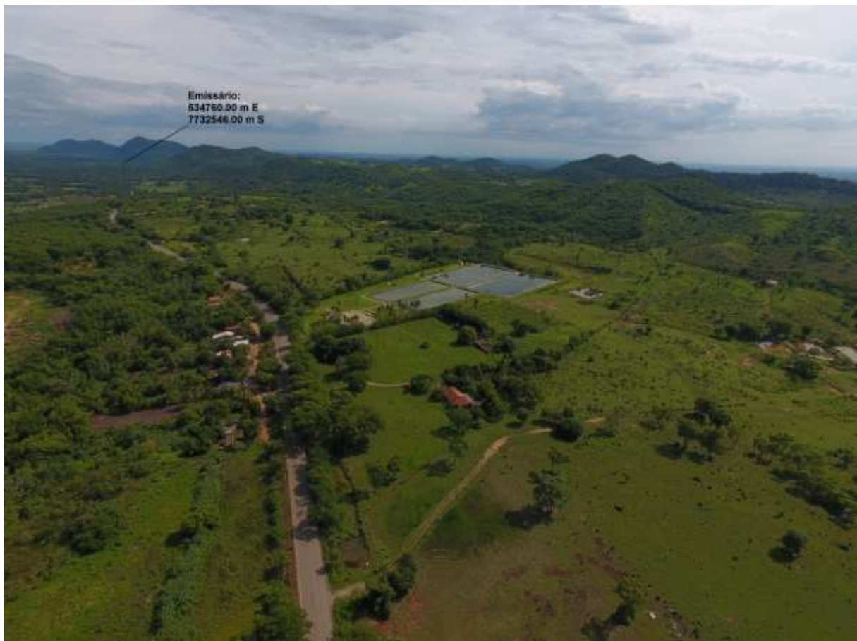
Figura 3: Vista aérea da ETE Bodoquena e entorno, Bodoquena, MS.
