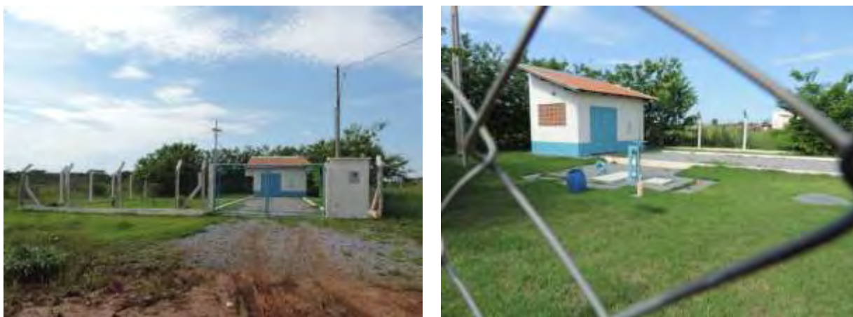
Figura 8: Vista geral da EEEB 004, Bodoquena, MS.
