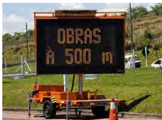
Figura 2.8 - Exemplo de painel móvel de mensagem variável.
