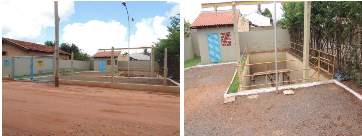
Figura 18: Vista geral da EEEB 01, Três Lagoas, MS.
