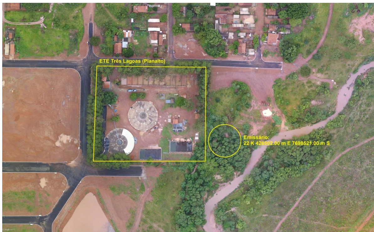
Figura 3: Vista aérea da ETE Planalto em ampliação e de seu entorno, Três Lagoas, MS.
