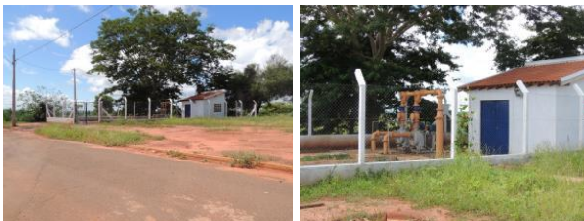
Figura 31: Vista geral da EEEB 015, Três Lagoas, MS.
