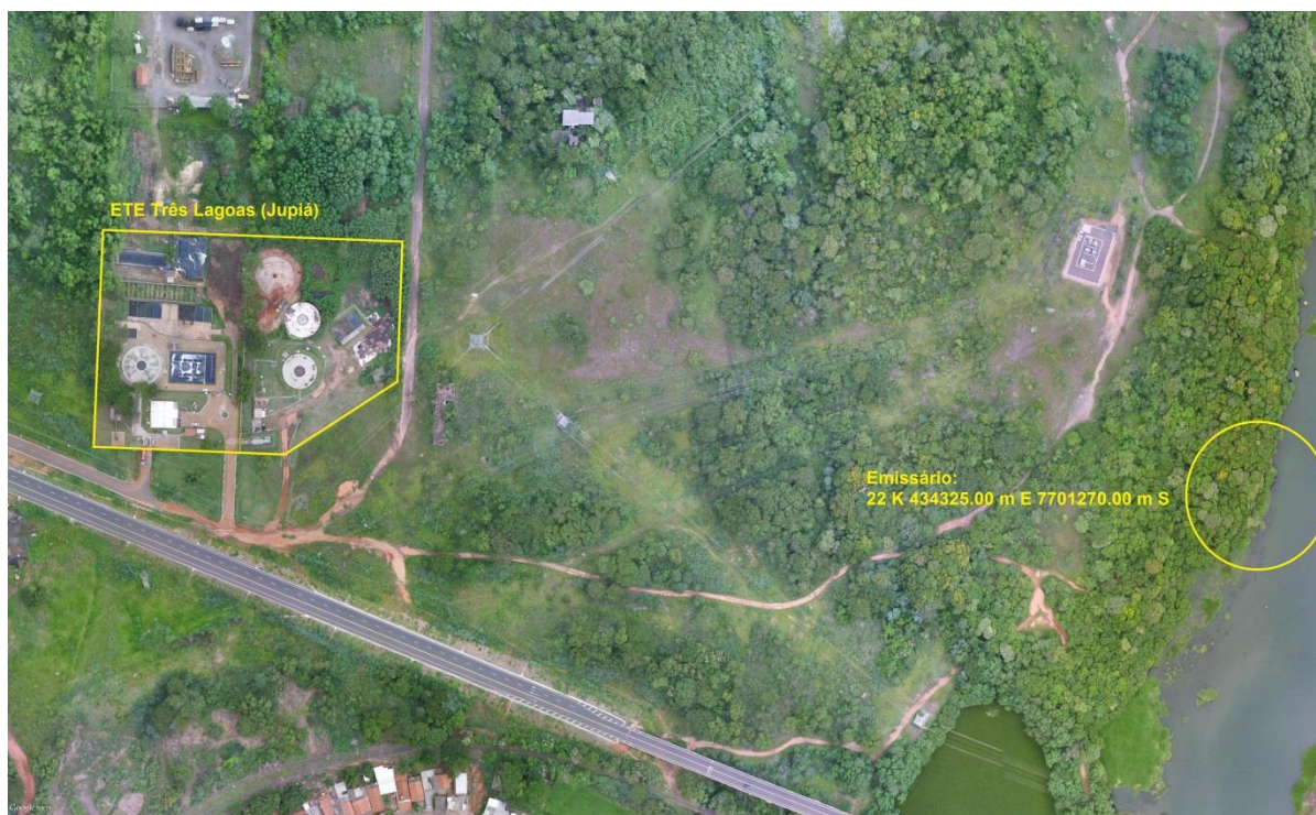
Figura 13: Vista aérea da ETE Jupιά em ampliação e entorno, Três Lagoas, MS.
