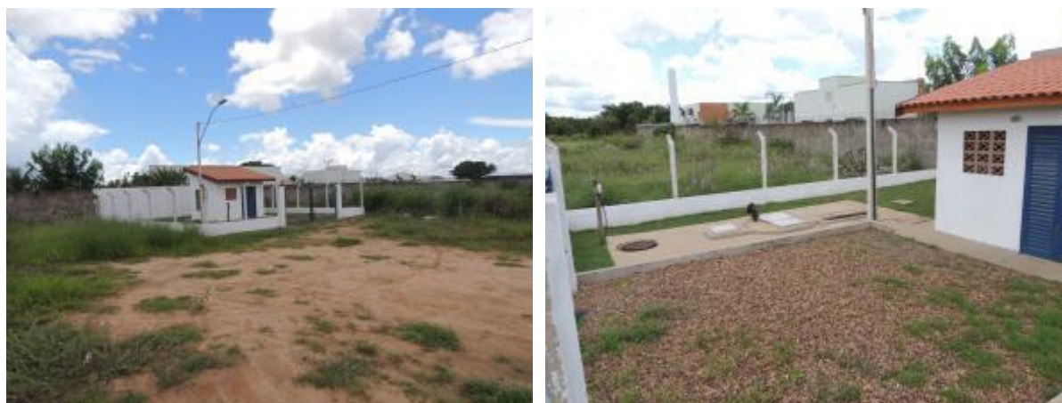
Figura 27: Vista geral da EEEB 011, Três Lagoas, MS.
