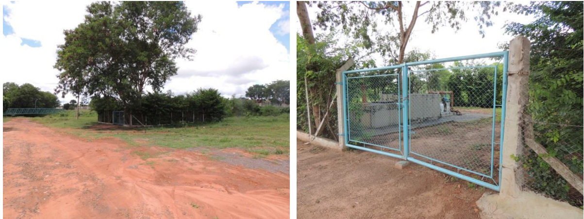
Figura 36: Vista geral da EEEB 020, Três Lagoas, MS.
