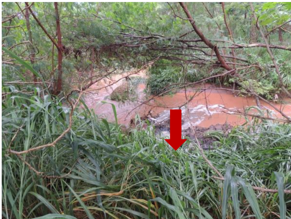
Figura 5: Emissário da ETE Planalto (São João) no Córrego da Onça, Três Lagoas, MS.
