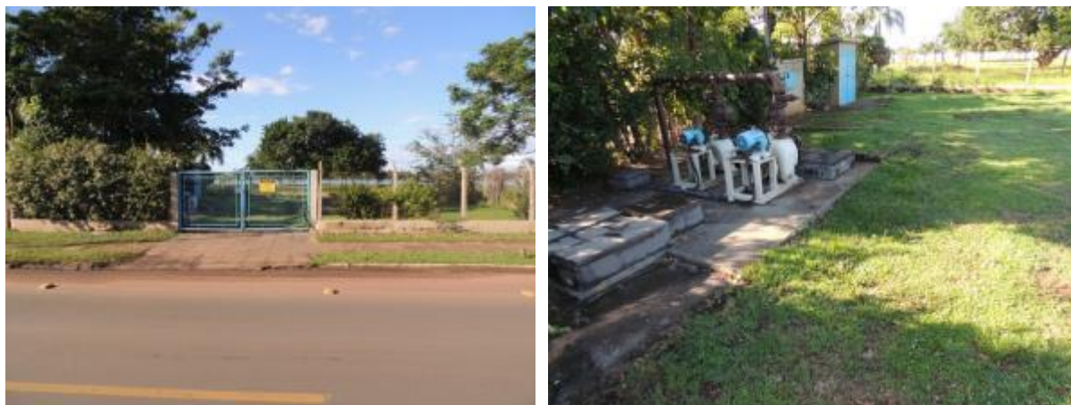
Figura 22: Vista geral da EEEB 005, Três Lagoas, MS.
