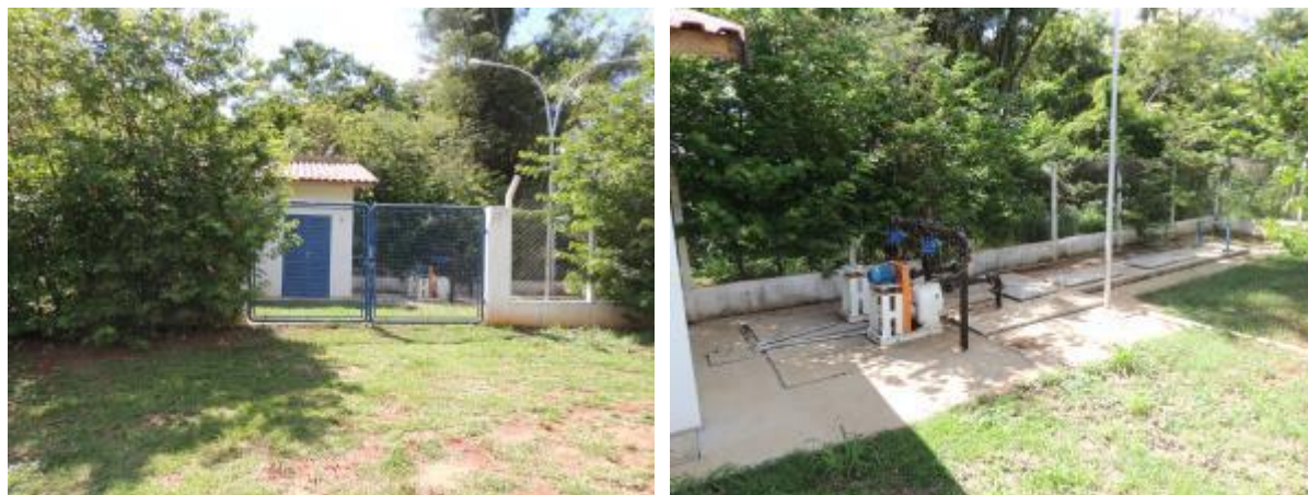
Figura 30: Vista geral da EEEB 014, Três Lagoas, MS.
