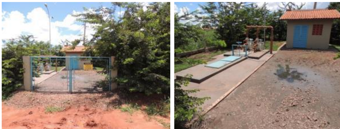
Figura 20: Vista geral da EEEB 003, Três Lagoas, MS.
