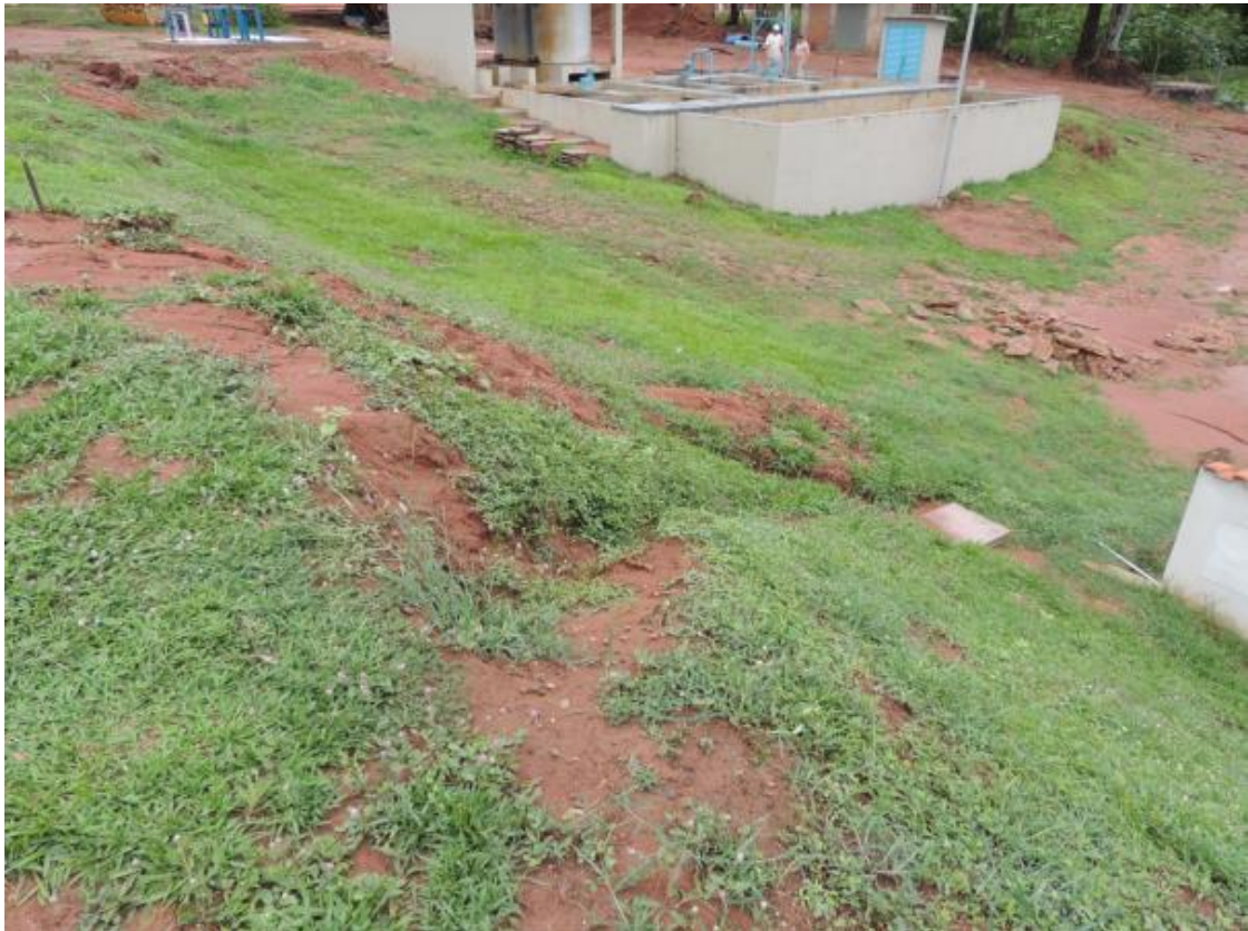
Figura 10: Processo erosivo próximo aos leitos de secagem do lodo, na ETE Planalto (São João), Três Lagoas, MS.
