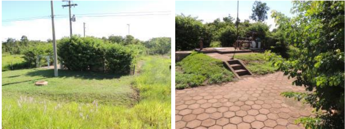
Figura 28: Vista geral da EEEB 012, Três Lagoas, MS.
