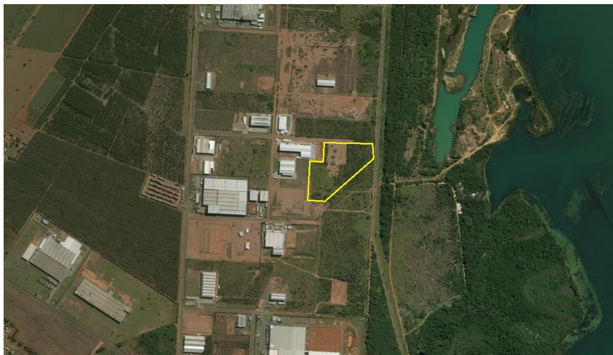
Figura 40: Acima: Vista aérea da ETE Souza Dias Projetada, Três Lagoas, MS.
