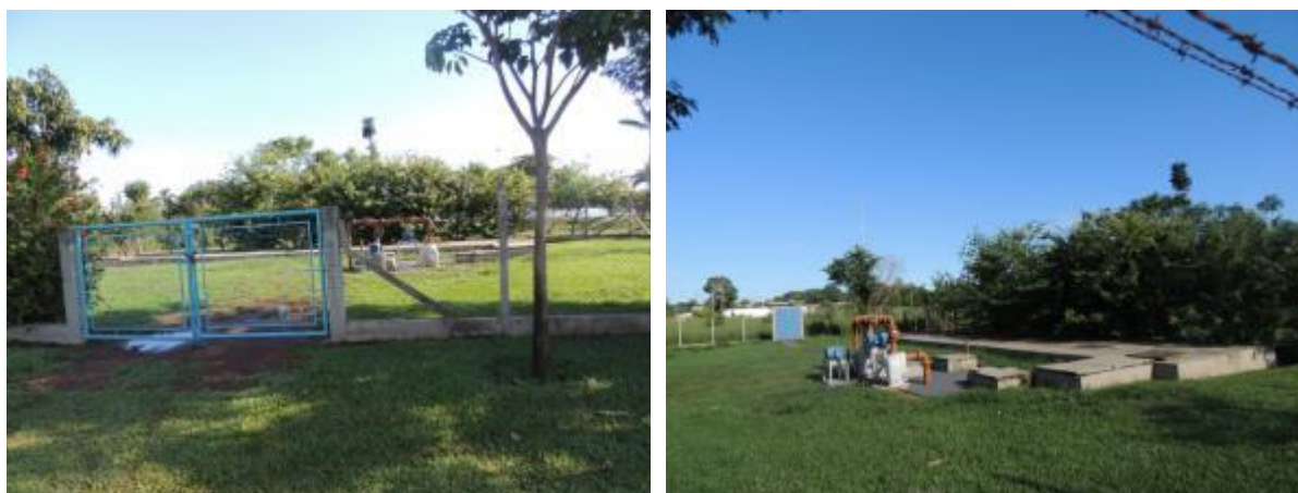
Figura 21: Vista geral da EEEB 004, Três Lagoas, MS.
