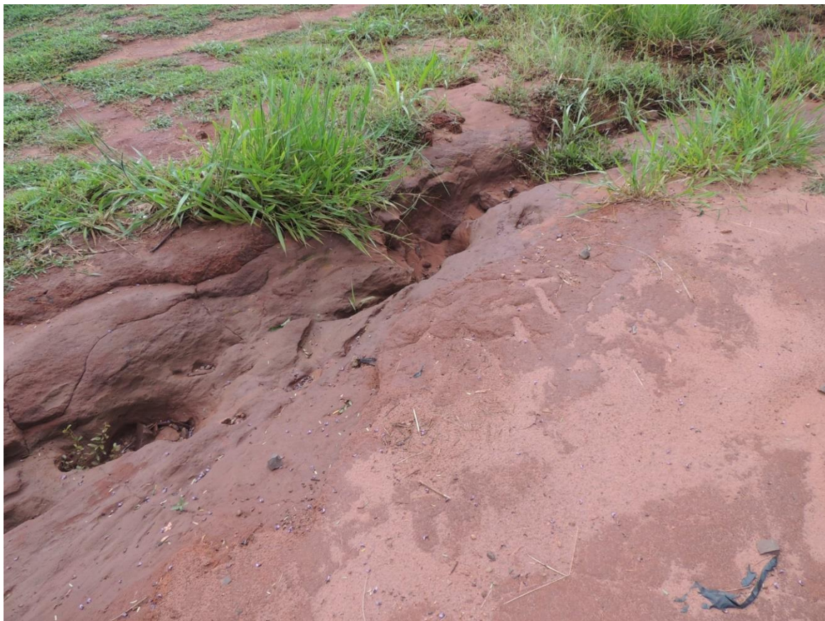
Figura 39: Processos erosivos no entorno da EEEB 021, Três Lagoas, MS.
