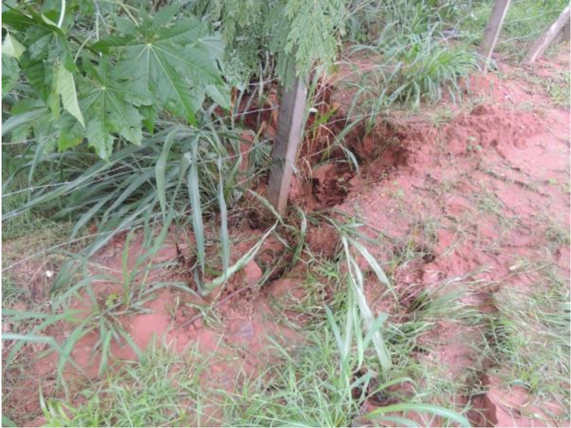
Figura 9: Processo erosivo na cerca da ETE Planalto (São João), Três Lagoas, MS.
