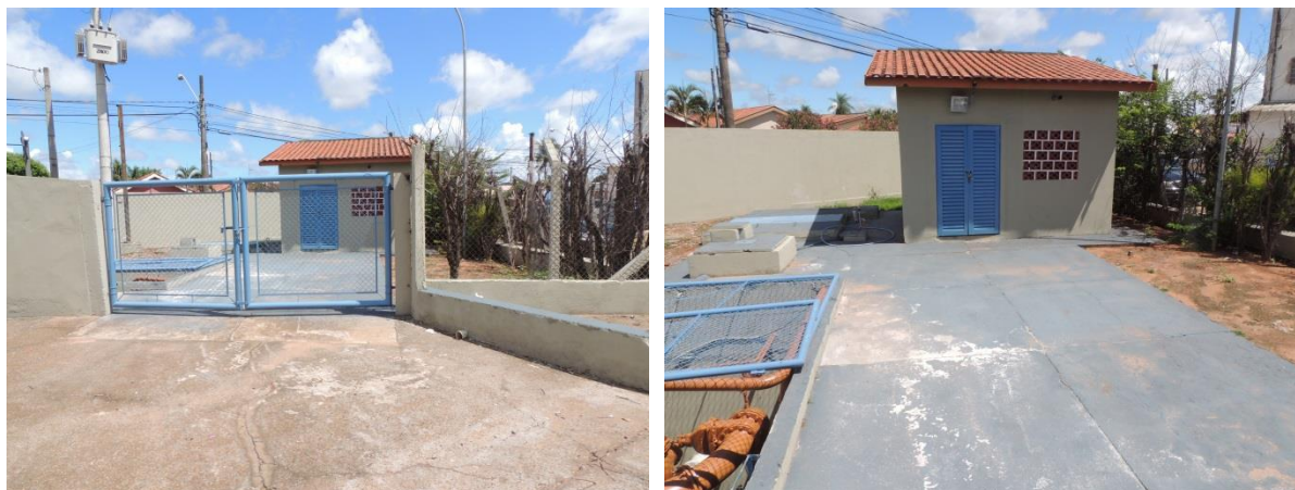
Figura 33: Vista geral da EEEB 017, Três Lagoas, MS.
