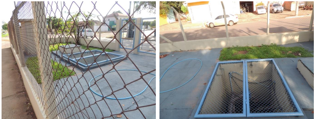
Figura 24: Vista geral da EEEB 007, Três Lagoas, MS.
