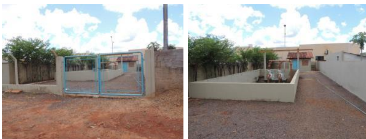
Figura 19: Vista geral da EEEB 002, Três Lagoas, MS.
