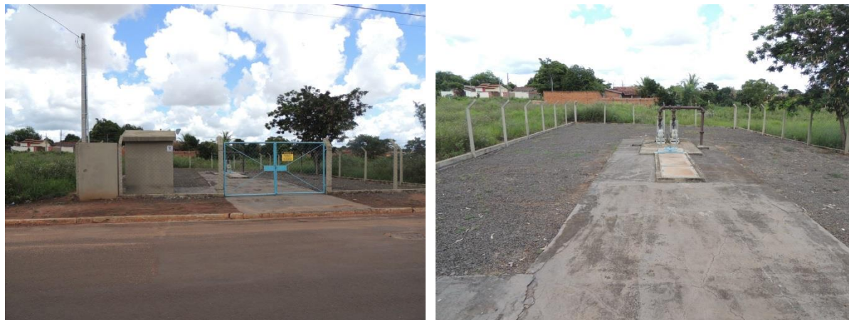
Figura 32: Vista geral da EEEB 016, Três Lagoas, MS.
