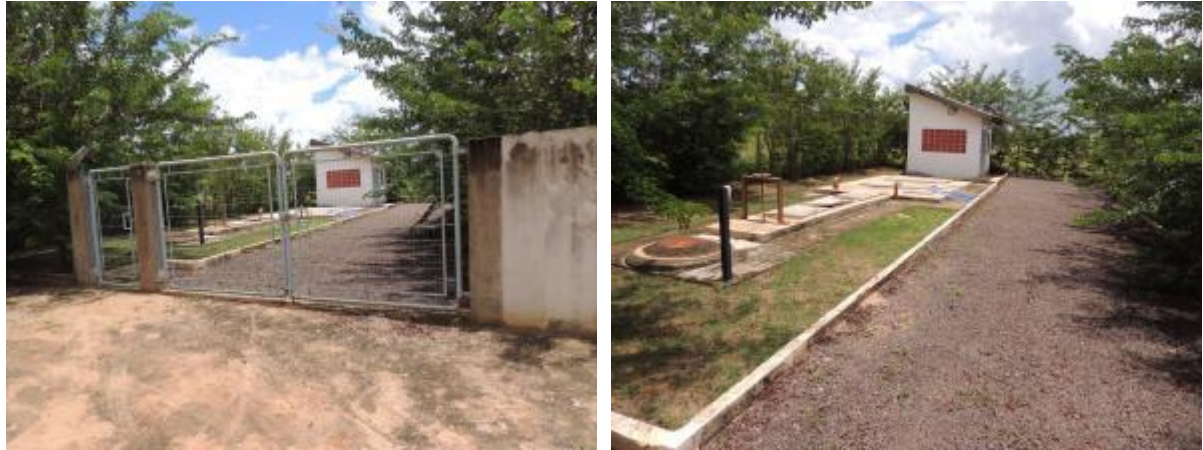
Figura 26: Vista geral da EEEB 010, Três Lagoas, MS.
