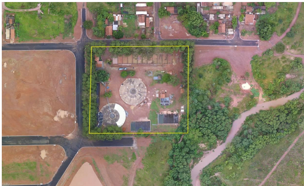
Figura 2: Vista aérea da ETE Planalto em ampliação, Três Lagoas, MS.
