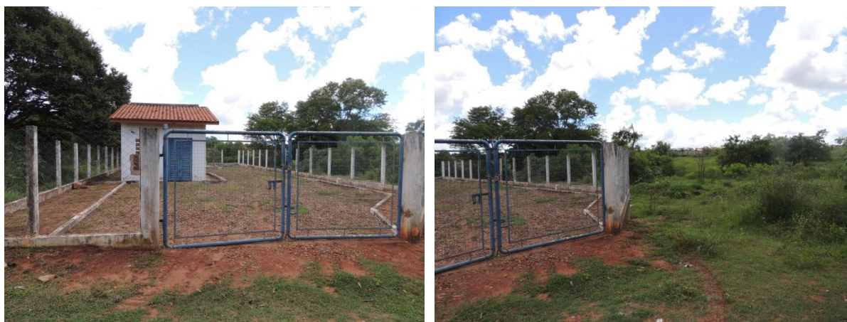
Figura 35: Vista geral da EEEB 018, Três Lagoas, MS.
