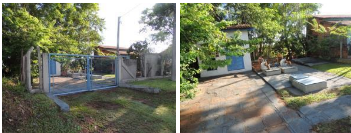
Figura 23: Vista geral da EEEB 006, Três Lagoas, MS.
