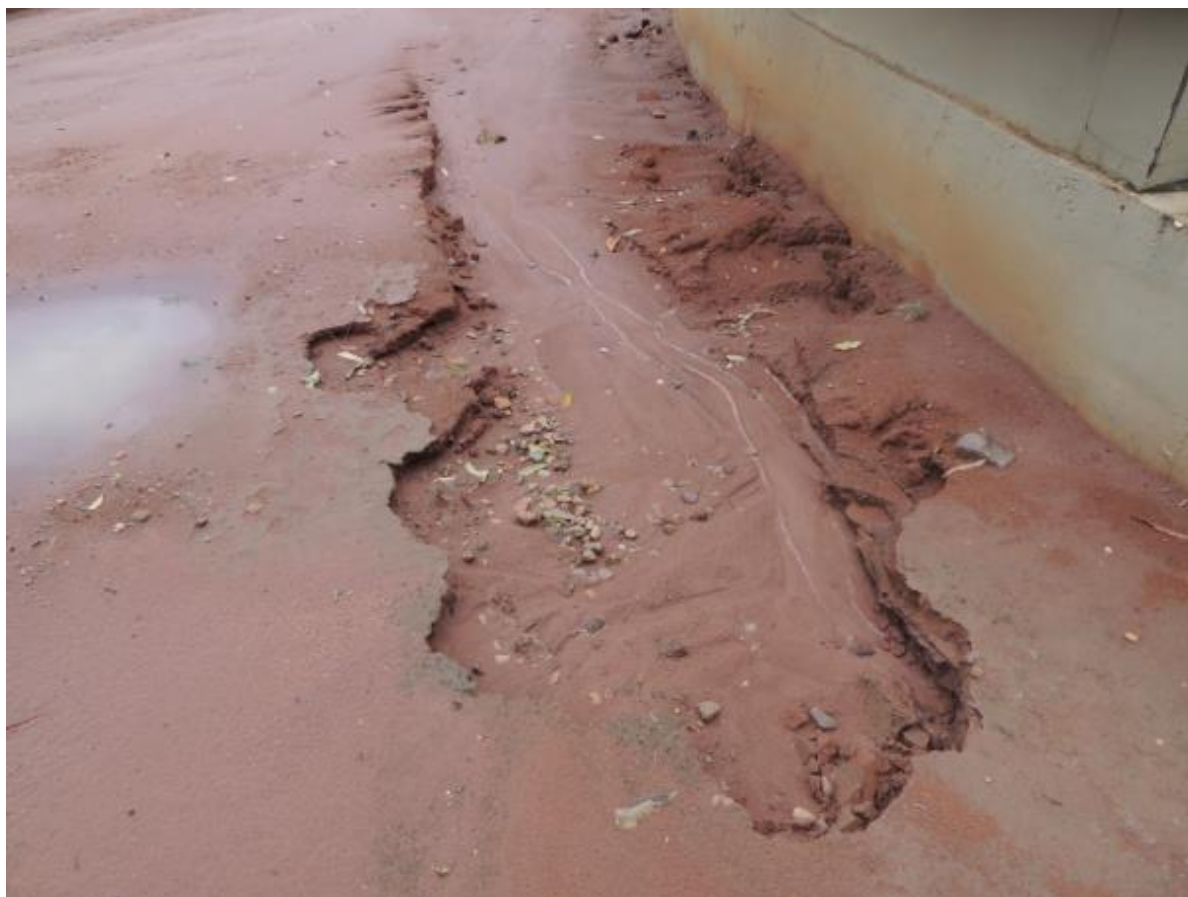
Figura 8: Início de processo erosivo próximo ao reator em operação, na ETE Planalto (São João), Três Lagoas, MS.
