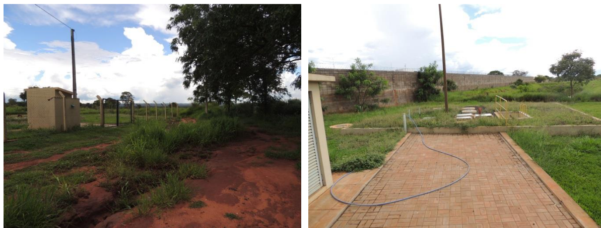
Figura 37: Vista geral da EEEB 021, Três Lagoas, MS.
