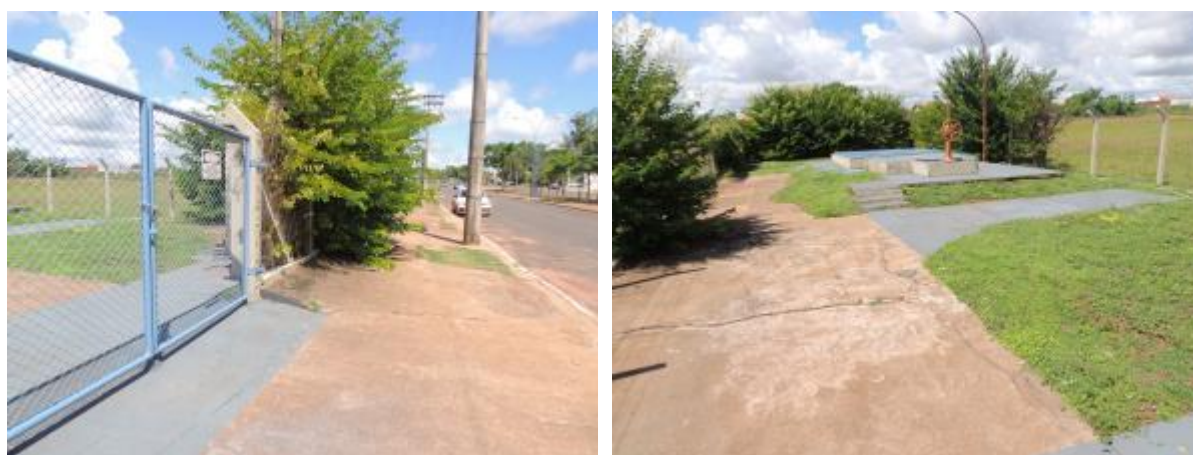
Figura 25: Vista geral da EEEB 009, Três Lagoas, MS.
