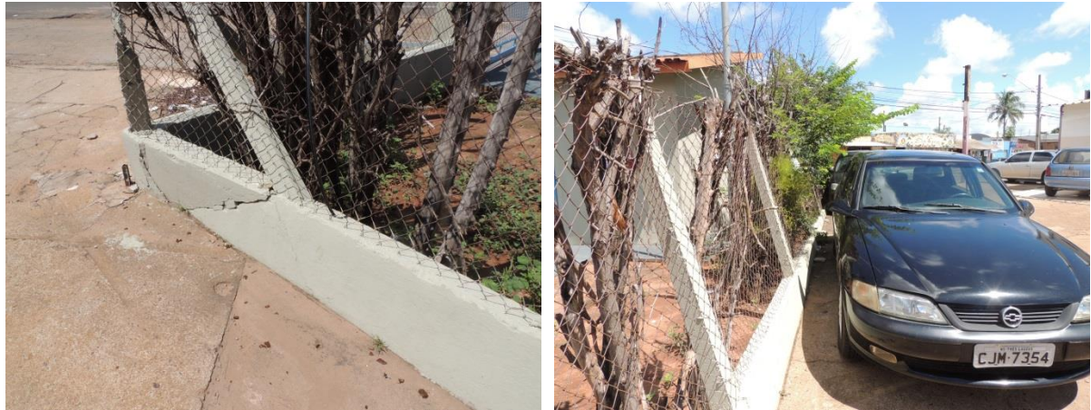
Figura 34: Danos na cerca da EEEB 017, Três Lagoas, MS.
