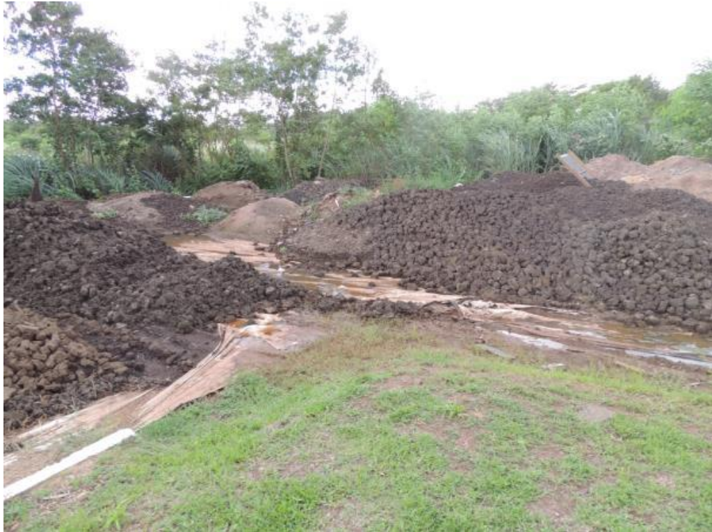
Figura 16: Acondicionamento de lodo seco, exposto, no interior da ETE Jupιά, Três Lagoas, MS.
