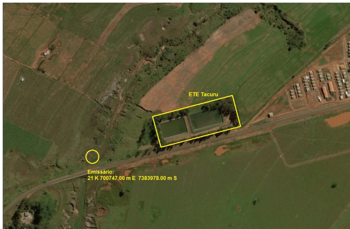
Figura 3: Vista aérea da ETE Tacuru e entorno, Tacuru, MS.
