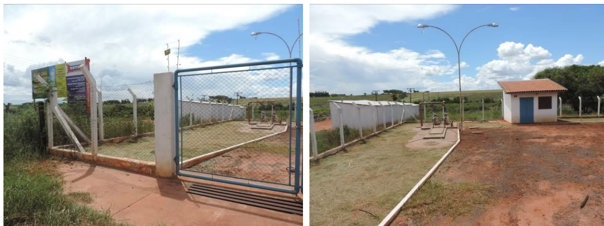
Figura 7: Vista geral da EEEB 002, Tacuru, MS.
