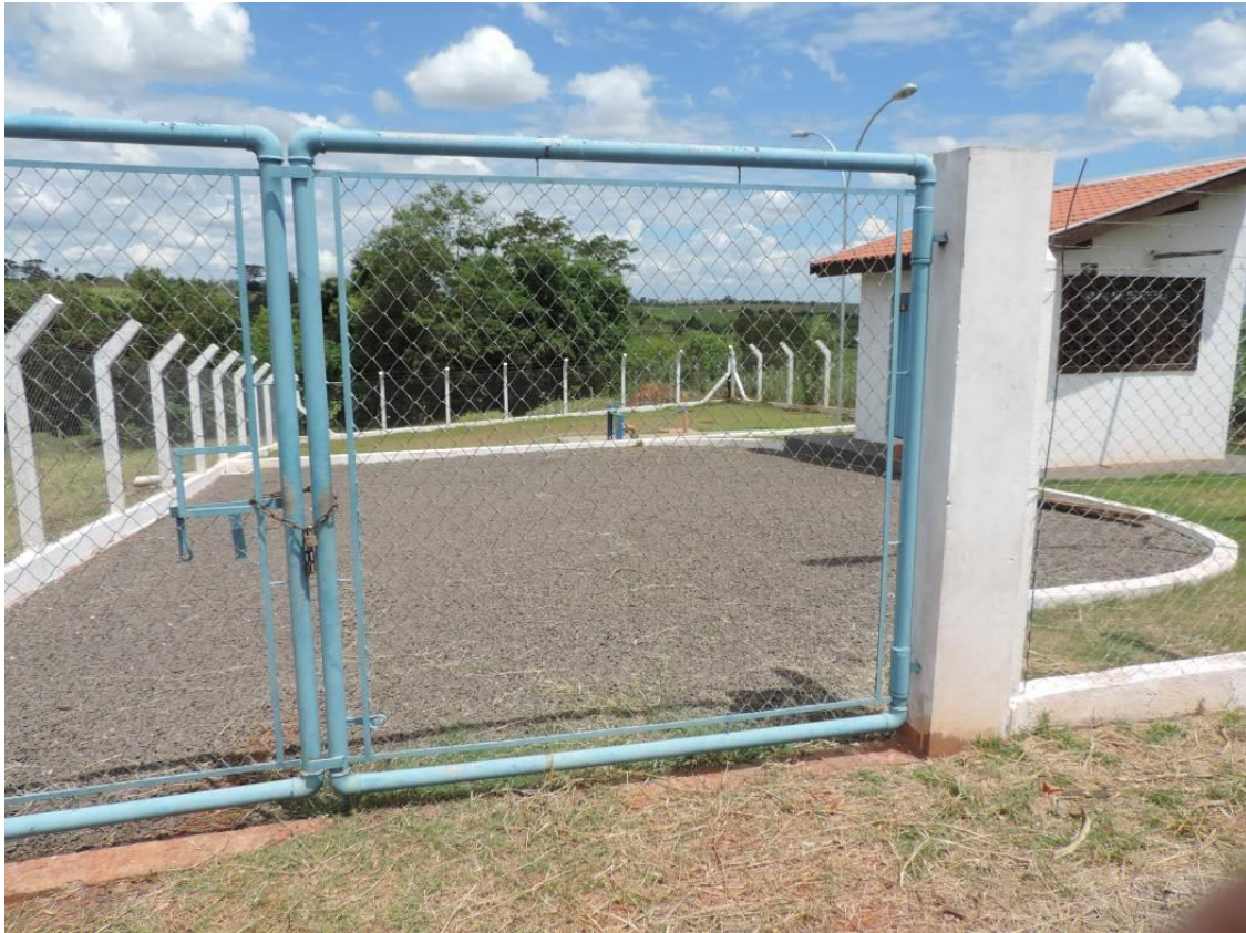
Figura 6: Vista geral da EEEB 001, Tacuru, MS.
