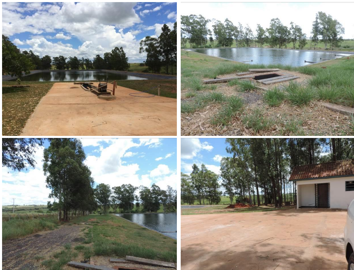
Figura 2: Vista geral da ETE Tacuru, Tacuru, MS.
