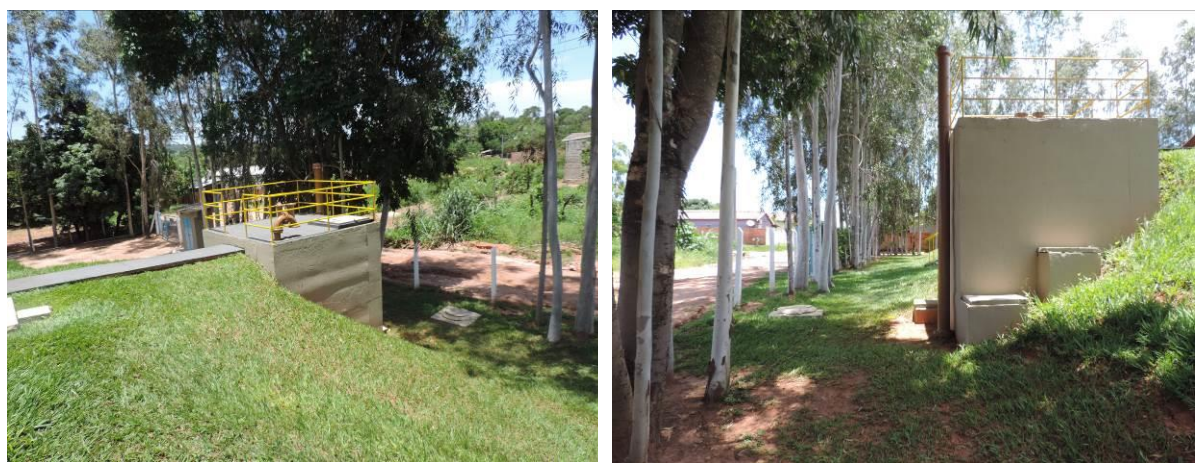
Figura 6: Vista geral da EEET ETE Rio Verde, Rio Verde de Mato Grosso, MS.
