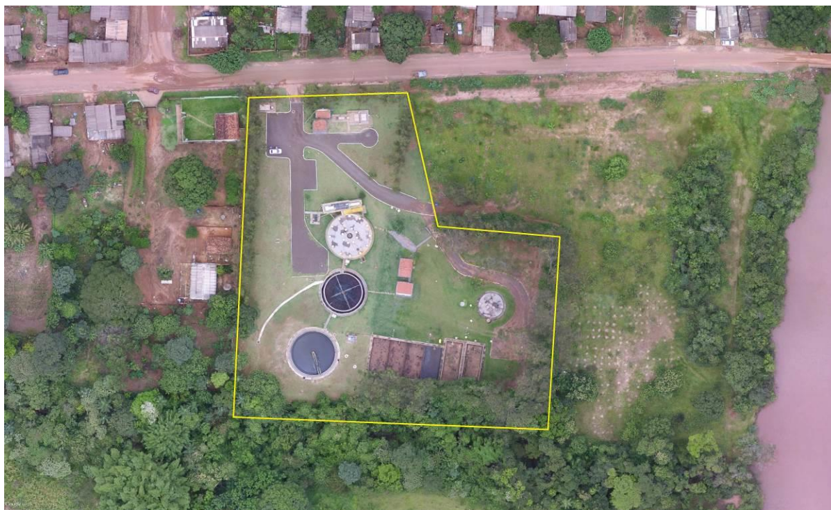
Figura 2: Vista aérea da ETE Ribas do Rio Pardo, Ribas do Rio Pardo, MS.
