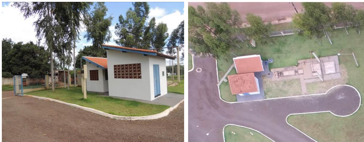
Figura 6: Vista geral da ETEB Final, Ribas do Rio Pardo, MS.
