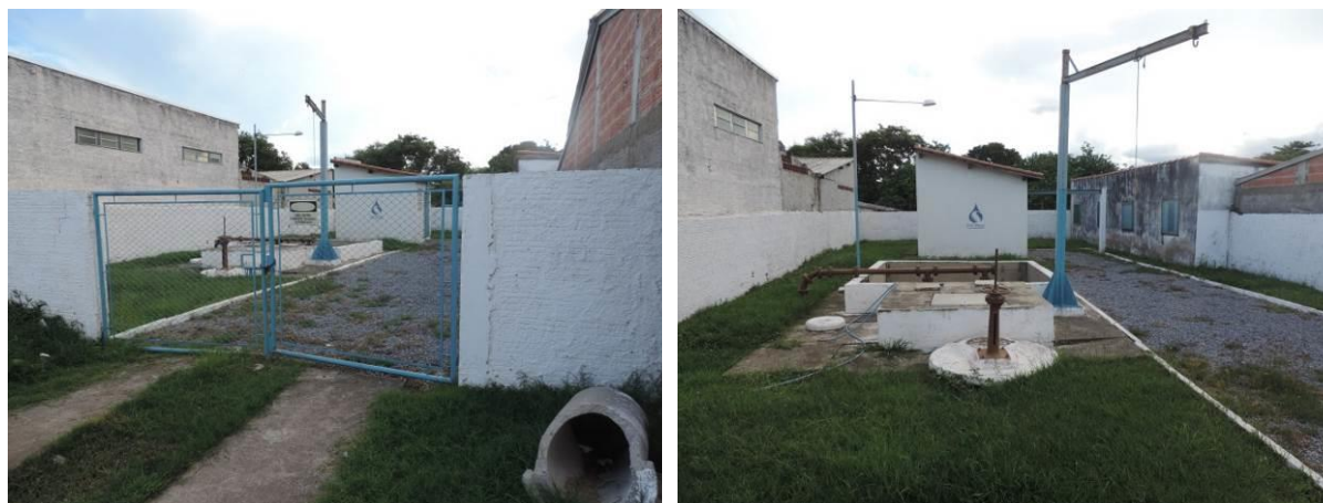
Figura 8: Vista geral da EEEB 003, Porto Murtinho, MS.
