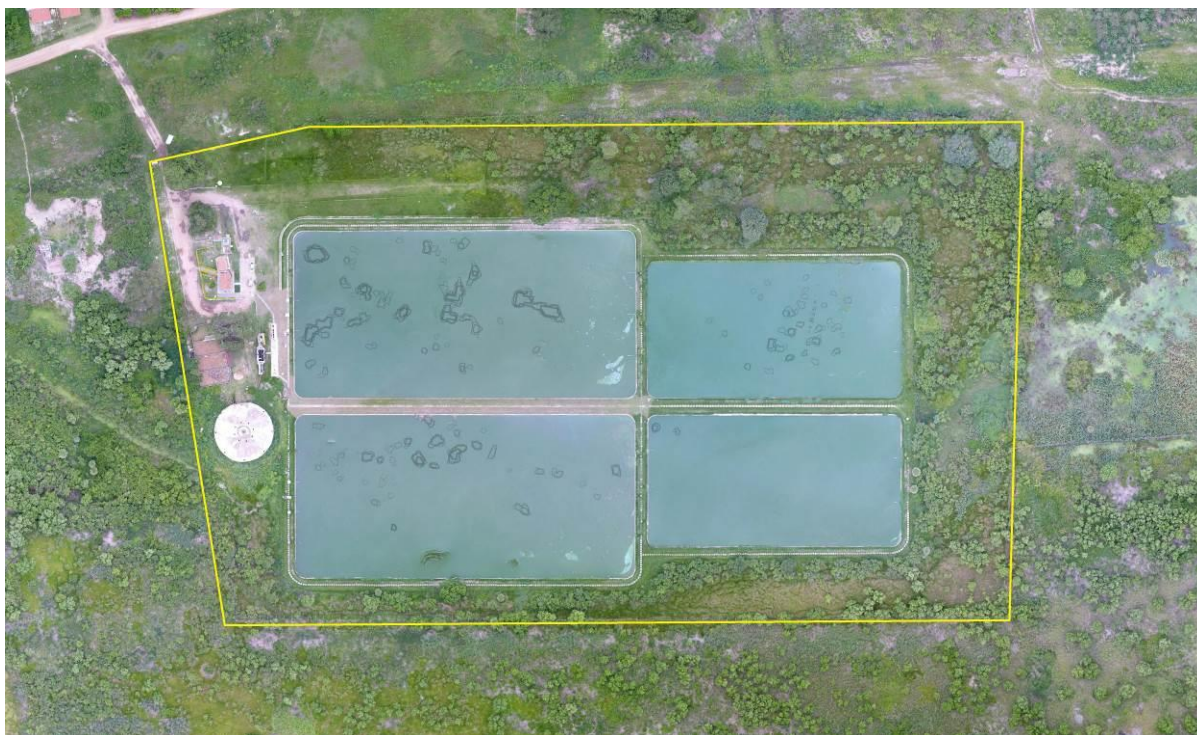
Figura 2: Vista aérea da ETE Porto Murtinho, Porto Murtinho, MS.
