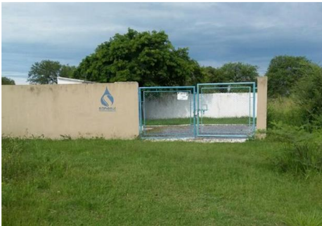
Figura 12: Vista geral da EEEB 007, Porto Murtinho, MS.
