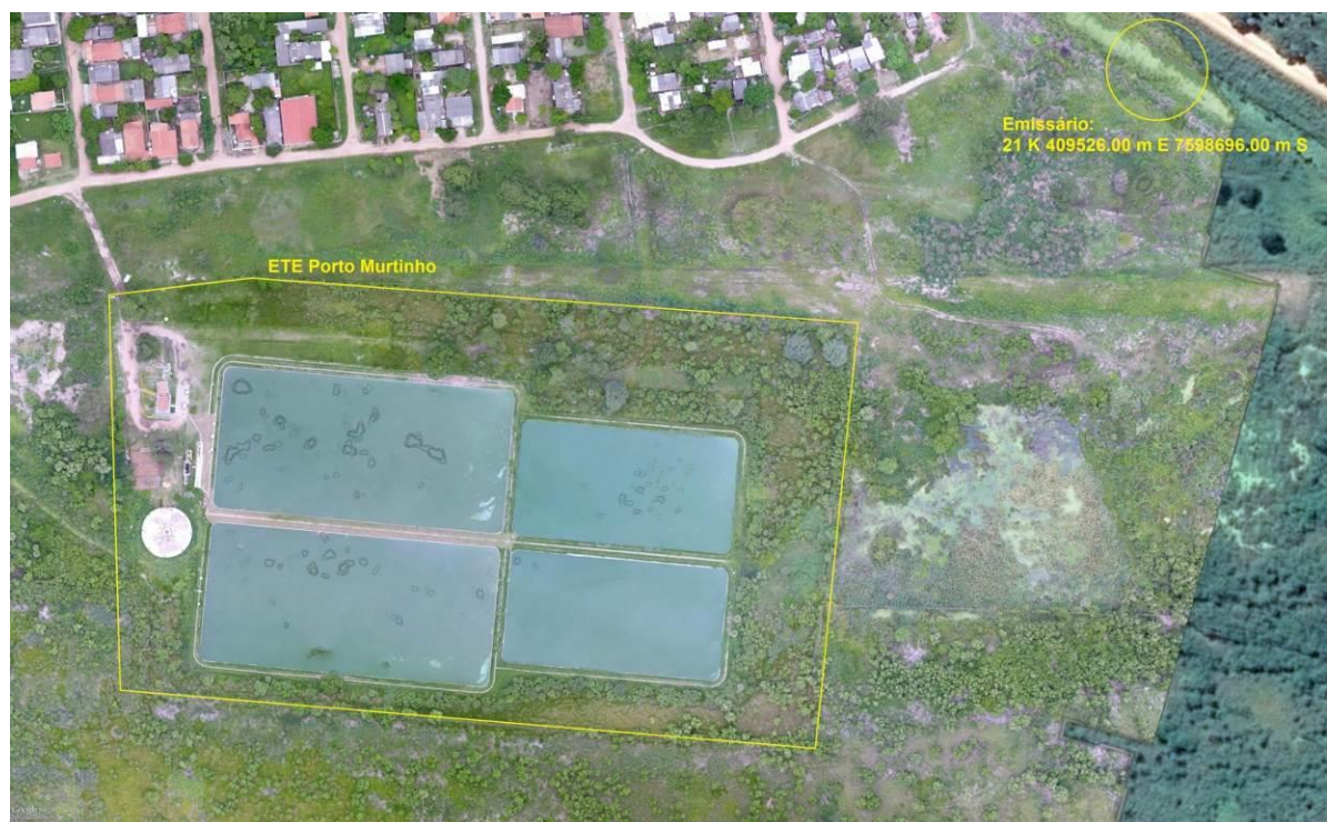
Figura 3: Vista aérea da ETE Porto Murtinho e entorno, Porto Murtinho, MS.
