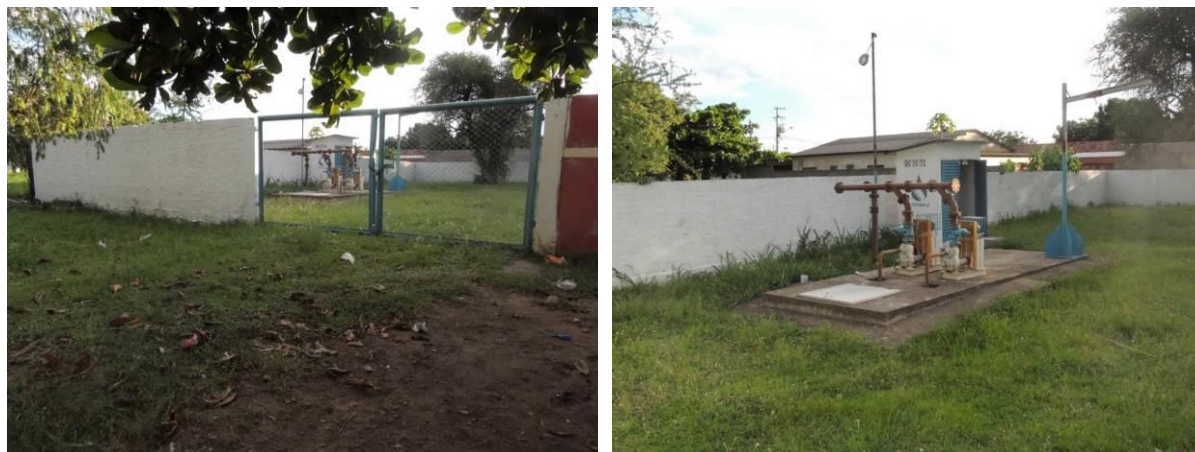
Figura 9: Vista geral da EEEB 004, Porto Murtinho, MS.
