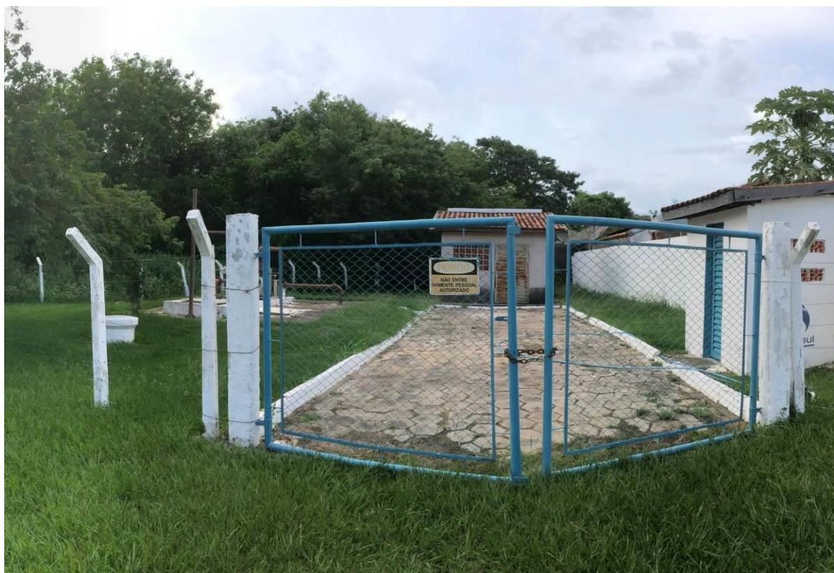
Figura 10: Vista geral da EEEB 005, Porto Murtinho, MS.
