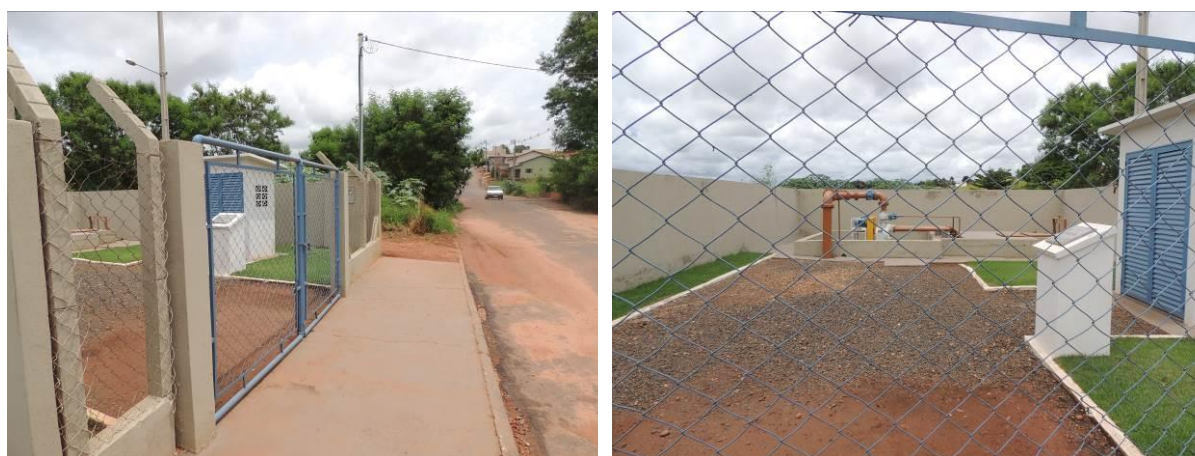
Figura 5: Vista geral da EEEB 01, Paranaíba, MS.
