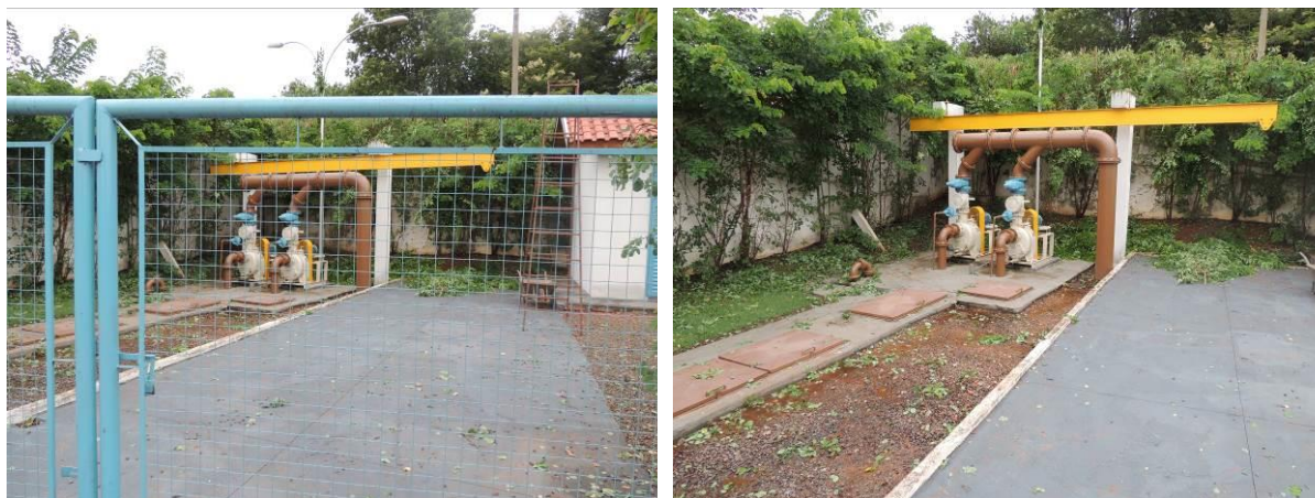
Figura 7: Vista geral da EEEB 03, Paranaíba, MS.
