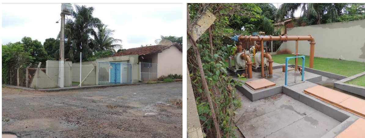
Figura 6: Vista geral da EEEB 002, Paranaíba, MS.
