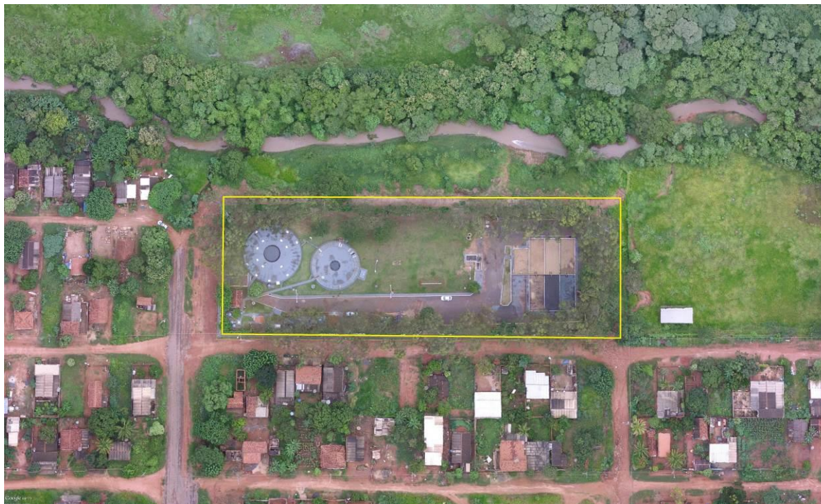
Figura 2: Vista aérea da ETE Paranaíba, Paranaíba, MS.
