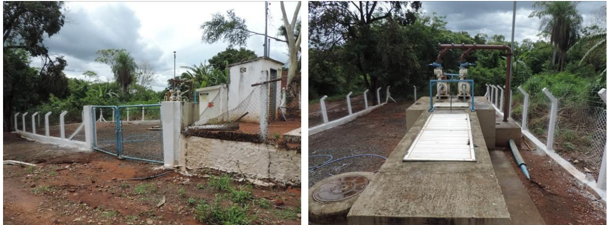
Figura 8: Vista geral da EEEB 009, Nioaque, MS.
