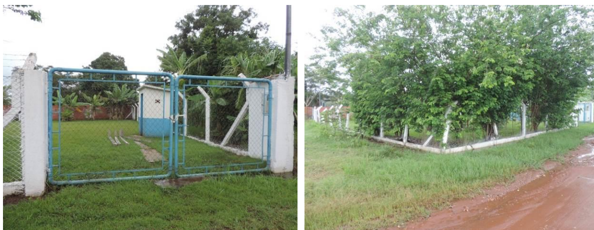
Figura 7: Vista geral da EEEB 006, Nioaque, MS.
