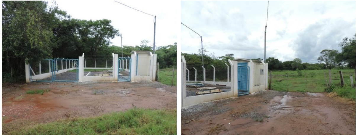
Figura 6: Vista geral da EEEB 005, Nioaque, MS.
