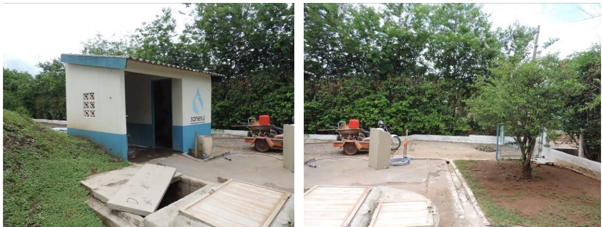
Figura 5: Vista geral da EEEB 004, Nioaque, MS.
