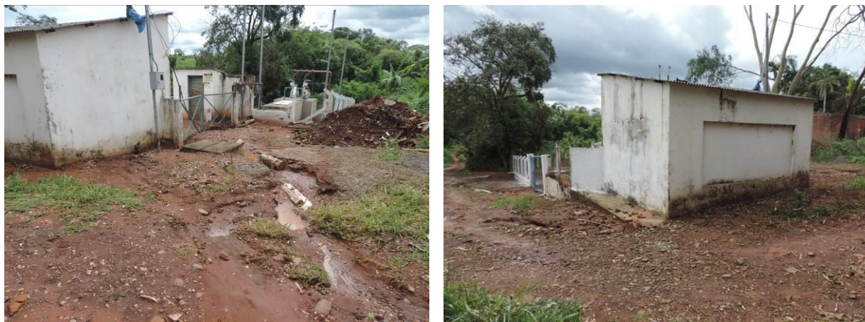
Figura 9: Vista geral do entorno da EEEB 009 mostrando o início do processo erosivo, Nioaque, MS.
