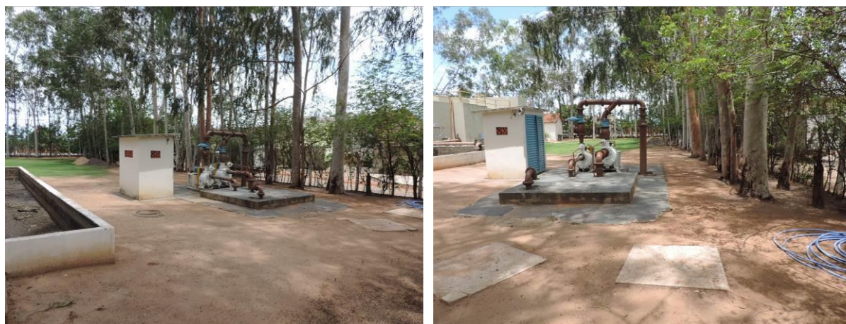
Figura 12: Vista geral da EEET ETE 02, Miranda, MS.
