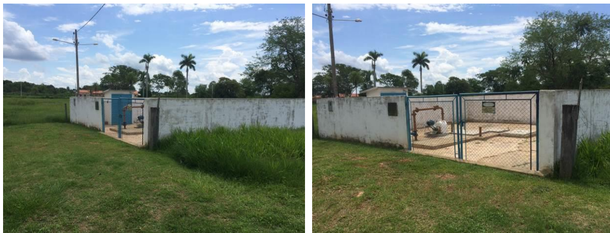
Figura 10: Vista geral da EEEB 005, Miranda, MS.
