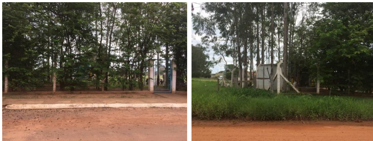
Figura 9: Vista geral da EEEB 001, Miranda, MS.
