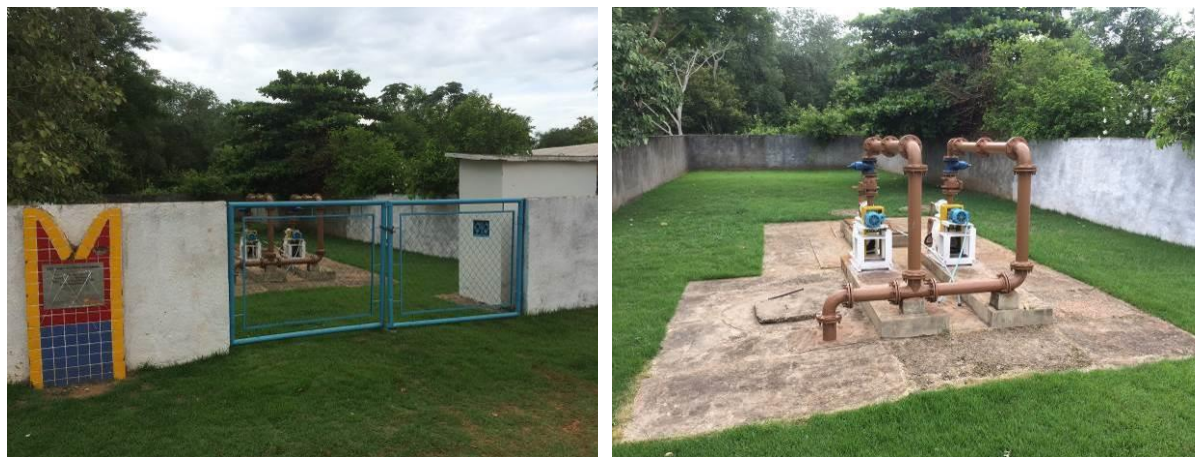
Figura 8: Vista geral da EEEB 002, Miranda, MS.
