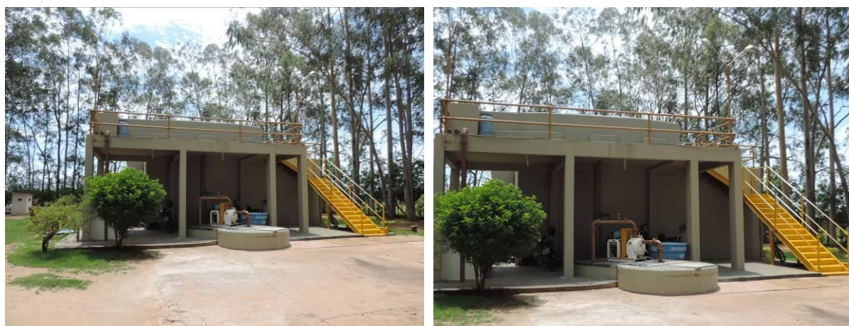
Figura 11: Vista geral da EEEB ETE 01, Miranda, MS.
