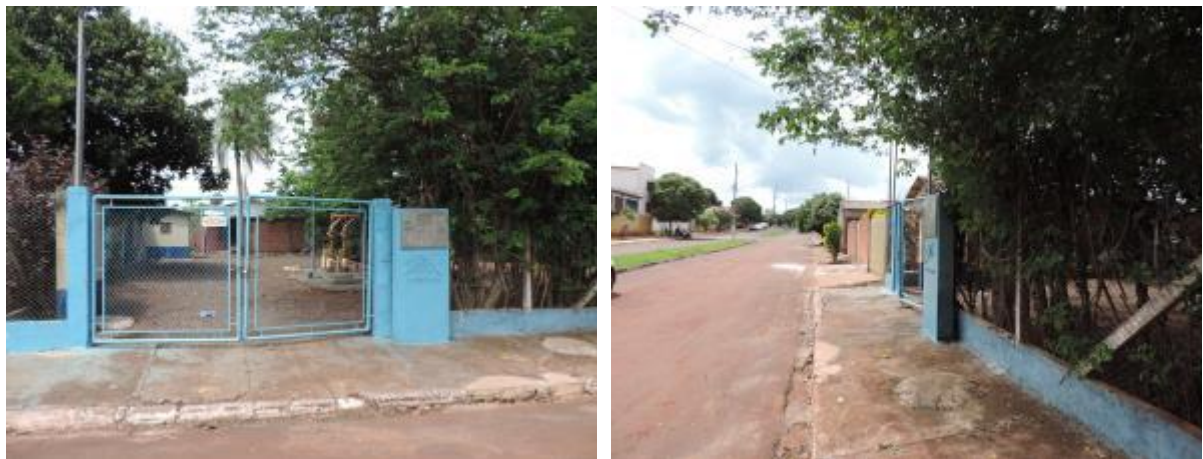
Figura 6: Vista geral da EEEB 002, Maracaju, MS.
