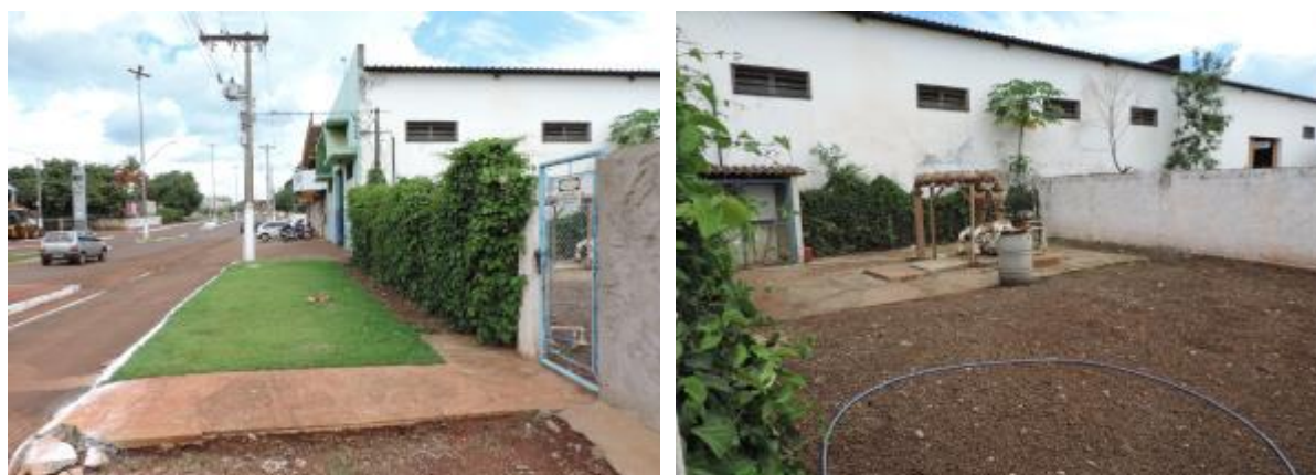
Figura 5: Vista geral da EEEB 001, Maracaju, MS.
