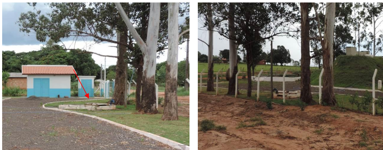
Figura 7: Vista geral da EEEB Final, Juti, MS.
