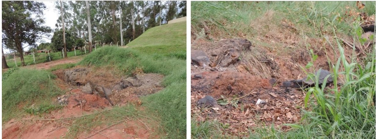
Figura 6: Vala com restos de resíduos sólidos na área da ETE Juti, Juti, MS.
