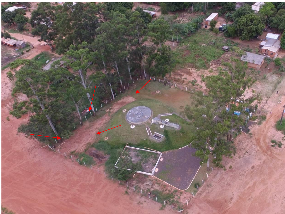
Figura 5: Solo exposto na área da ETE Juti, Juti, MS.
