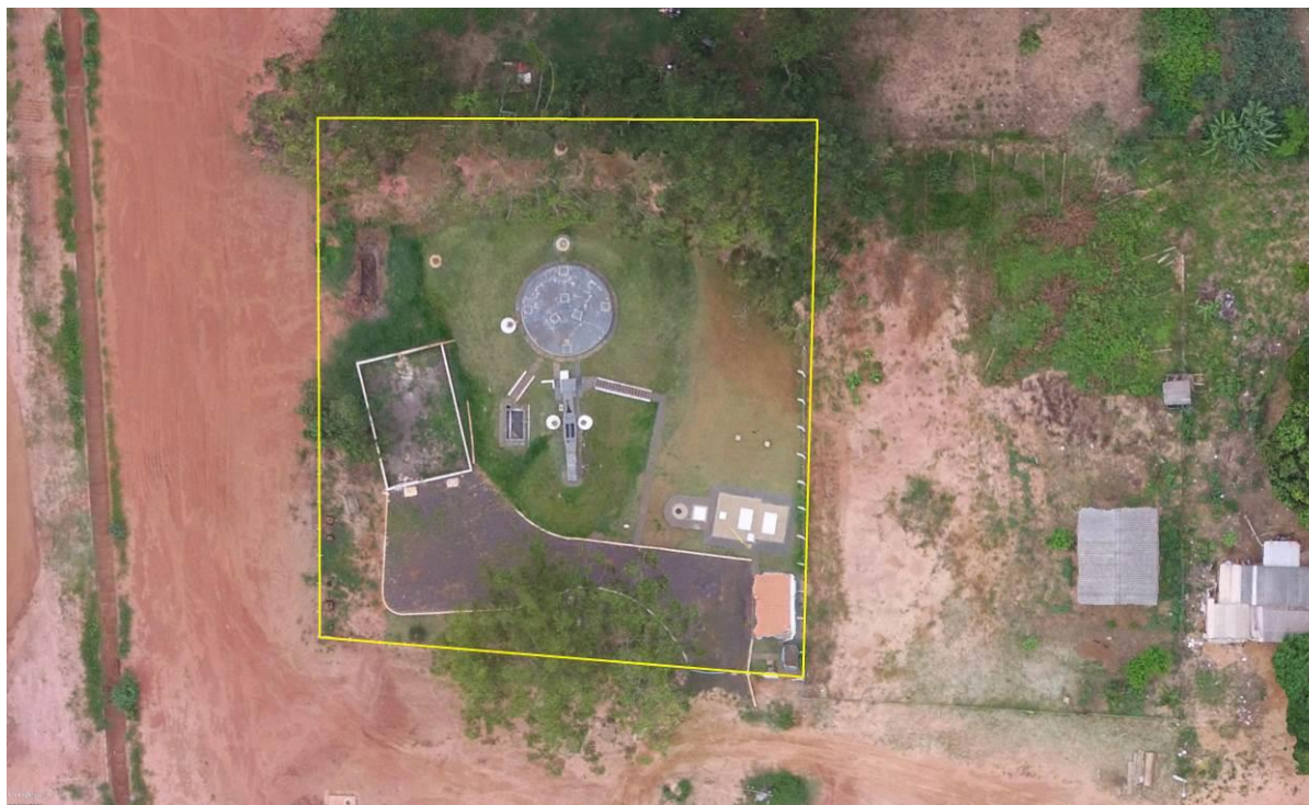
Figura 2: Vista aérea da ETE Juti, Juti, MS.
