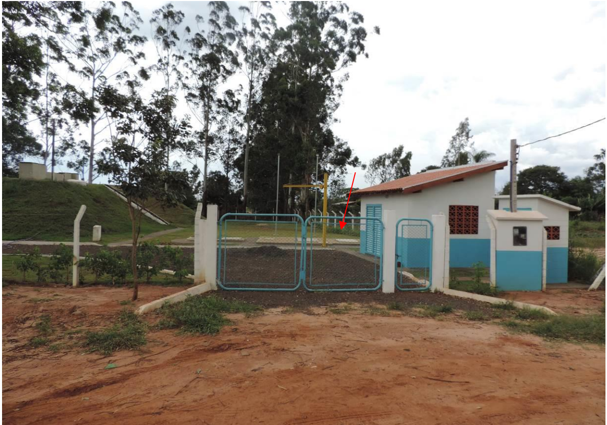
Figura 8: Vista geral da EEET, Juti, MS.
