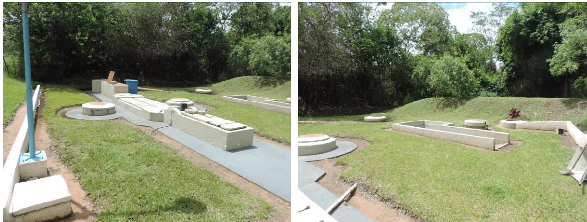
Figura 8: Vista geral da EEEB Cachoeirinha, Jardim, MS.
