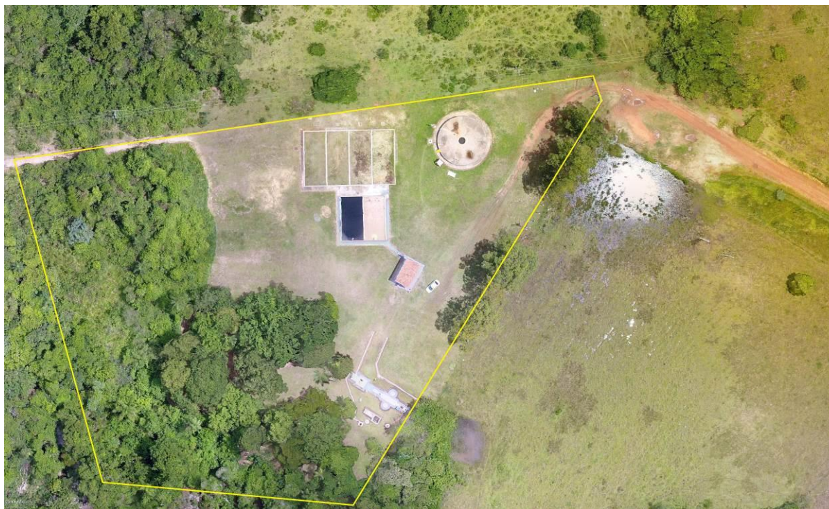
Figura 2: Vista aérea da ETE Cachoeirinha, Jardim, MS.
