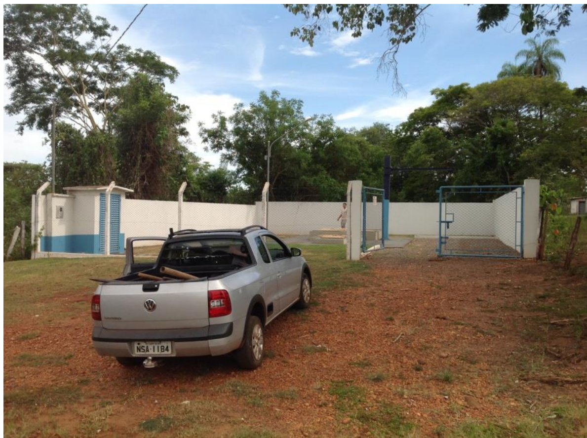
Figura 10: Vista geral da EEEB Centro, Jardim, MS.
