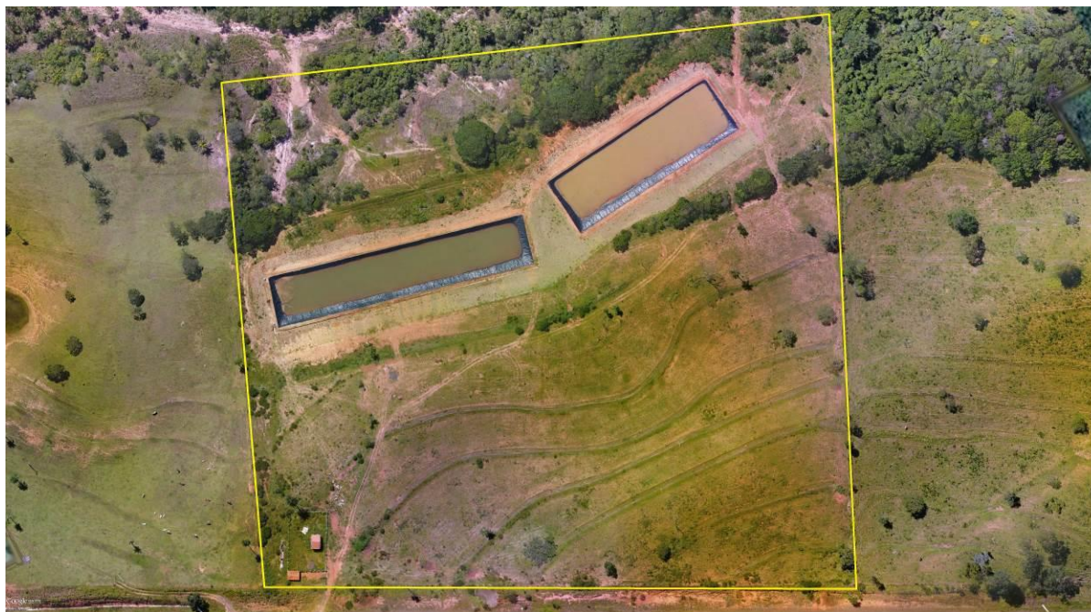
Figura 2: Vista aérea da ETE Figueirão, Figueirão, MS.
