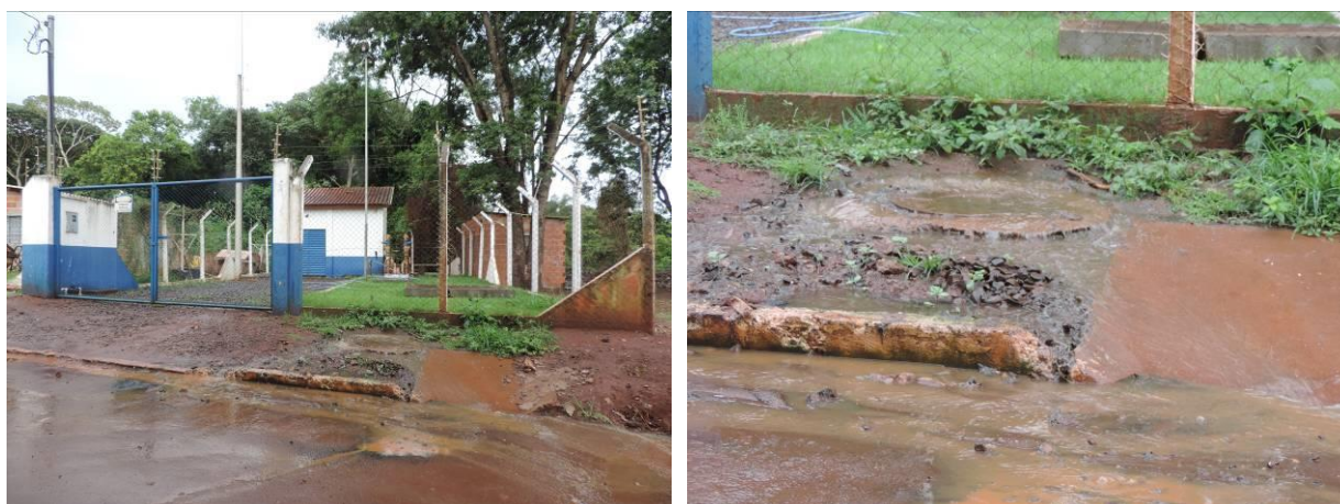
Figura 24: Alagamento EEEB Estrela Porã, Dourados, MS.
