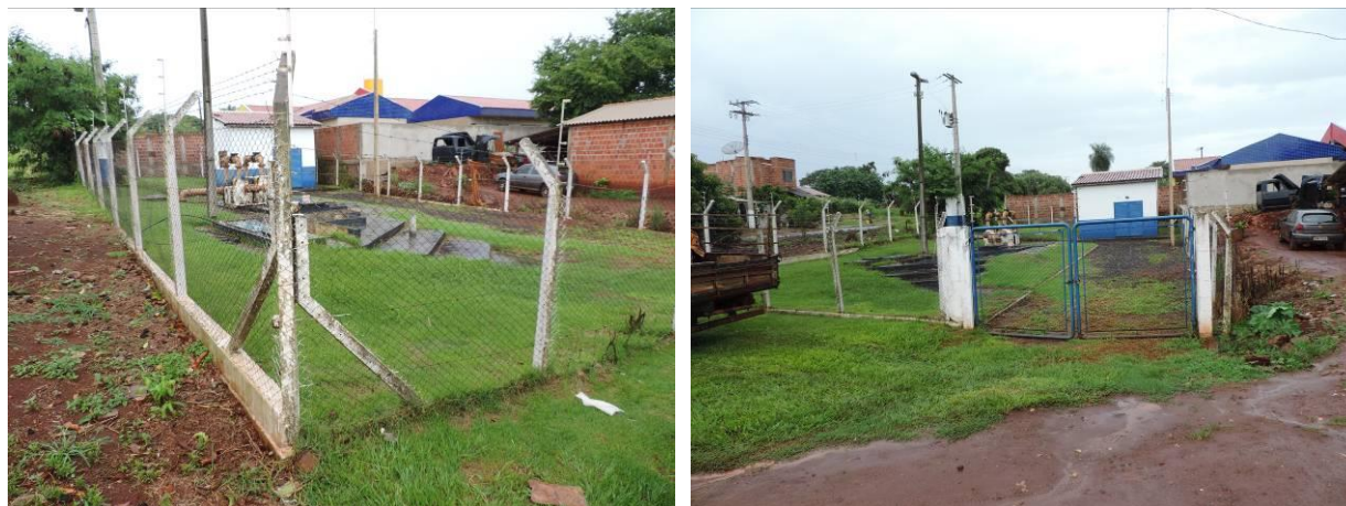
Figura 29: Vista geral da EEEB Olinda Pires, Dourados, MS.
