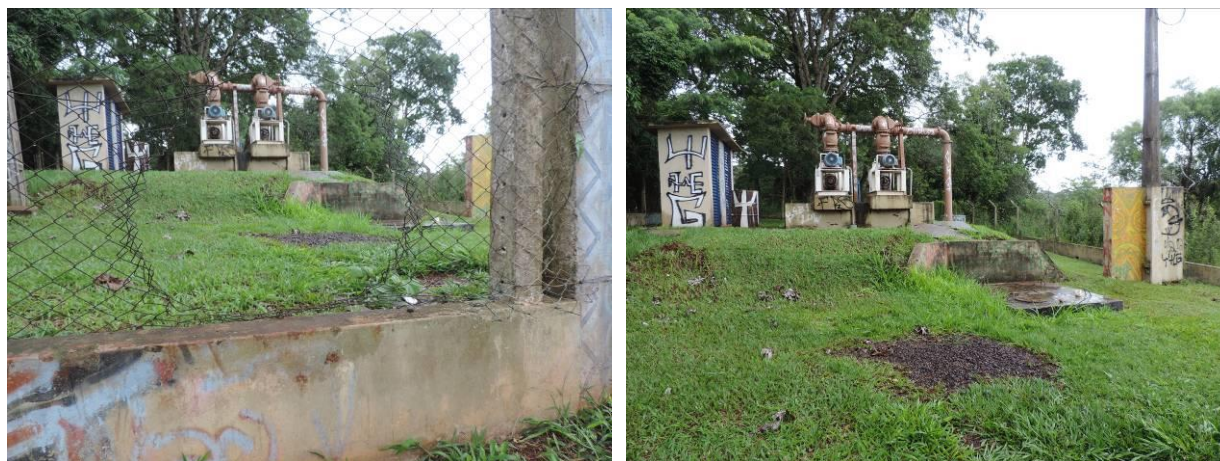
Figura 30: Vista geral da EEEB Portal de Dourados, Dourados, MS.
