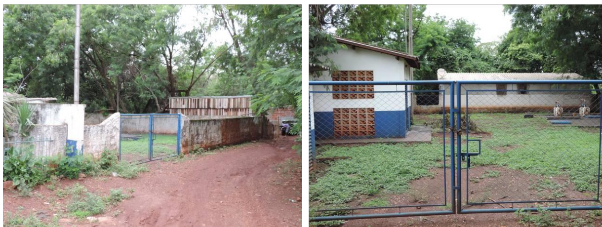
Figura 21: Vista geral da EEEB Campo Dourado, Dourados, MS.
