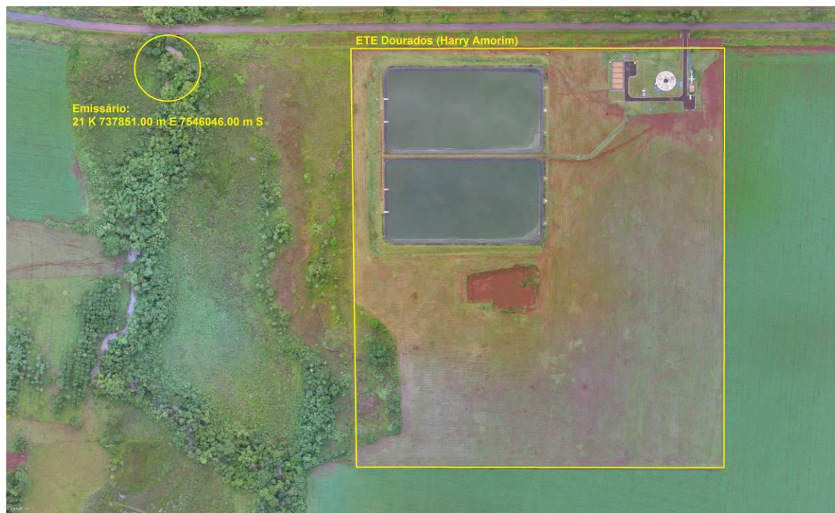
Figura 10: Vista aérea da ETE Harry Amorim Costa e entorno, Dourados, MS.
