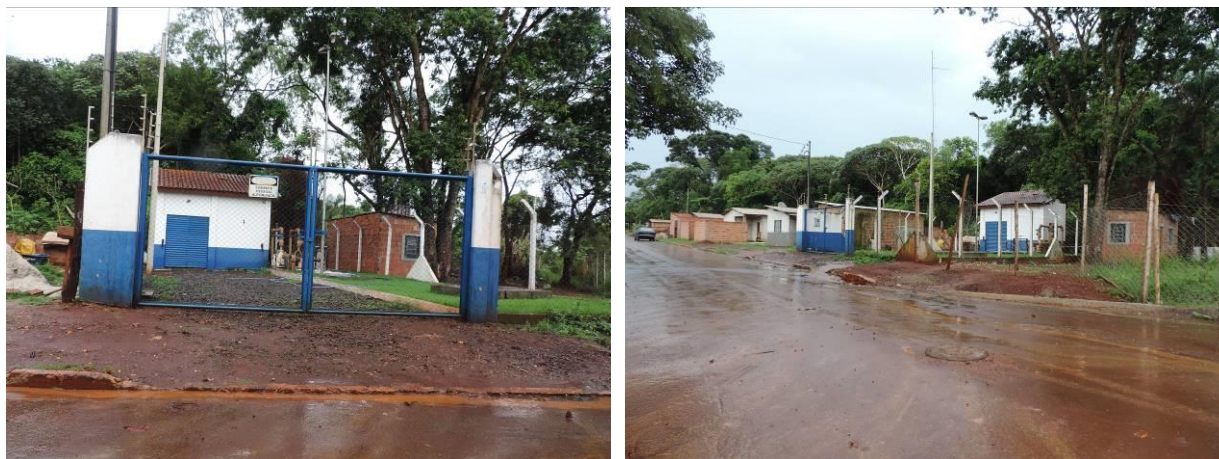
Figura 23: Vista geral da EEEB Estrela Porã, Dourados, MS.
