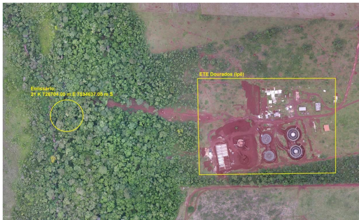
Figura 16: Vista aérea da ETE Ipê em implantação e entorno, Dourados, MS.
