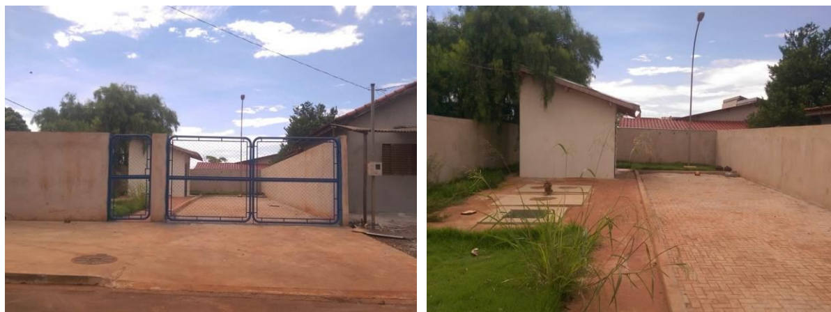
Figura 5: Vista geral da EEEB 001, Douradina, MS.
