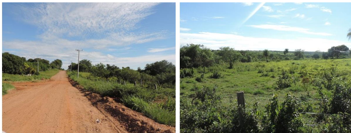
Figura 5: Vista geral da área onde será instalada a EEEB 001 Projetada, Caracol, MS.
