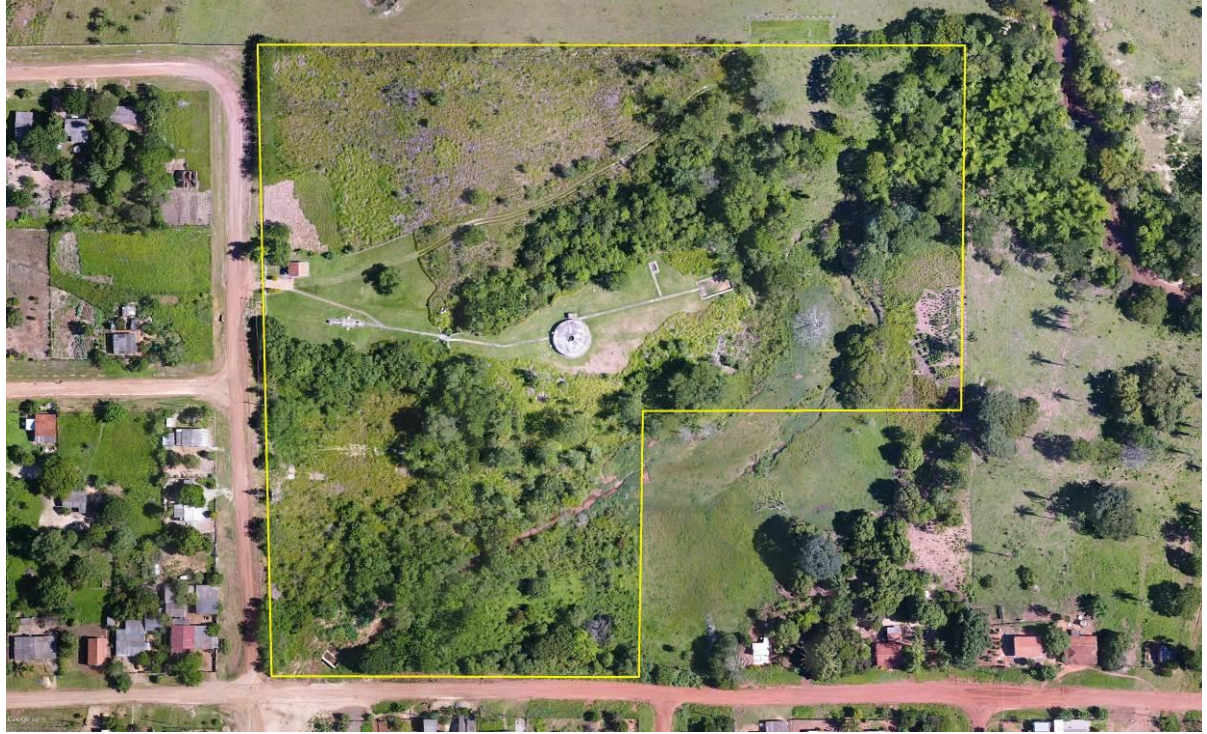
Figura 2: Vista aérea da ETE Caracol, Caracol, MS.
