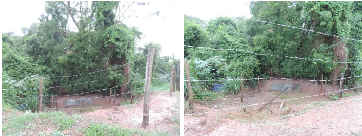
Figura 7: Vista geral da EEEB 03 (Futura EEEB 04), Camapuã, MS.
