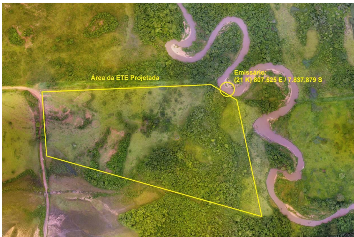
Figura 9: Vista aérea da ETE Camapuã I Projetada, Camapuã, MS.
