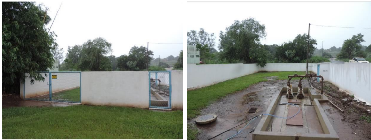
Figura 5: Vista geral da EEEB 01 (Futura EEEB 07), Camapuã, MS.
