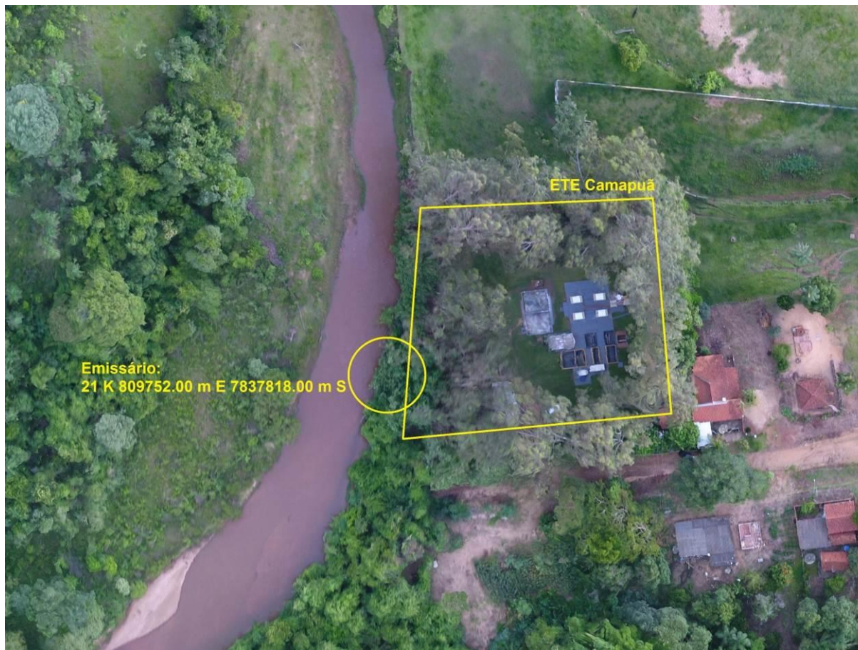
Figura 3: Vista aérea da ETE Camapuã e entorno, Camapuã, MS.
