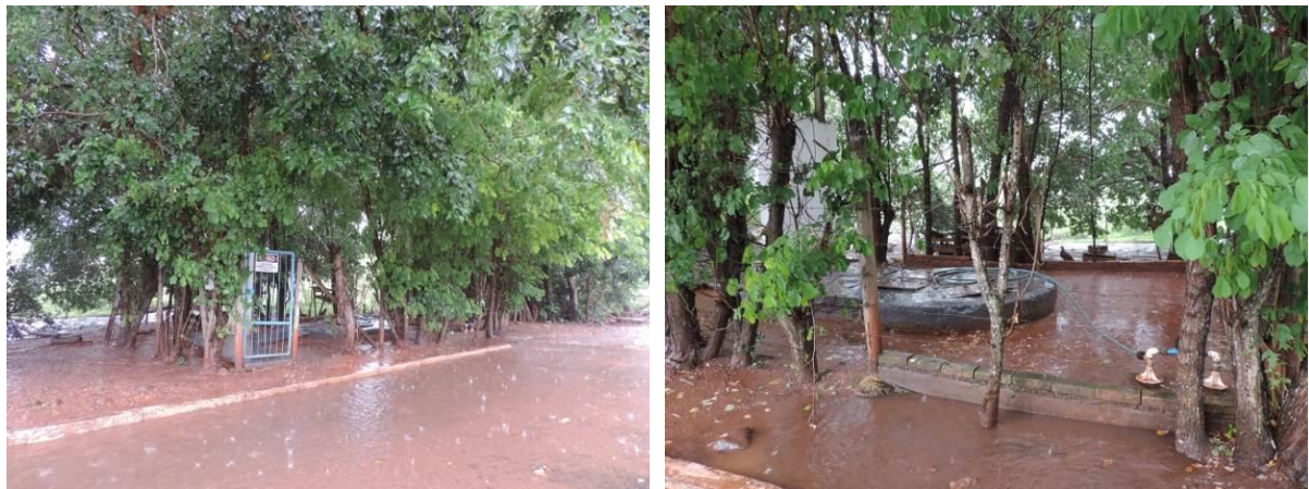
Figura 6: Vista geral da EEEB 02 (Futura EEEB 08), Camapuã, MS.
