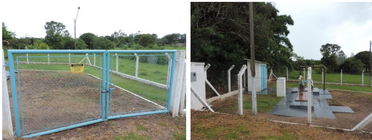
Figura 8: Vista geral da EEEB 04 (Futura EEEB 06), Camapuã, MS.
