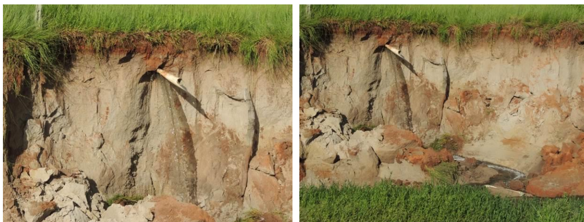
Figura 5: As imagens apresentam o emissário da ETE Brasilândia.
