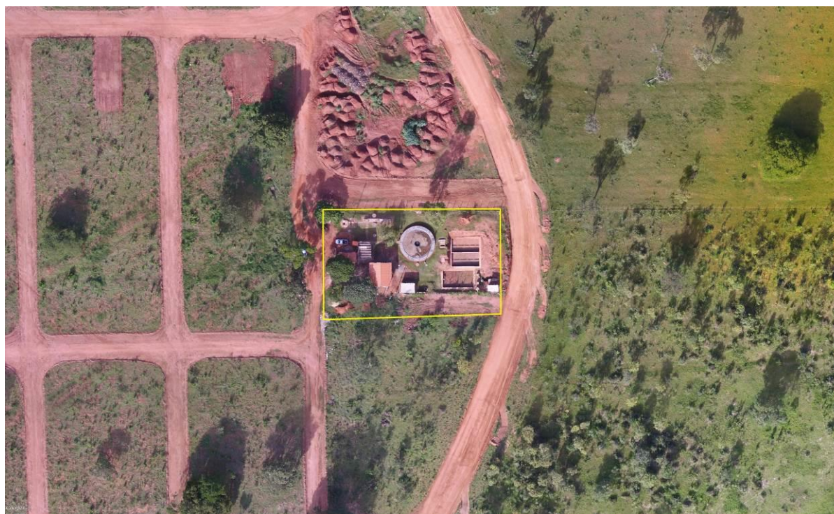
Figura 2: Vista aérea da ETE Brasilândia, Brasilândia, MS.
