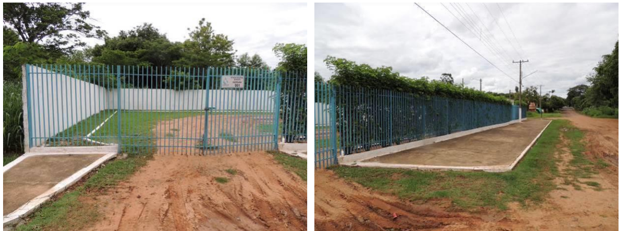
Figura 5: Vista geral da EEEB 001, Aquidauana, MS.
