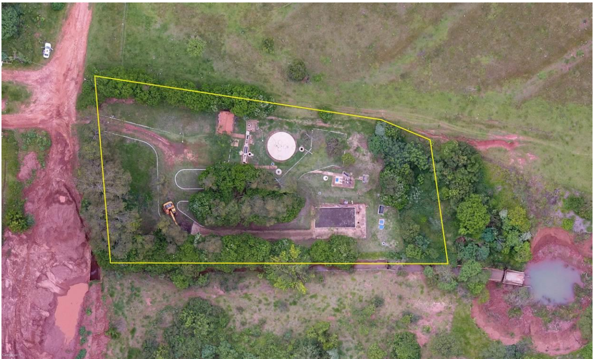
Figura 2: Vista aérea da ETE Angélica, Angélica, MS.
