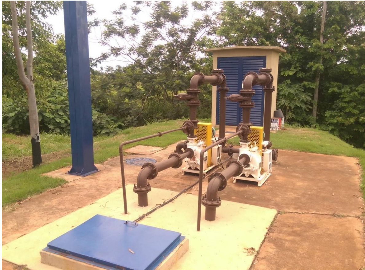
Figura 5: Vista geral da EEET 001, Angélica, MS.
