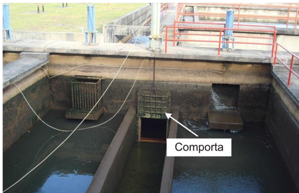
Figura 3: Exemplo de comporta, instalada na água de lavagem de filtro
