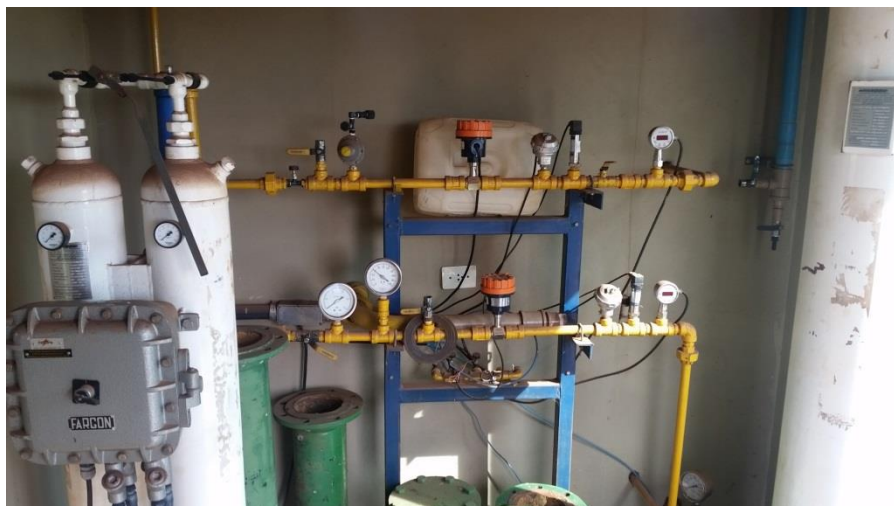
Figura 38: Sala de Análise estudo Biogás ETE Los Angeles (Águas Guariroba - AEGEA)
