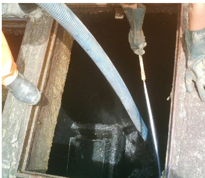
Figura 1: Jateamento e succionamento em poço de Elevatória de Esgotos
