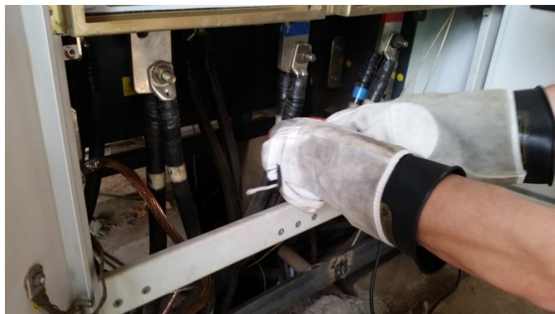
Figura 36: Exemplo de instalação de banco de capacitores
