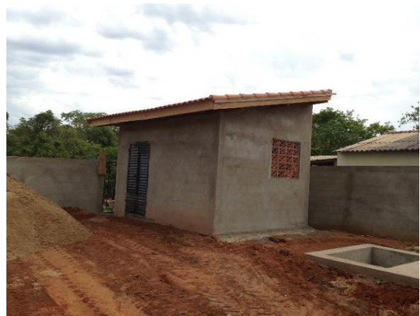
EEEB em execução
