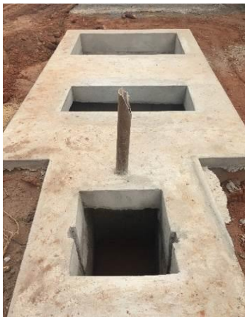
Poços da EEEB em execução
