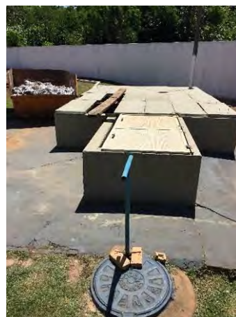
Poço de Sucção
