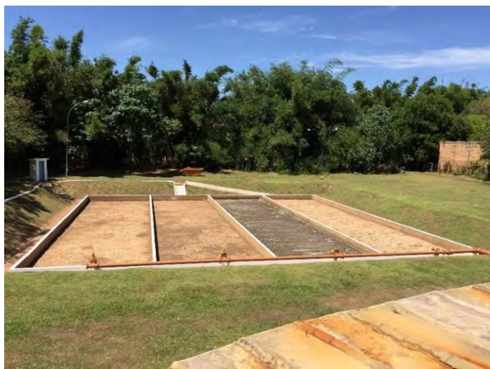
Figura 19: Leitos de secagem
