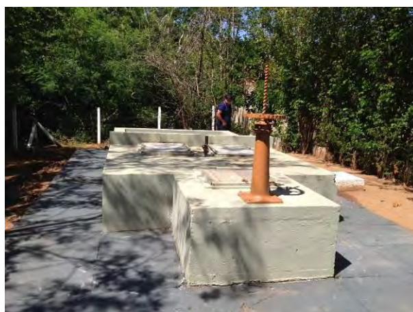
Poço de sucção
