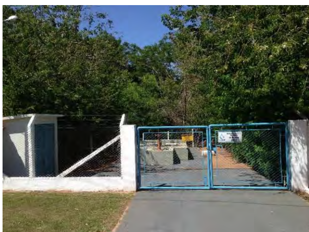
Vista externa / Urbanização
