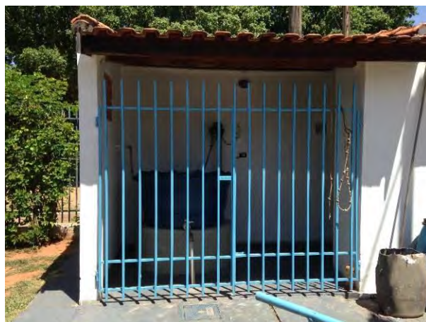
Preparação de cal
