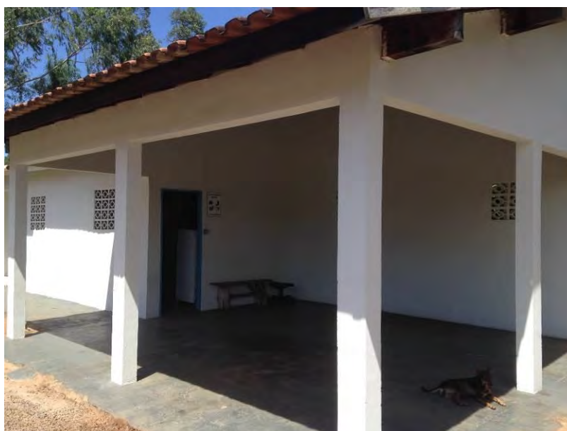
Figura 21: Sede operacional da ETE
