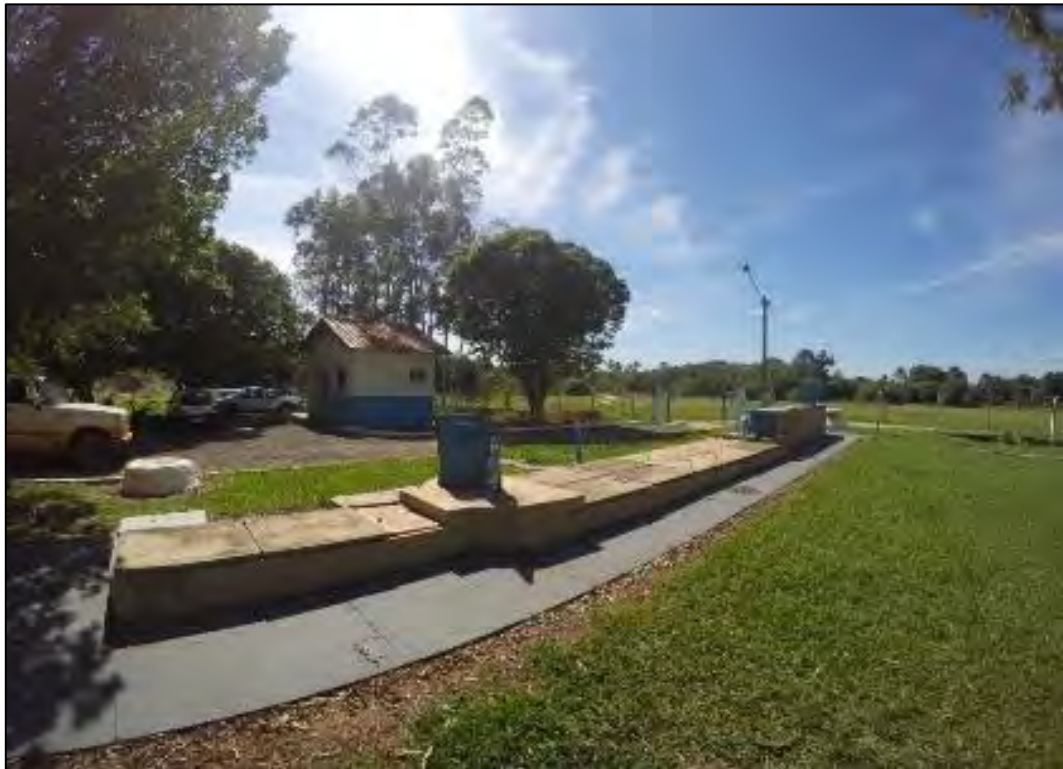
Figura 11: Vista geral do Tratamento Preliminar.
