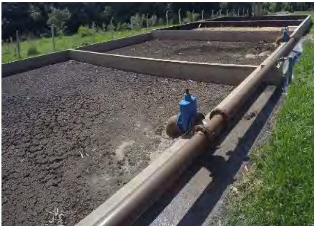
Figura 23: Leito de secagem de lodo.
