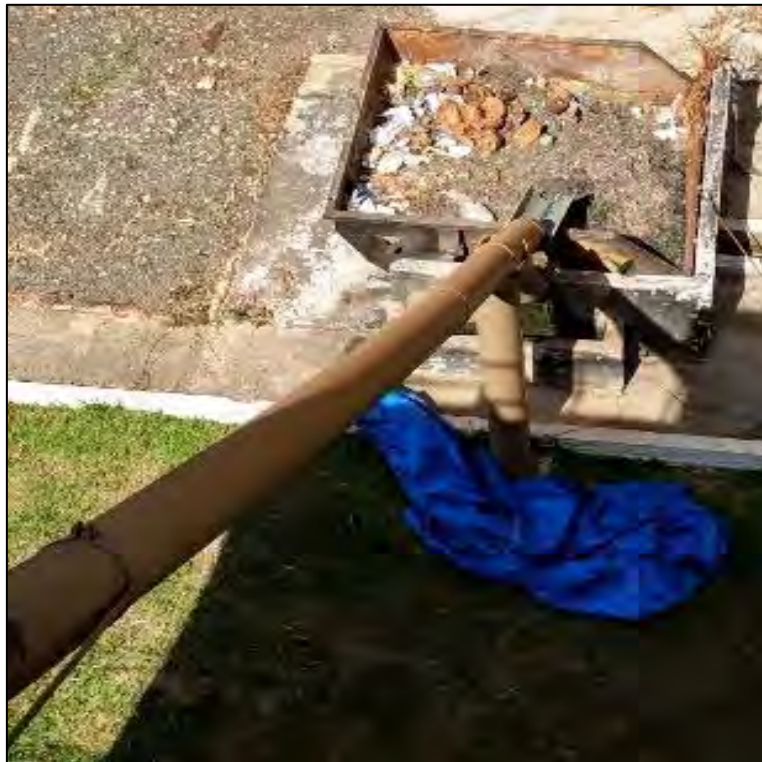
Figura 16: Caçamba para desague dos resíduos sólidos.
