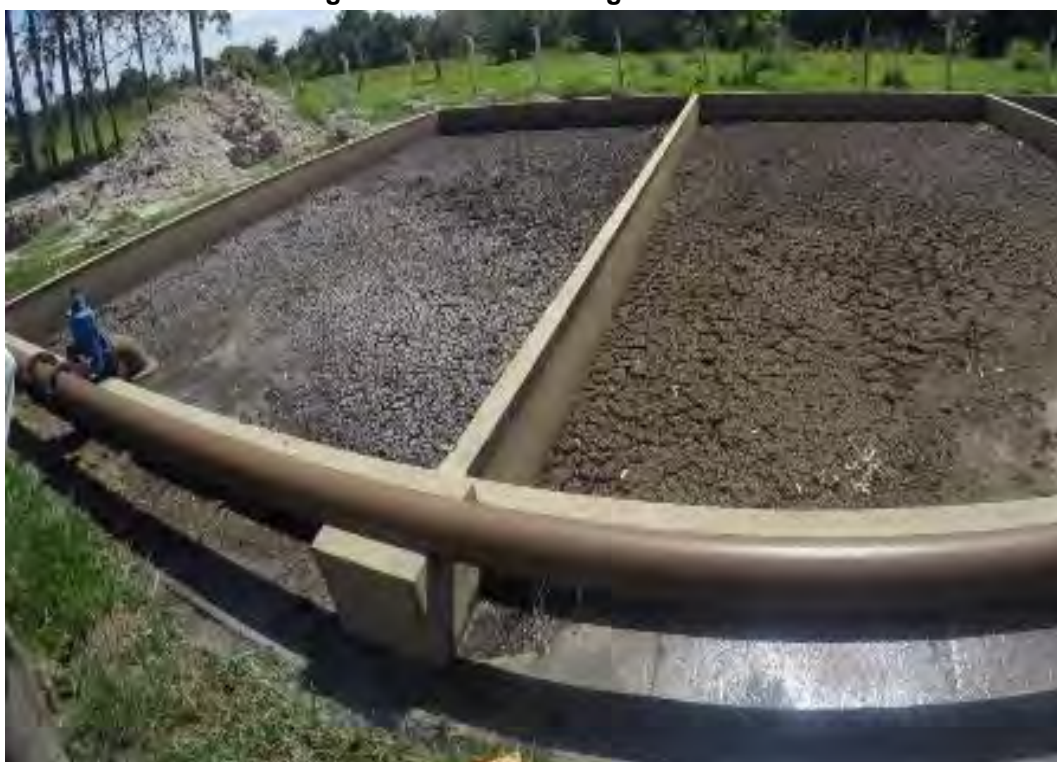
Figura 24: Leito de secagem de lodo.
