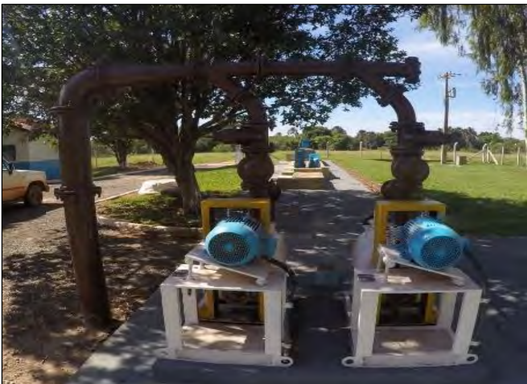
Figura 6: Bombas e barrilete de recalque.
