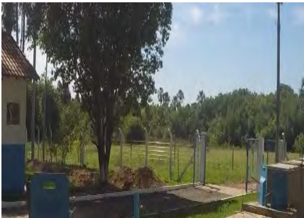
Figura 27: Fechamento e Portão de acesso.
