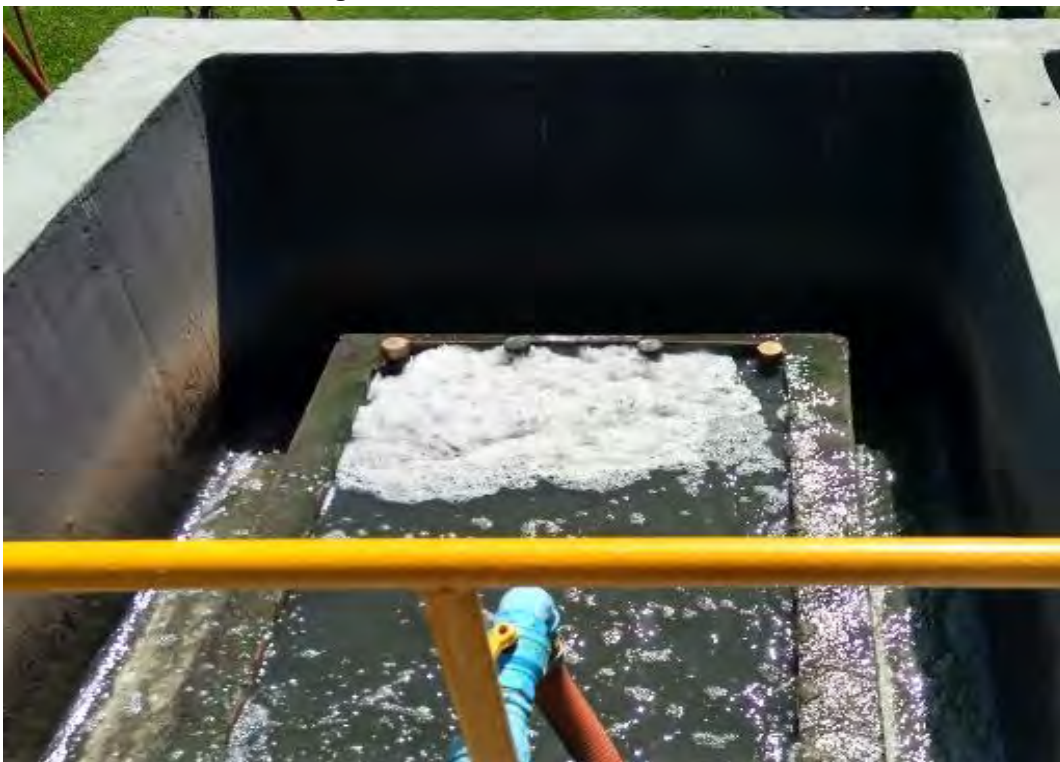
Figura 21: Filtro Aerado Submerso mais distante do soprador com deficiência de OD.
