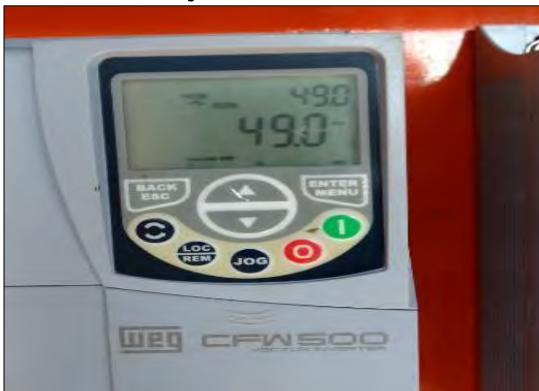
Figura 8: Inversor de Frequência.
