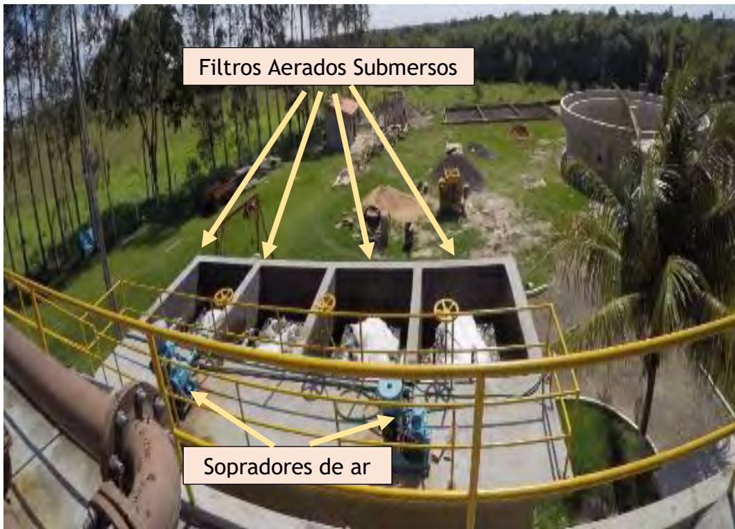
Figura 20: Filtro Aerado Submerso.
