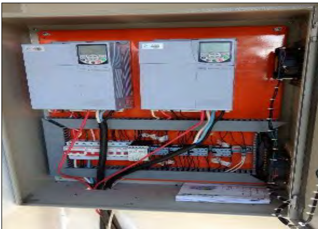
Figura 7: Quadro de Comando.
