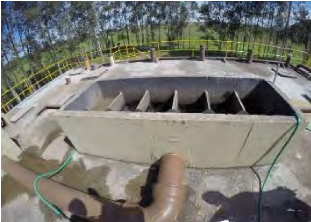
Figura 17: Caixa de Distribuição do UASB.
