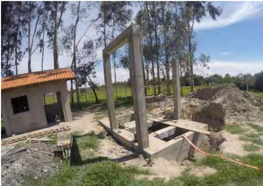
Figura 32: Estação Elevatória de Efluente Tratado.
