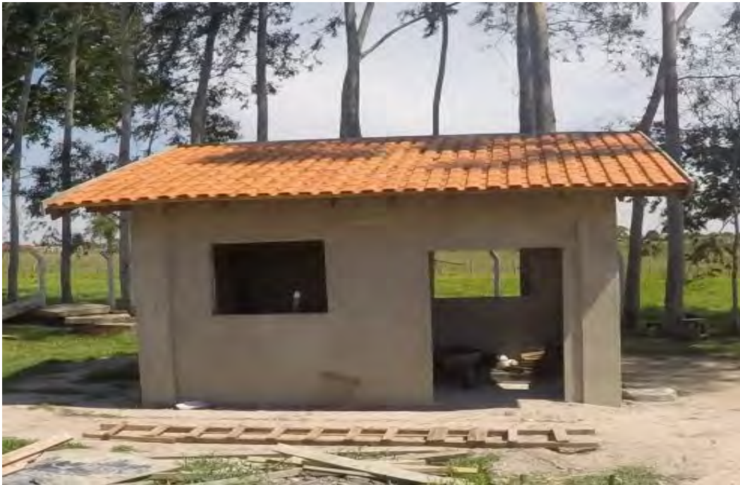
Figura 33: Casa do gerador e abrigo para o quadro de comando.
