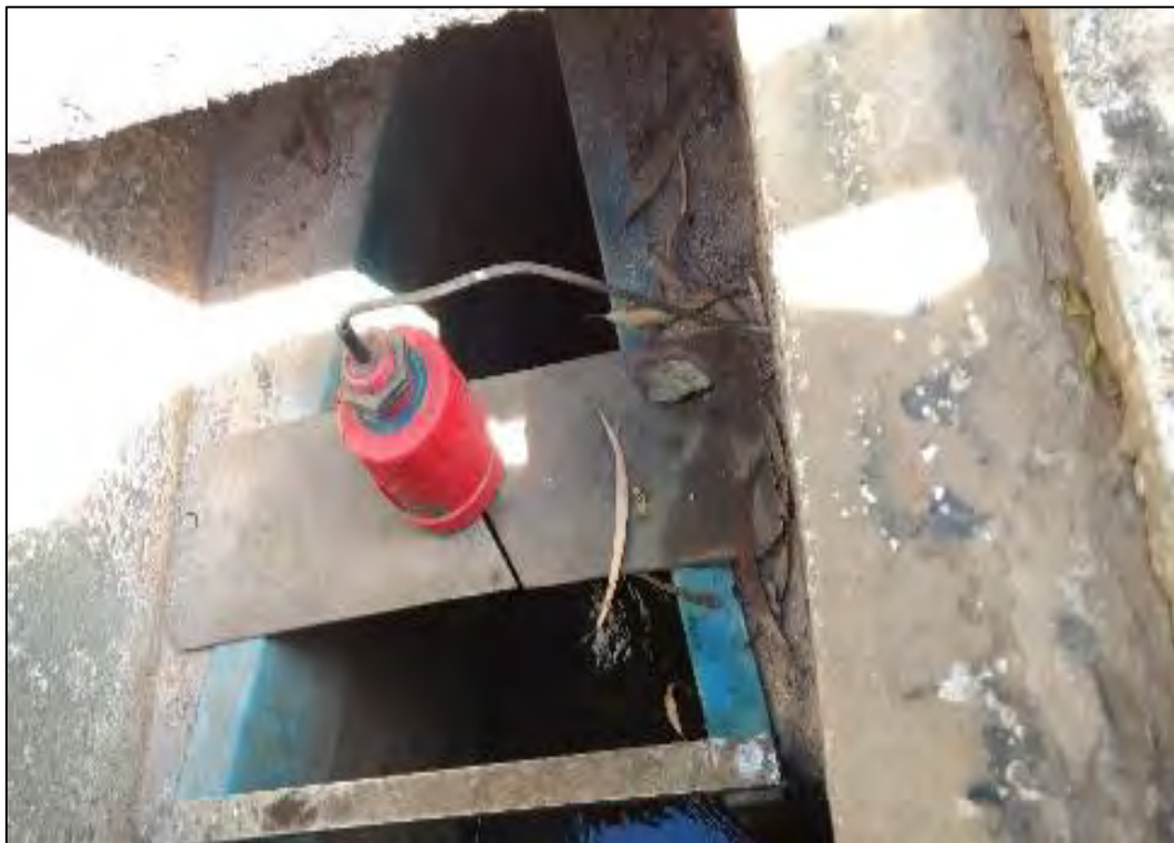
Figura 13: Calha Parshall 6'' com medidor ultrassônico.
