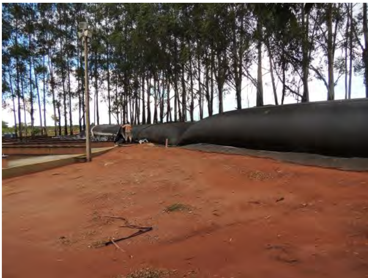
Figura 7: Bags utilizados para armazenar temporariamente os resíduos sólidos da ETE Planalto (São João), Três Lagoas, MS.
