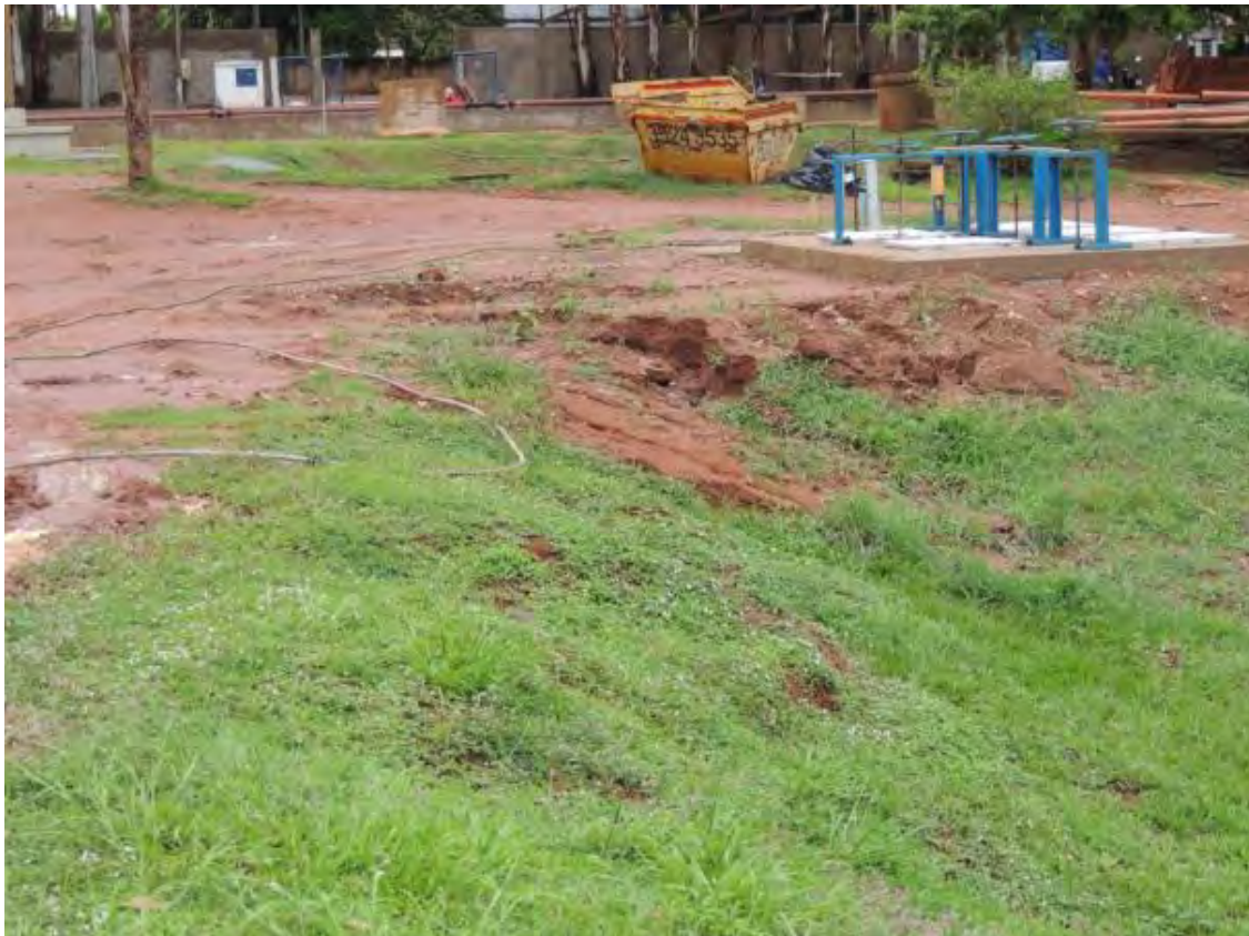
Figura 11: Processo erosivo no interior da ETE Planalto (São João), Três Lagoas, MS.
