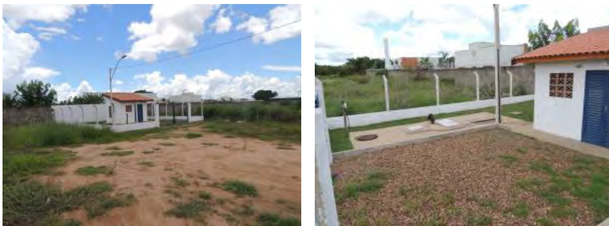
Figura 27: Vista geral da EEEB 011, Três Lagoas, MS.
