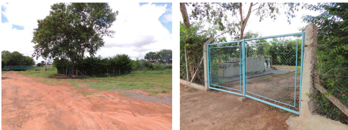
Figura 36: Vista geral da EEEB 020, Três Lagoas, MS.
