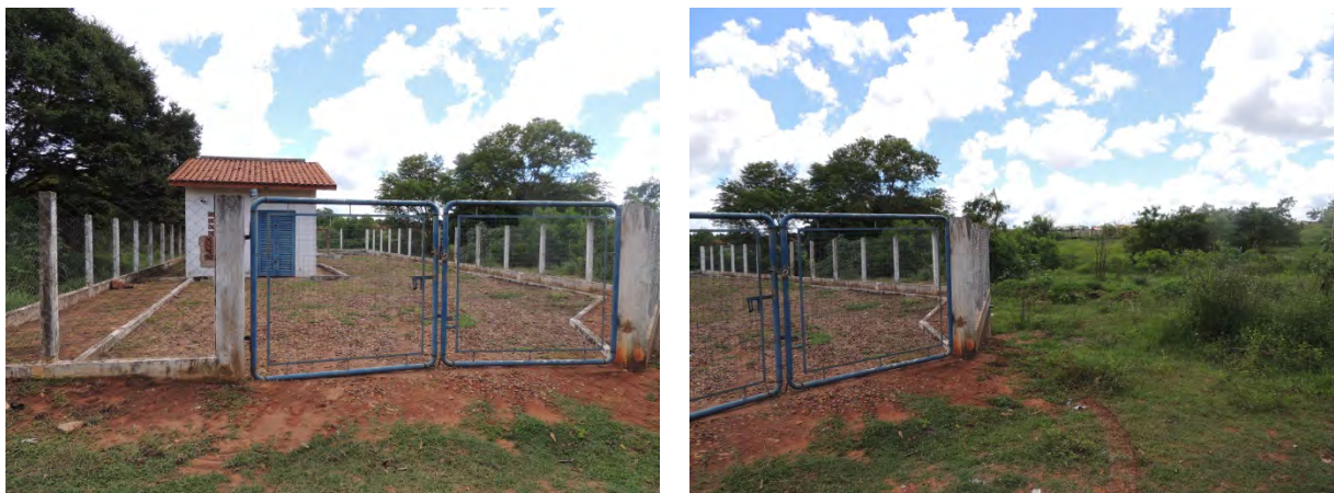
Figura 35: Vista geral da EEEB 018, Três Lagoas, MS.
