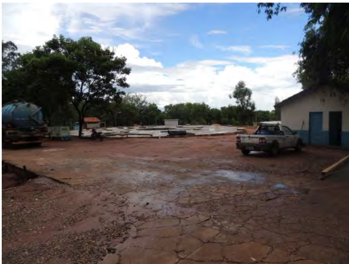
Figura 4: Vista geral da ampliação da ETE Planalto (São João), Três Lagoas, MS.
