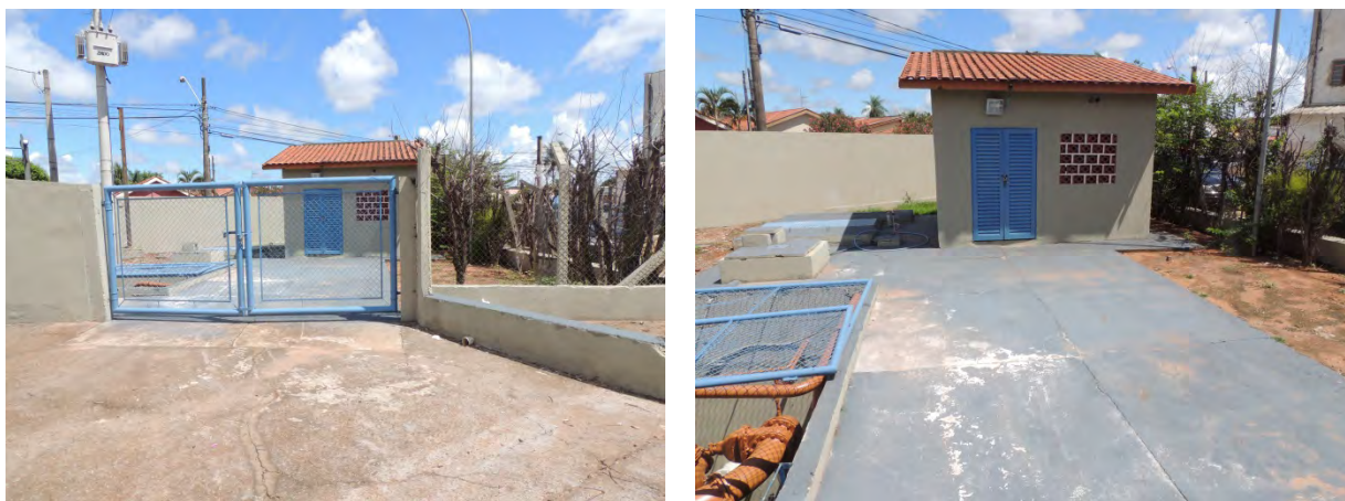
Figura 33: Vista geral da EEEB 017, Três Lagoas, MS.
