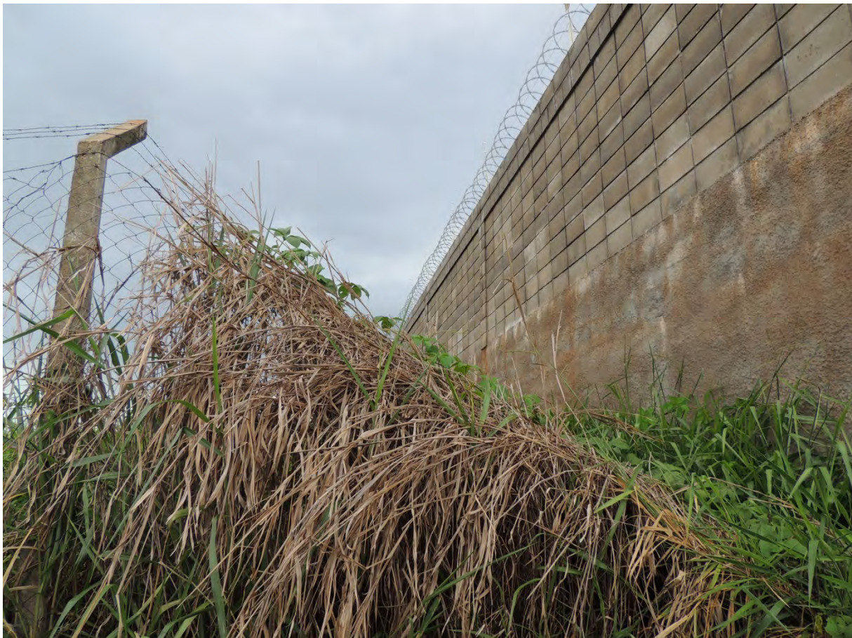
Figura 38: Dano na cerca da EEEB 021, Três Lagoas, MS.
