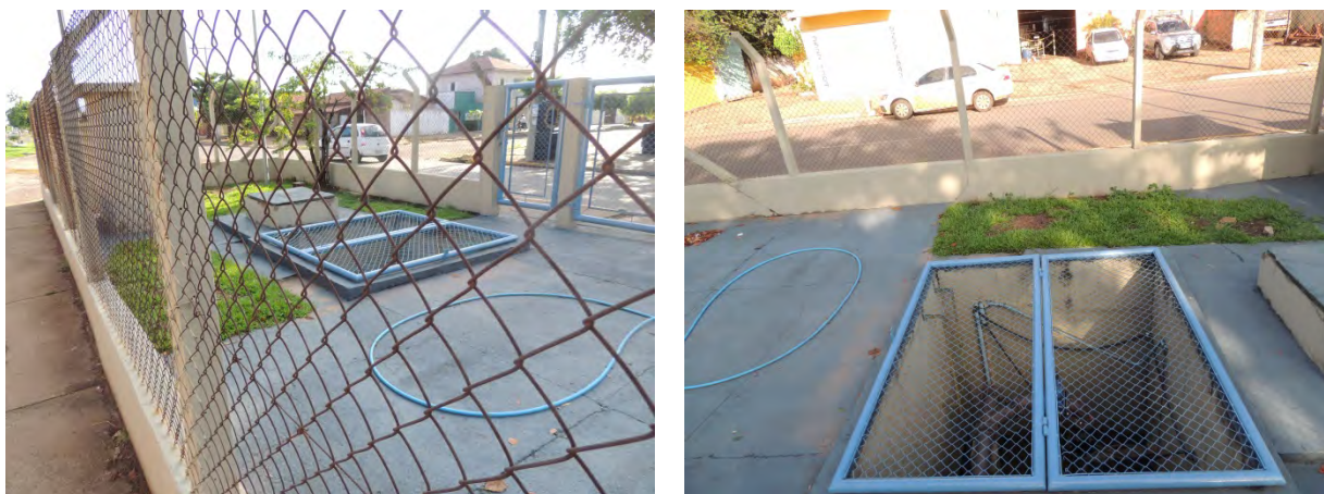
Figura 24: Vista geral da EEEB 007, Três Lagoas, MS.
