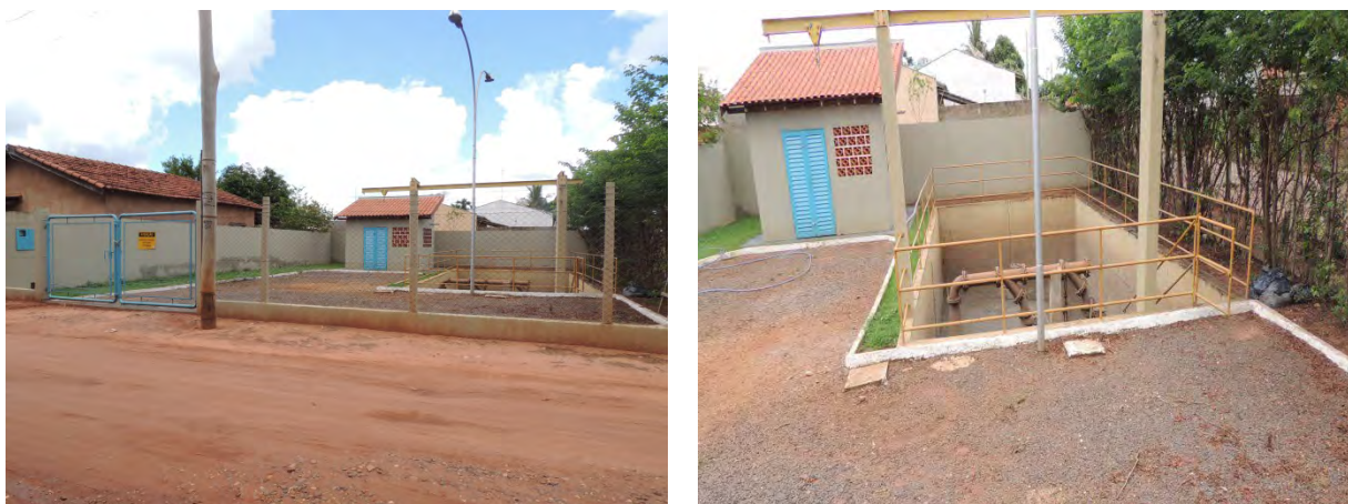
Figura 18: Vista geral da EEEB 01, Três Lagoas, MS.
