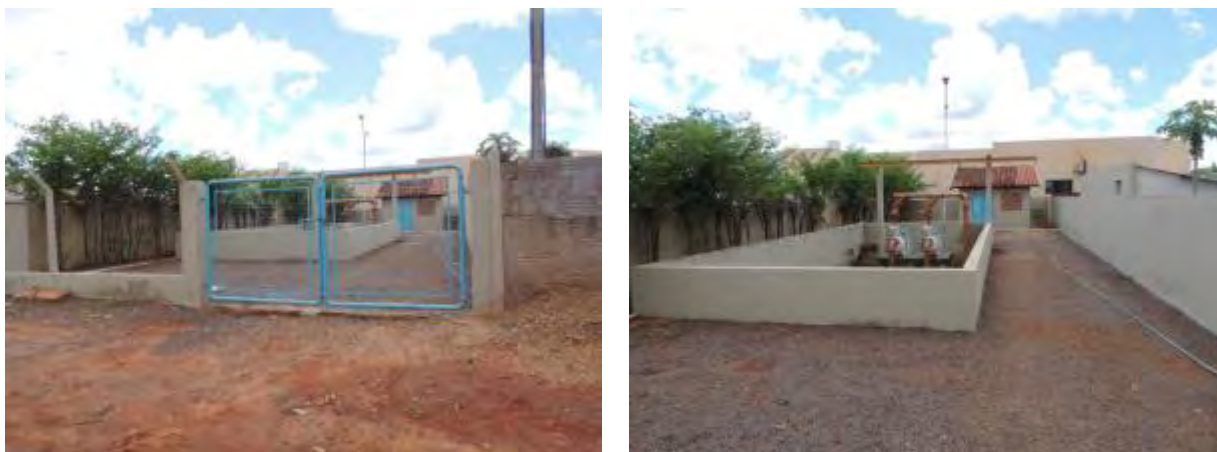
Figura 19: Vista geral da EEEB 002, Três Lagoas, MS.
