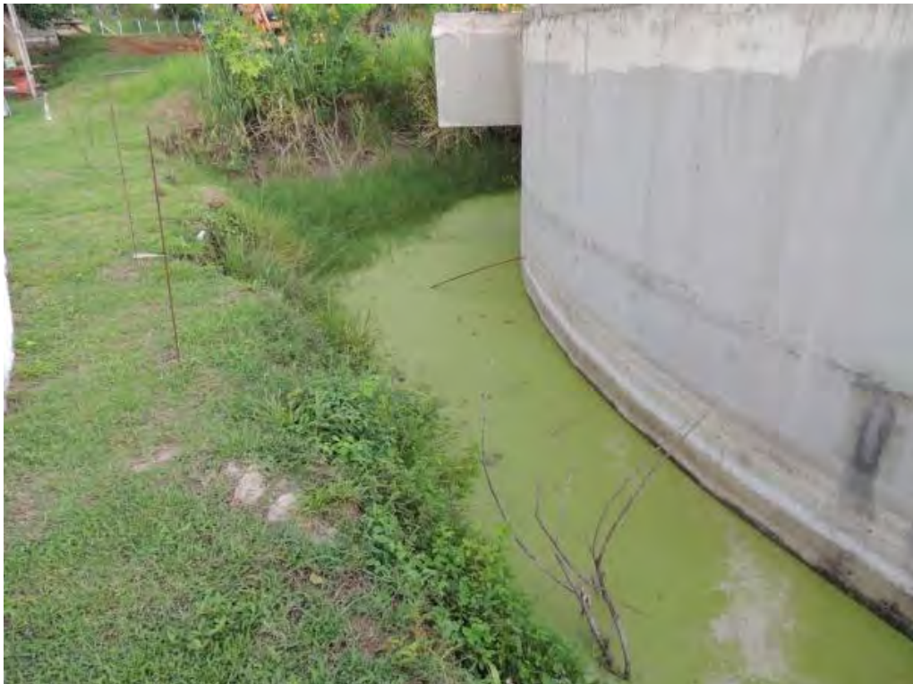
Figura 17: Processo erosivo com acúmulo de água pluvial junto ao RALF em implantação, no interior da ETE Jupιά, Três Lagoas, MS.
