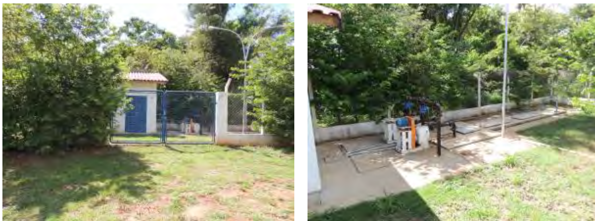
Figura 30: Vista geral da EEEB 014, Três Lagoas, MS.
