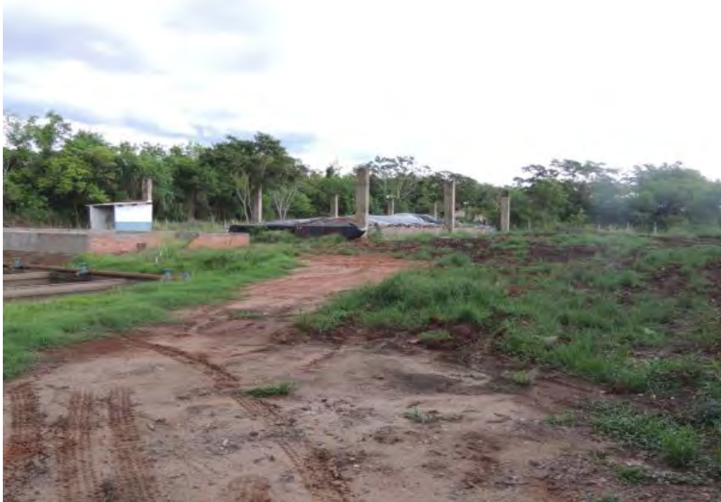
Figura 15: Acondicionamento do lodo seco, coberto por lona, no interior da ETE Jupiá, Três Lagoas, MS.
