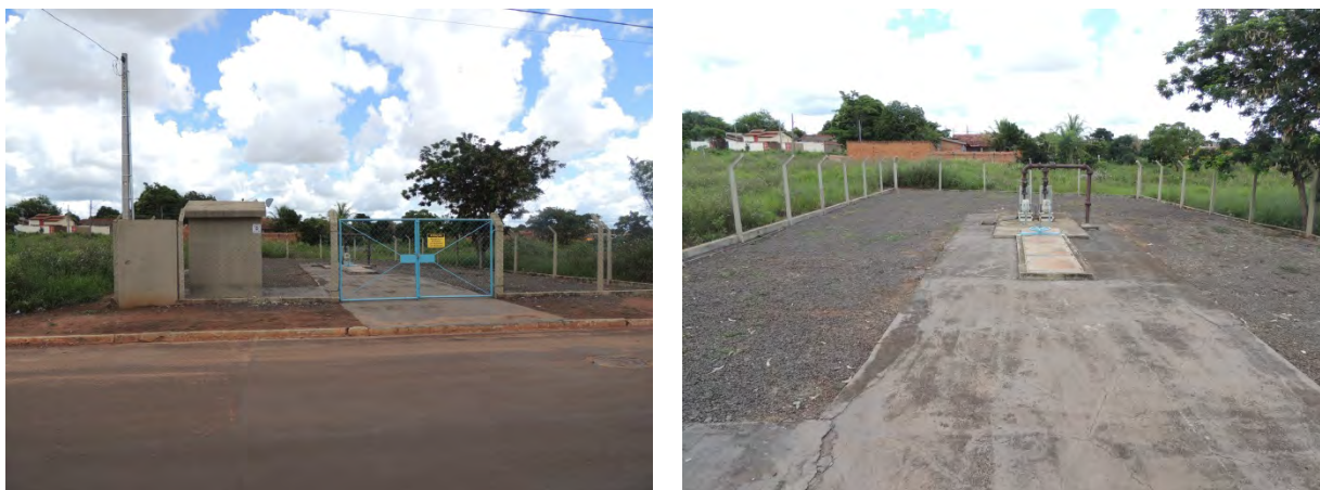
Figura 32: Vista geral da EEEB 016, Três Lagoas, MS.
