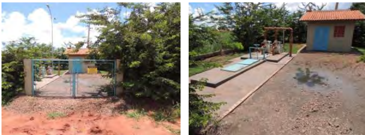
Figura 20: Vista geral da EEEB 003, Três Lagoas, MS.
