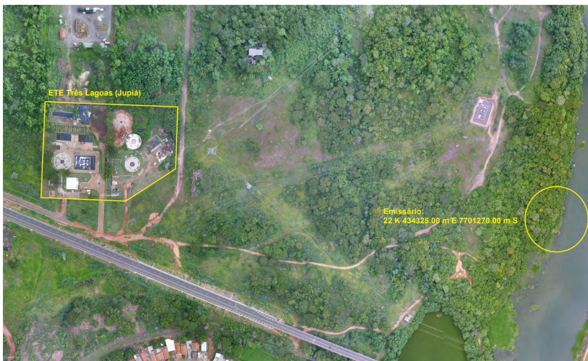
Figura 13: Vista aérea da ETE Jupia em ampliação e entorno, Três Lagoas, MS.
