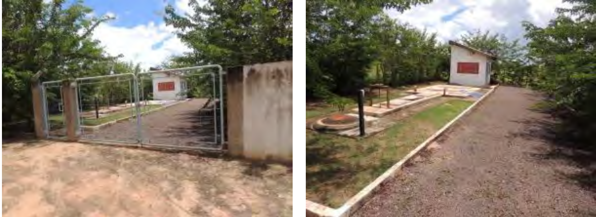
Figura 26: Vista geral da EEEB 010, Três Lagoas, MS.
