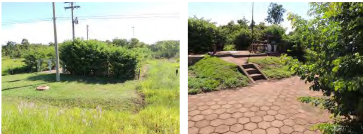
Figura 28: Vista geral da EEEB 012, Três Lagoas, MS.
