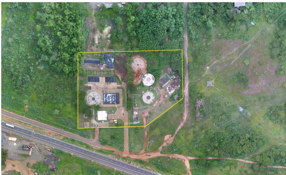
Figura 12: Acima: Vista aérea da ETE Jupia em ampliação, Três Lagoas, MS.
