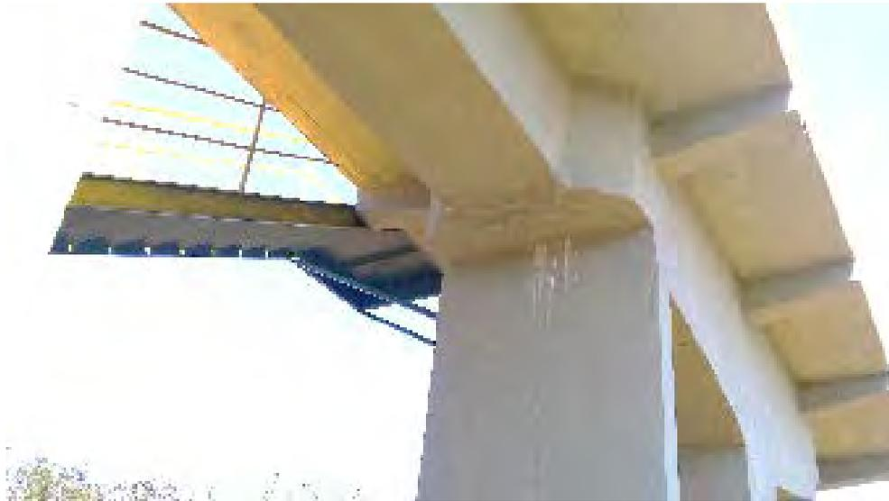
Patologia construtiva com característica de corrosão química e abrasiva
