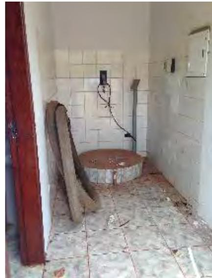
Base de apoio do tanque misturador de cal (não instalado)
