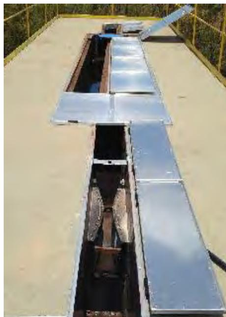
Calha Parshall  $W=3''$  e local para instalação de medidor de vazão ultrassônico.
