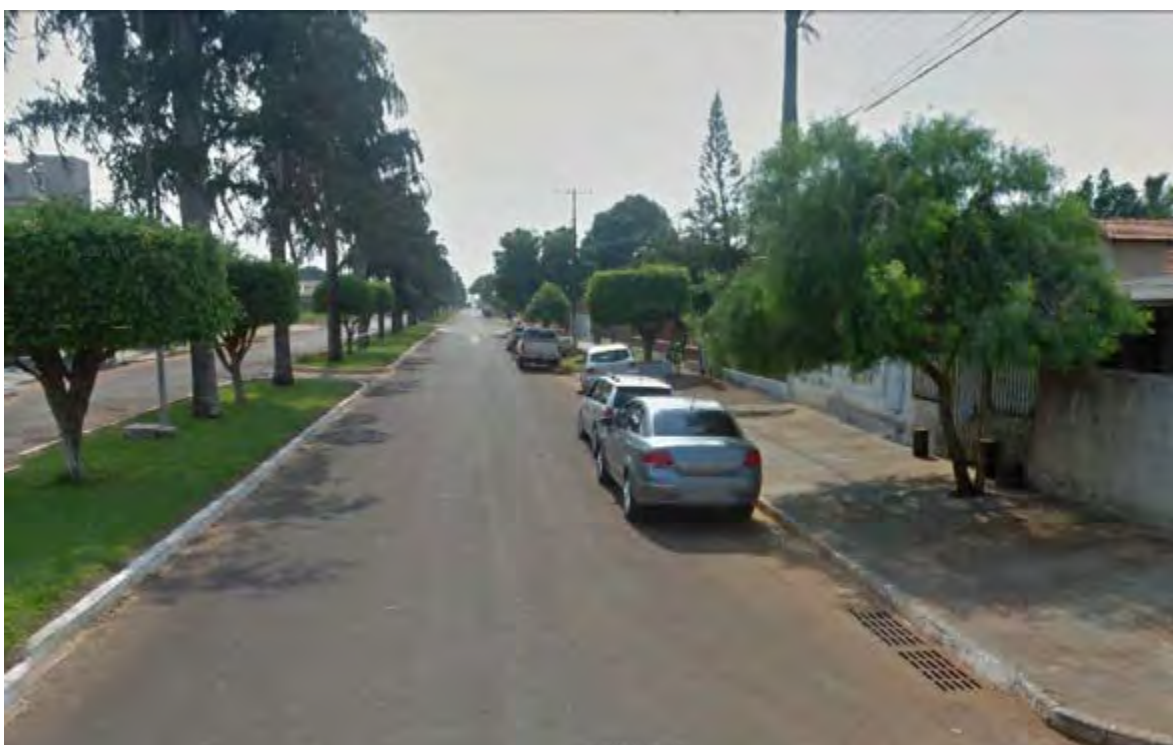
Figura 4: Vista do passeio público e do arruamento asfaltado com sistema de drenagem de águas pluviais, em Taquarussu.
