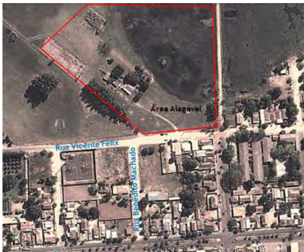
Figura 2: Localização da área alagável em Taquarussu.
