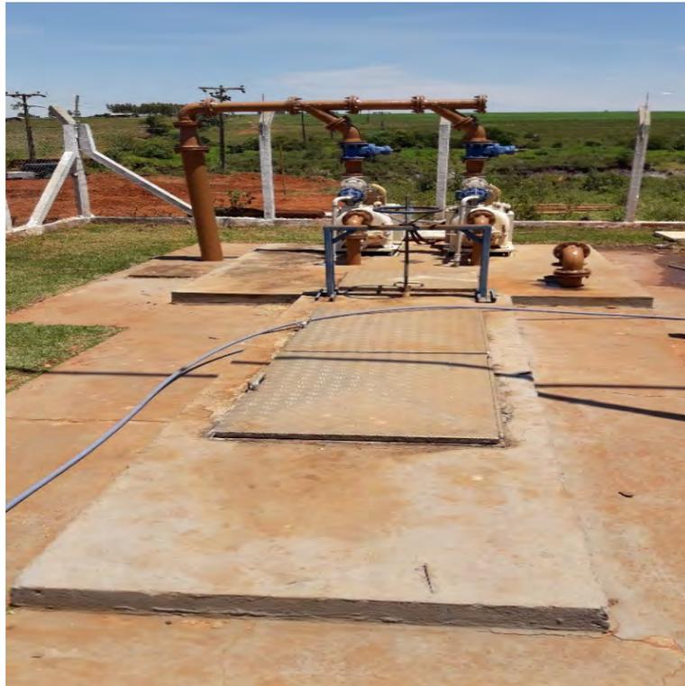
**Figura 14: Vista superior do poço de sucção e bombas Re- autoescorvantes**
