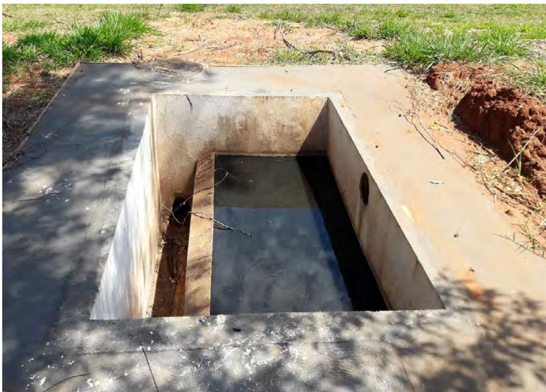
**Figura 23: Caixa de areia para limpeza do desarenador**
