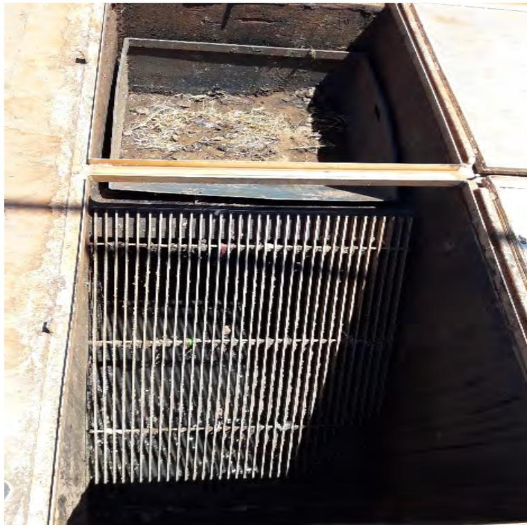
**Figura 15: Gradeamento retentor de sólidos na entrada EEEB-2.**
