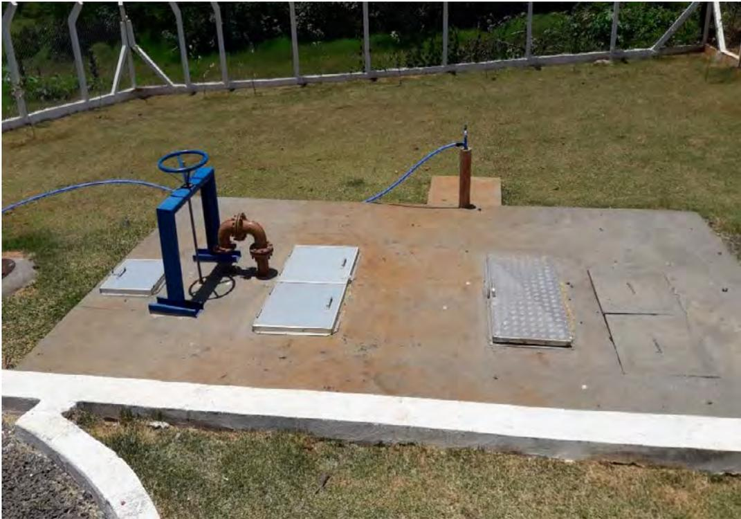
**Figura 7: Poço de sucção.**
