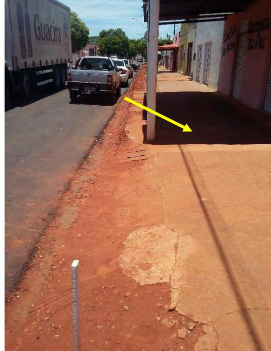
**Figura 5: Ligação de esgoto na região Central, com obra de pavimentação.**
