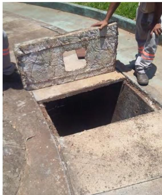
**Figura 18: Tampa do canal periférico do RALF, estrutura já comprometida, ferragem exposta na ETE Santa Rita do Pardo.**
