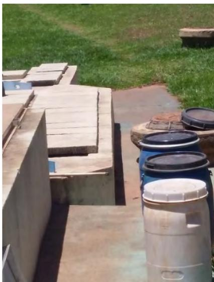
**Figura 11: Tratamento preliminar e bombonas para armazenamento do material gradeado da ETE Santa Rita do Pardo.**
