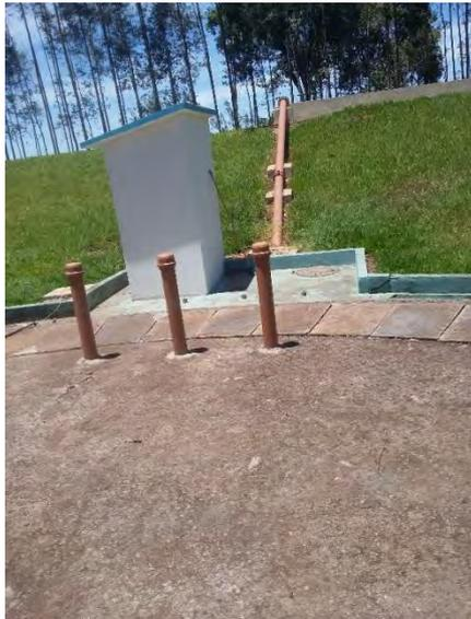
**Figura 22: Poço de sucção da elevatória de lodo, linha de recalque e abrigo de quadro comando da ETE Santa Rita do Pardo.**
