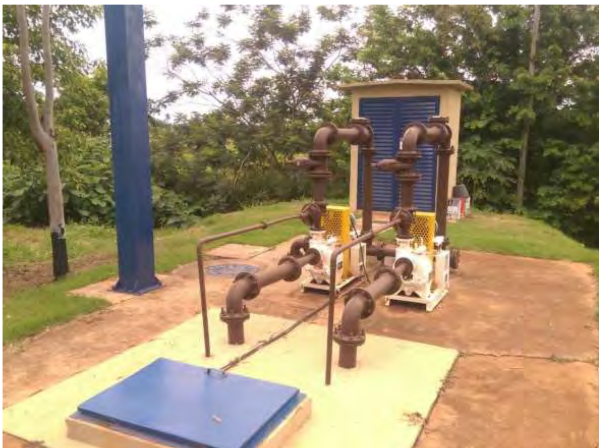
Figura 5: Vista geral da EEET 001, Angélica, MS.
