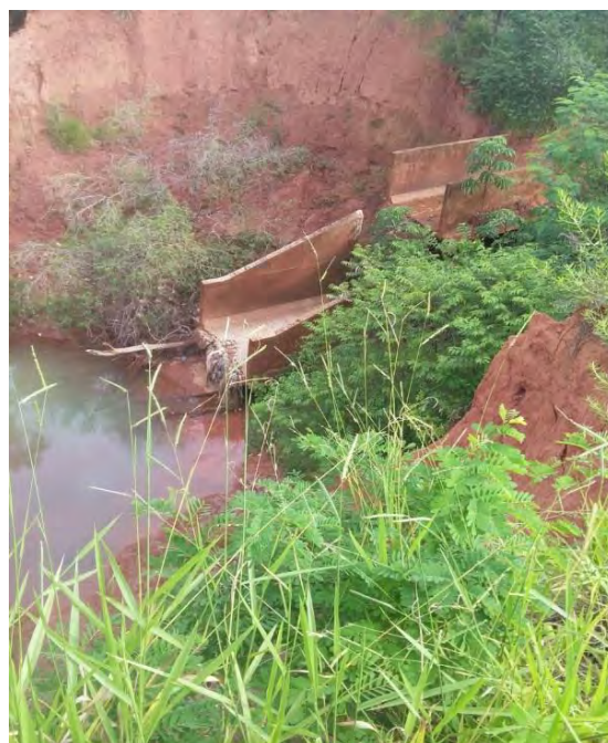
Figura 16: Ponto de lançamento das águas pluviais atrás da ETE Angélica.
