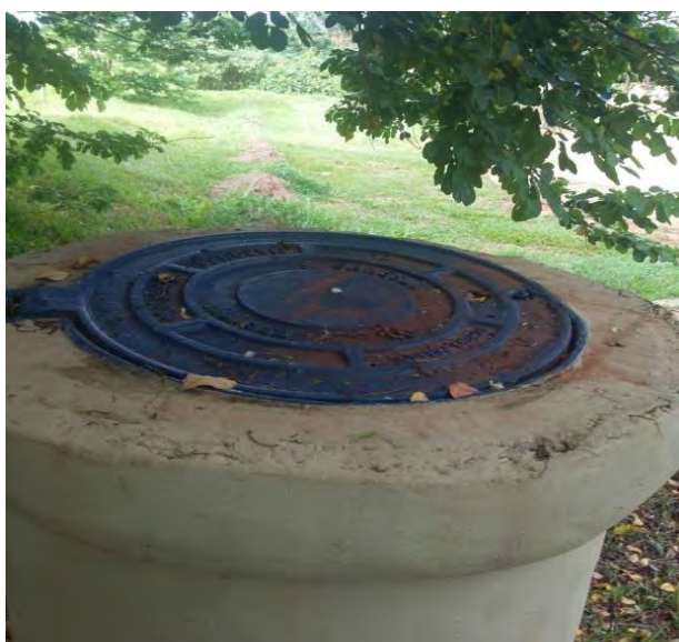
Figura 11: Poço de visita do extravassor/by-pass.
