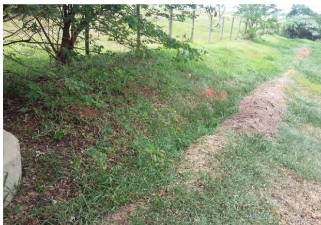
Figura 30: Fechamento da área da ETE Angélica.
