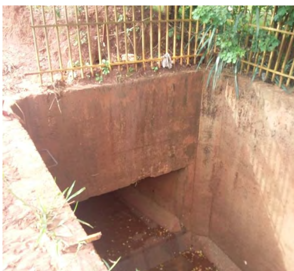
Figura 13: Vista 1 da estrutura do sistema de drenagem na cidade de Angélica.
