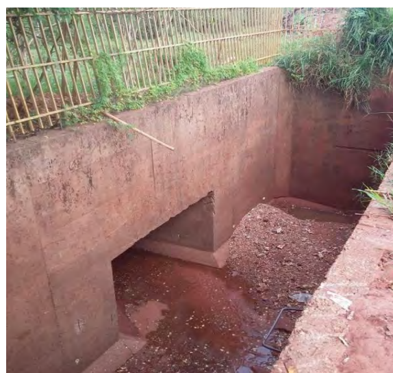
Figura 14: Vista 2 da estrutura do sistema de drenagem na cidade de Angélica.
