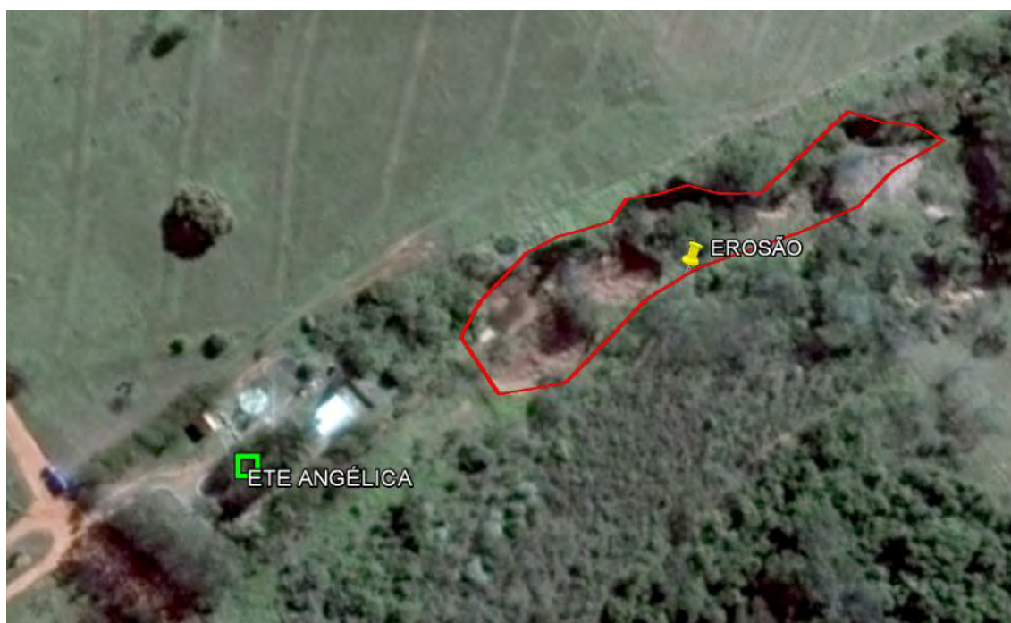
Figura 17: Localização da erosão em relação à ETE de Angélica.
