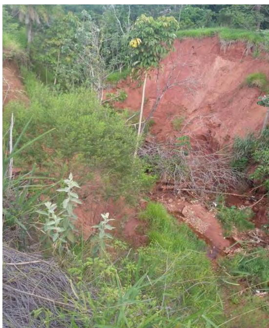
Figura 15: Erosão atrás da área da ETE Angélica.
