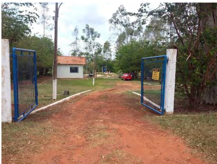
Figura 29: Vista do portão de acesso a ETE Angélica.
