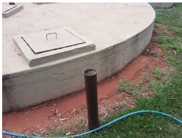
Figura 25: Caixa de inspeção do UASB/RALF da ETE Angélica.
