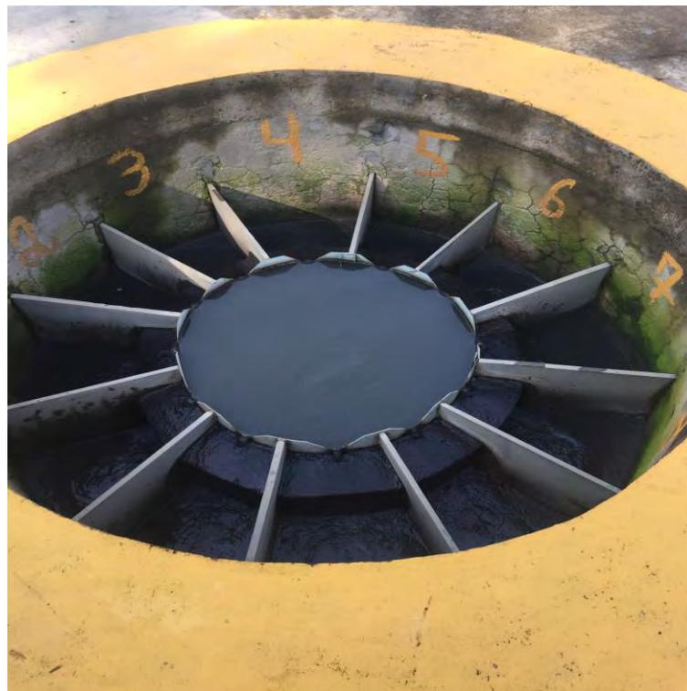
**Figura 16: caixa de distribuição (UASB).**
