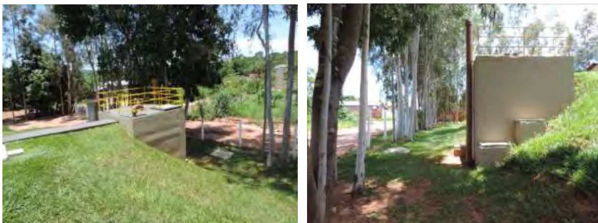
Figura 6: Vista geral da EEET ETE Rio Verde, Rio Verde de Mato Grosso, MS.
