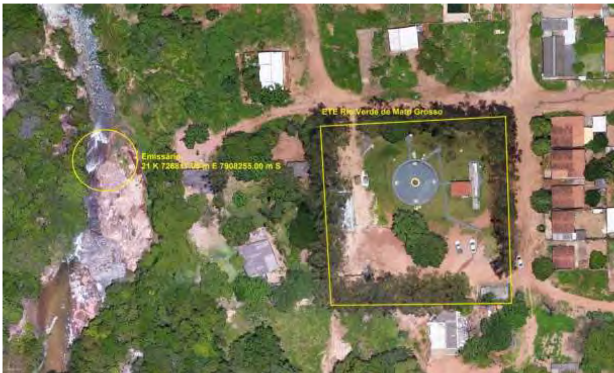
Figura 3: Vista aérea da ETE Rio Verde e entorno, Rio Verde de Mato Grosso, MS..
