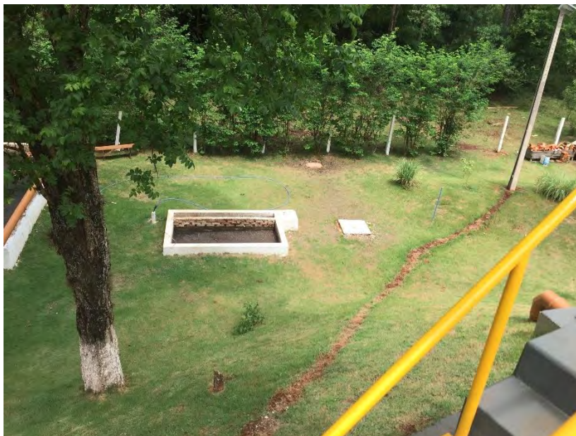
Figura 12: Caixa de areia.
