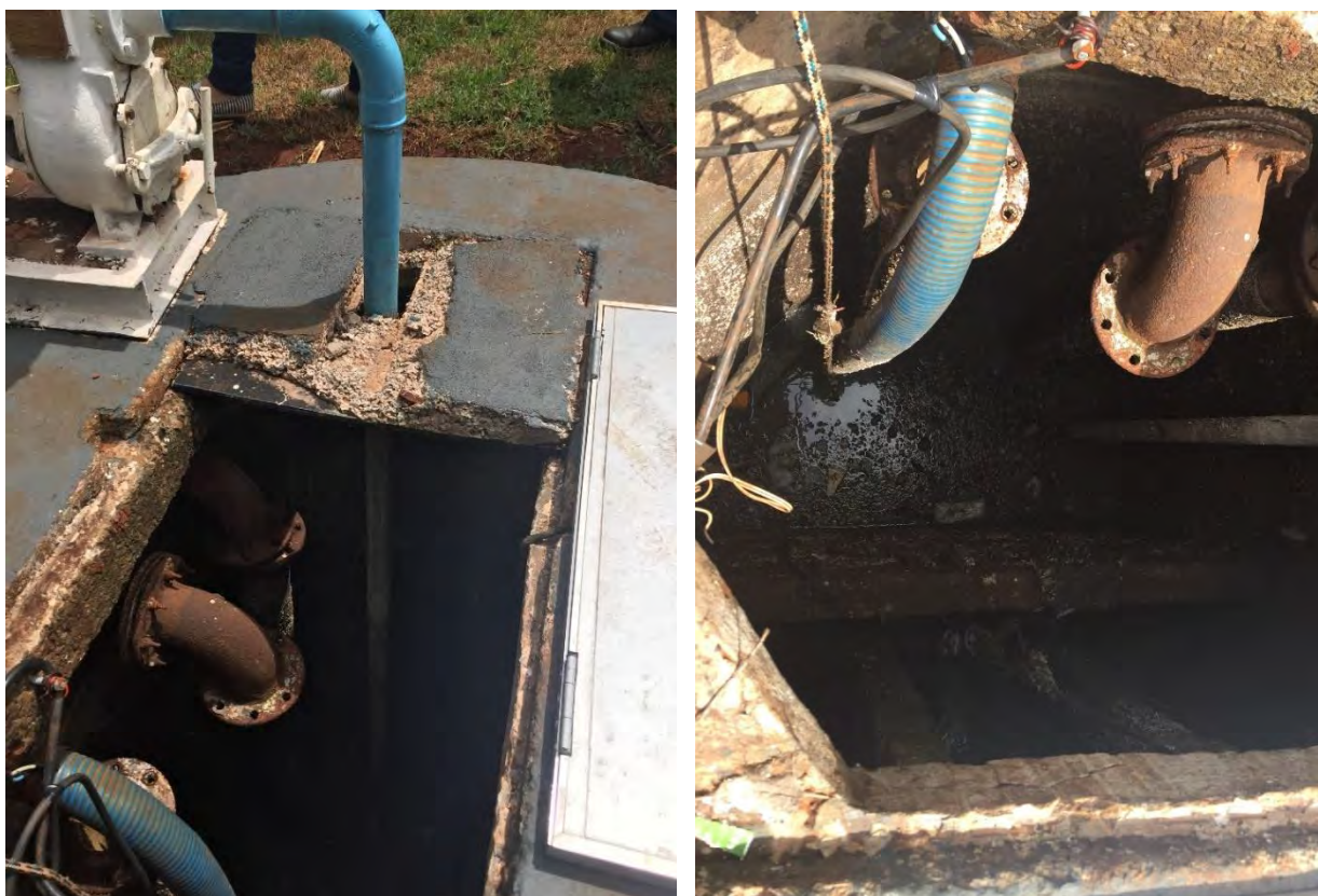
Tampa do poço de sucção
