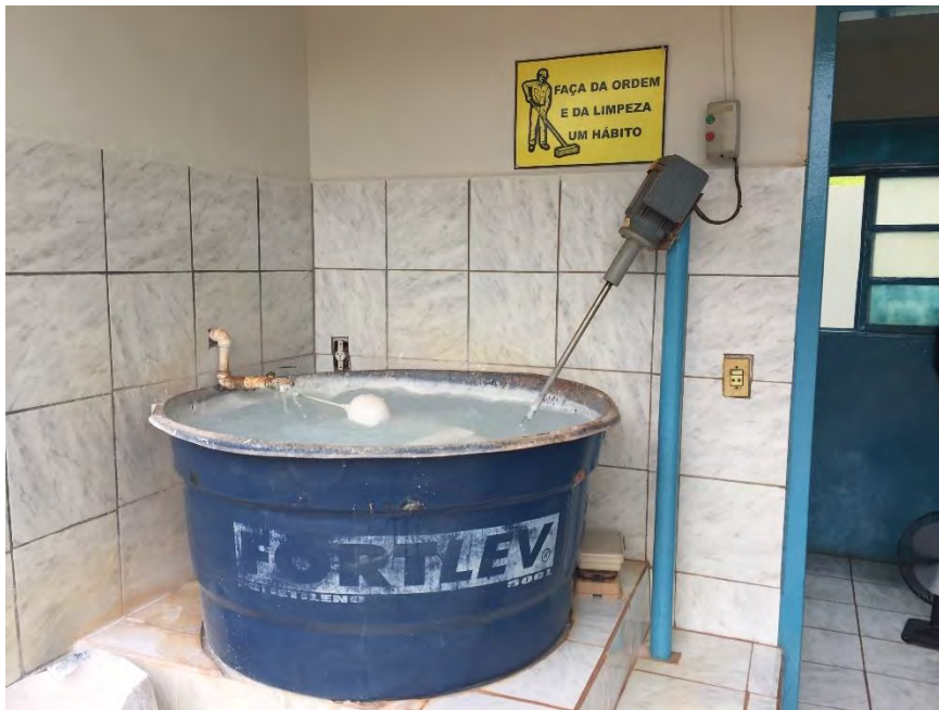
Figura 10: Tanque de preparação de solução de cal.
