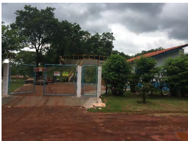
Entrada da ETE
