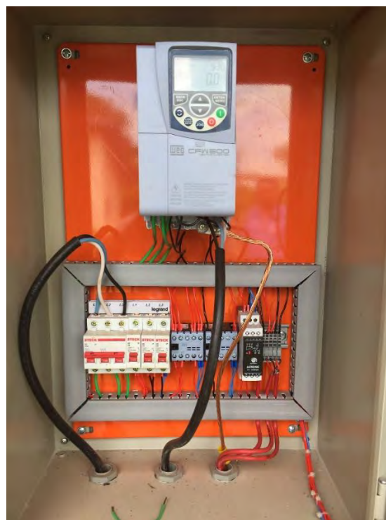
Quadro de comando
