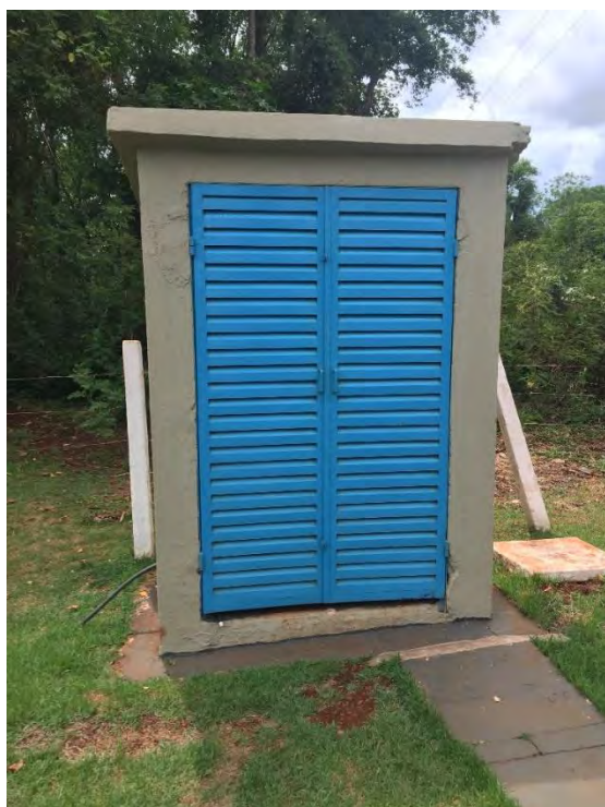
Abrigo do quadro de comando
