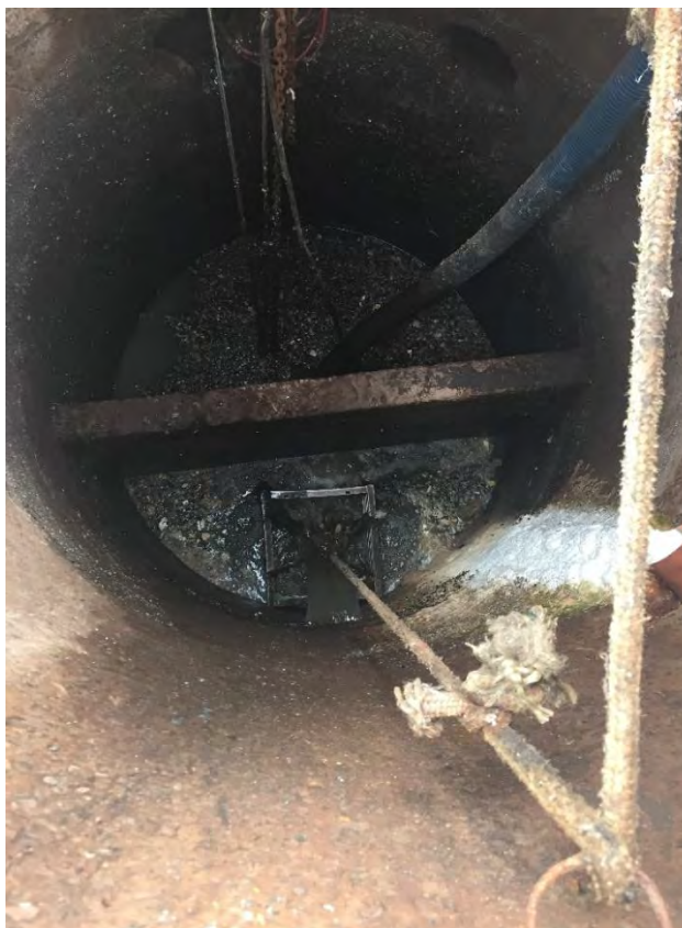
Cesto e poço de sucção
