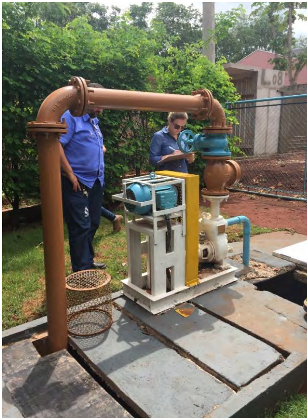
Vista da parte superior da elevatória
