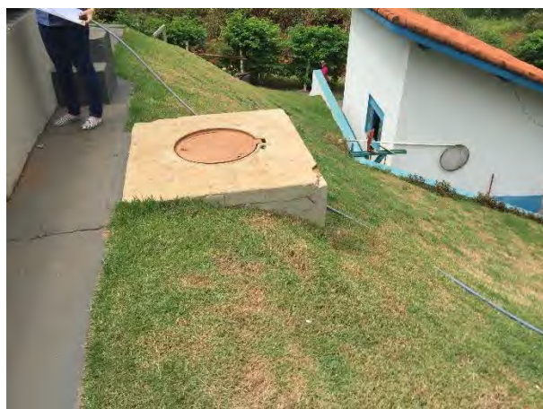
Vista laboratório e caixa de descarga de areia do tratamento preliminar
