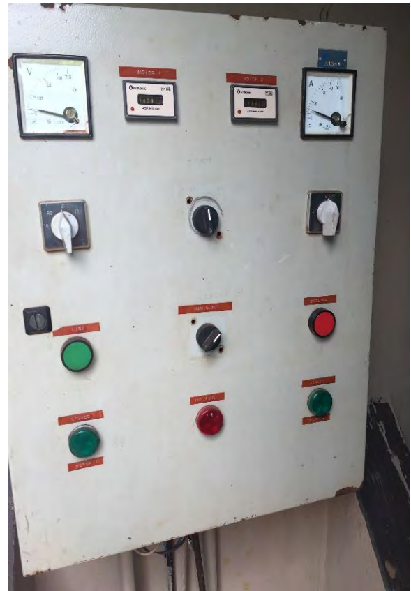
Quadro de comando
