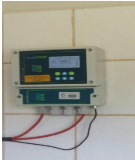
**Figura 36- Vista do medidor de vazão ultrassônico NIVERTEC, medindo na hora da visita, 10,10 L/s de vazão de entrada, ETE Ribas do Rio Pardo.**
