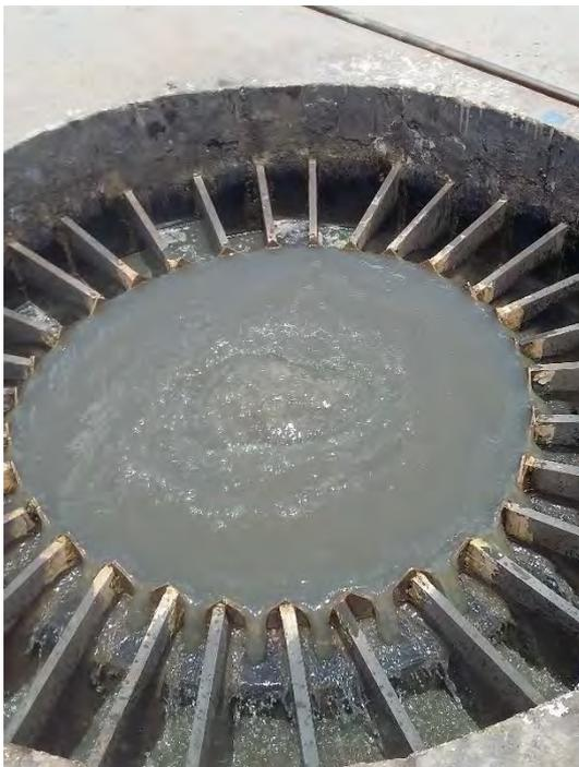
**Figura 35- Vista do vertedor central do UASB da ETE Ribas do Rio Pardo, diferentes espaçamentos e larguras nos vertedores.**
