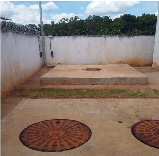
**Figura 11: Poço de sucção, caixa de barrilete e sensor de presença, Ribas do Rio Pardo.**
