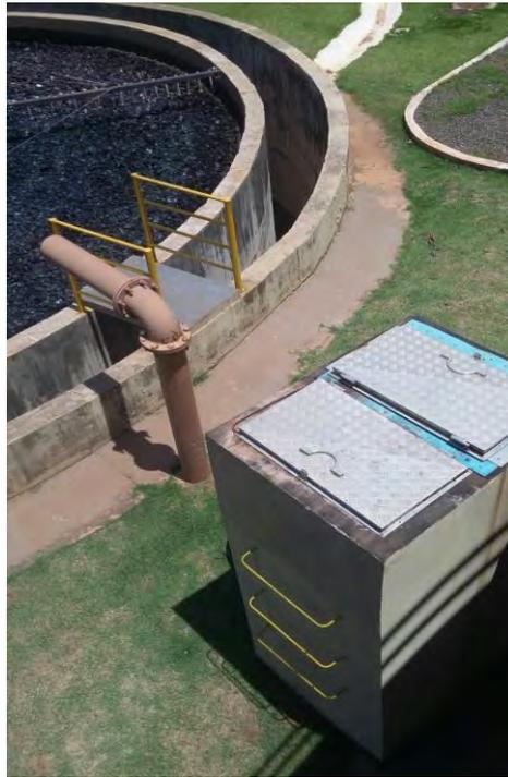
**Figura 37: Vista de caixa de passagem existente entre UASB e Filtro Biológico Percolador, ETE Ribas do Rio Pardo.**
