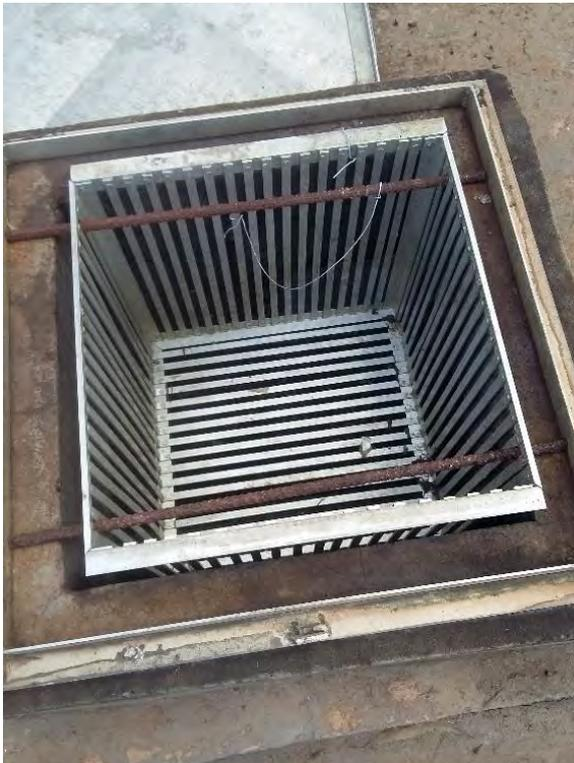
**Figura 45– Vista de cesto metálico na entrada da Caixa de Recebimento de Auto fossas, ETE Ribas do Rio Pardo.**
