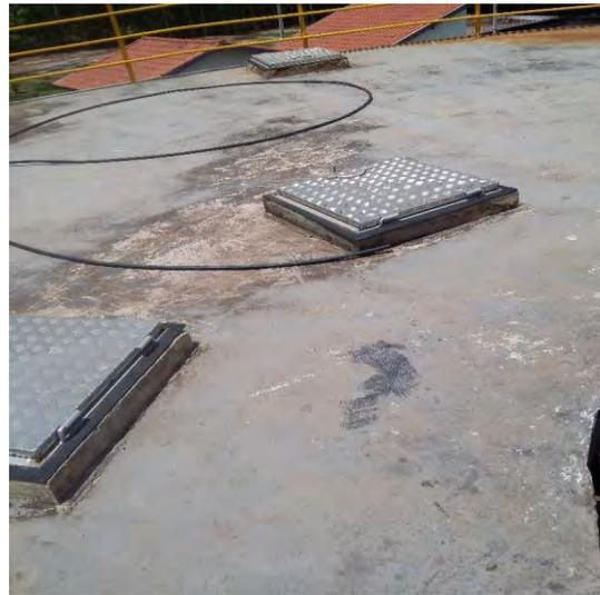
**Figura 34- Vista da cobertura do UASB da ETE Ribas do Rio Pardo, tampas para acesso/limpeza do vertedor periférico e remoção de espuma.**
