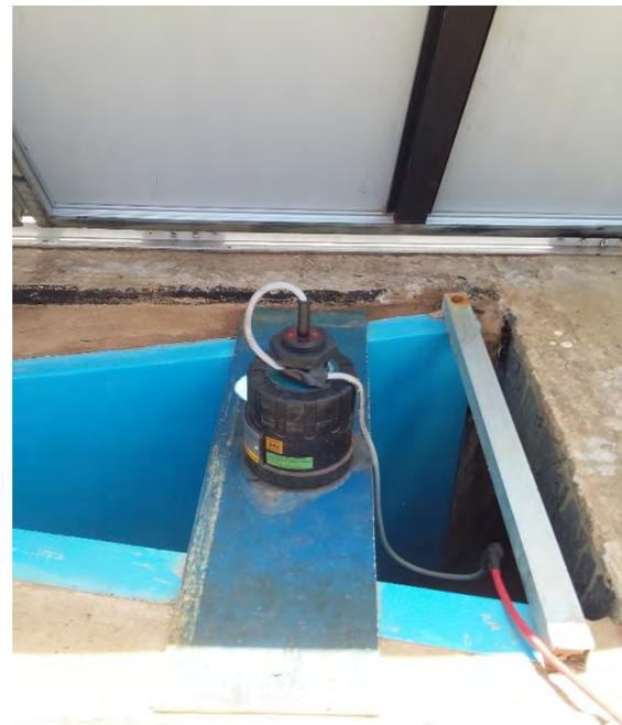
**Figura 30- Vista do Medidor de vazão ultrassônico existente, ETE Ribas do Rio Pardo.**
