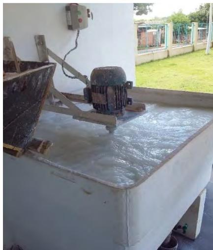
**Figura 25: Vista do agitador e da bomba dosadora de cal, ETE Ribas do Rio Pardo.**
