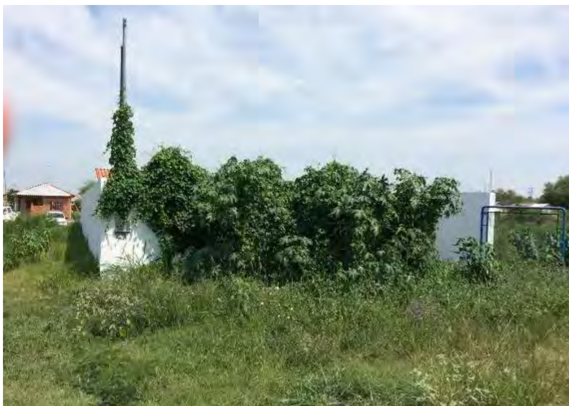
Figura 14: Vista da EEEB 08 - Dom Pepe - Dom Pepe de Porto Murtinho.
