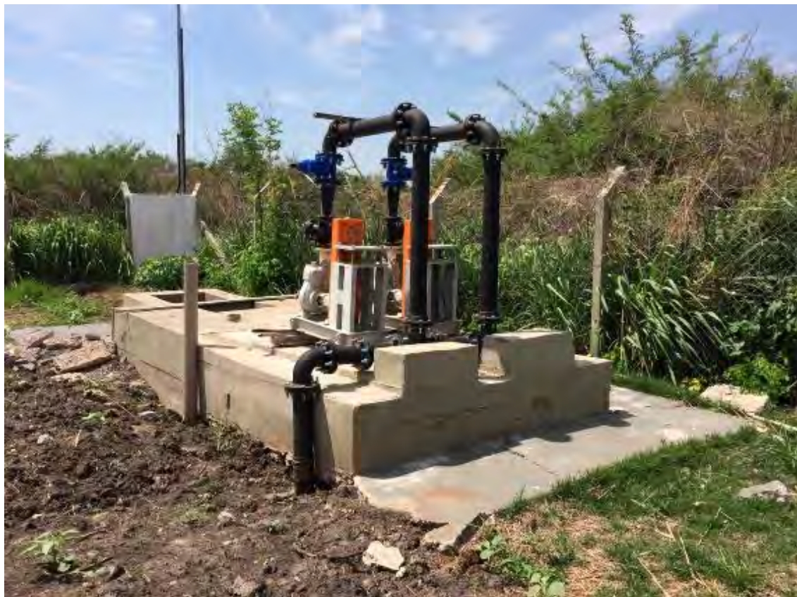
Figura 19: Vista barrilete da EEEB 09 - Che Roga Mi de Porto Murinho, nota-se a ausência dos motores.
