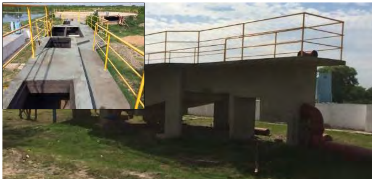
Figura 41: Vistas do novo tratamento preliminar (desarenador por gravidade) da ETE de Porto Murтинho, no detalhe faltando tampas de alumínio, dispositivos de medição de vazão e gradeamento.
