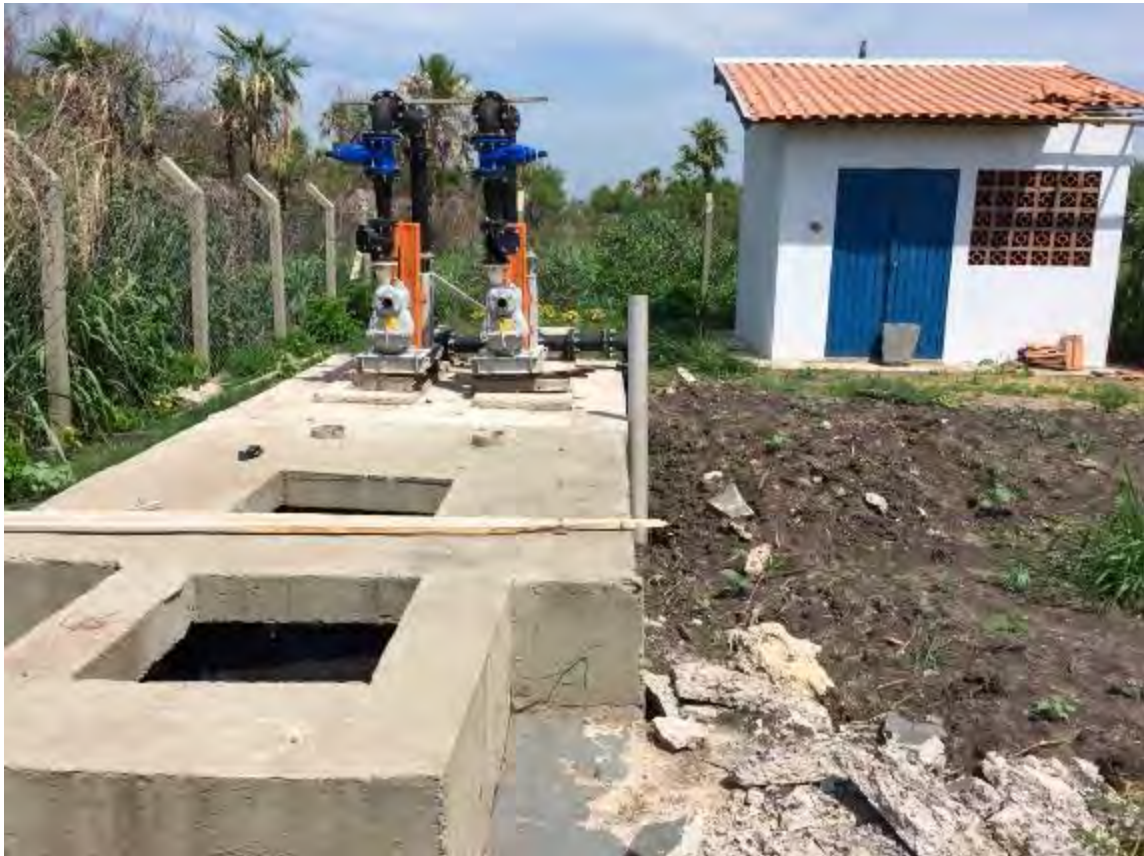
Figura 18: Vista da estrutura da EEEB 09 - Che Roga Mi de Porto Murinho.
