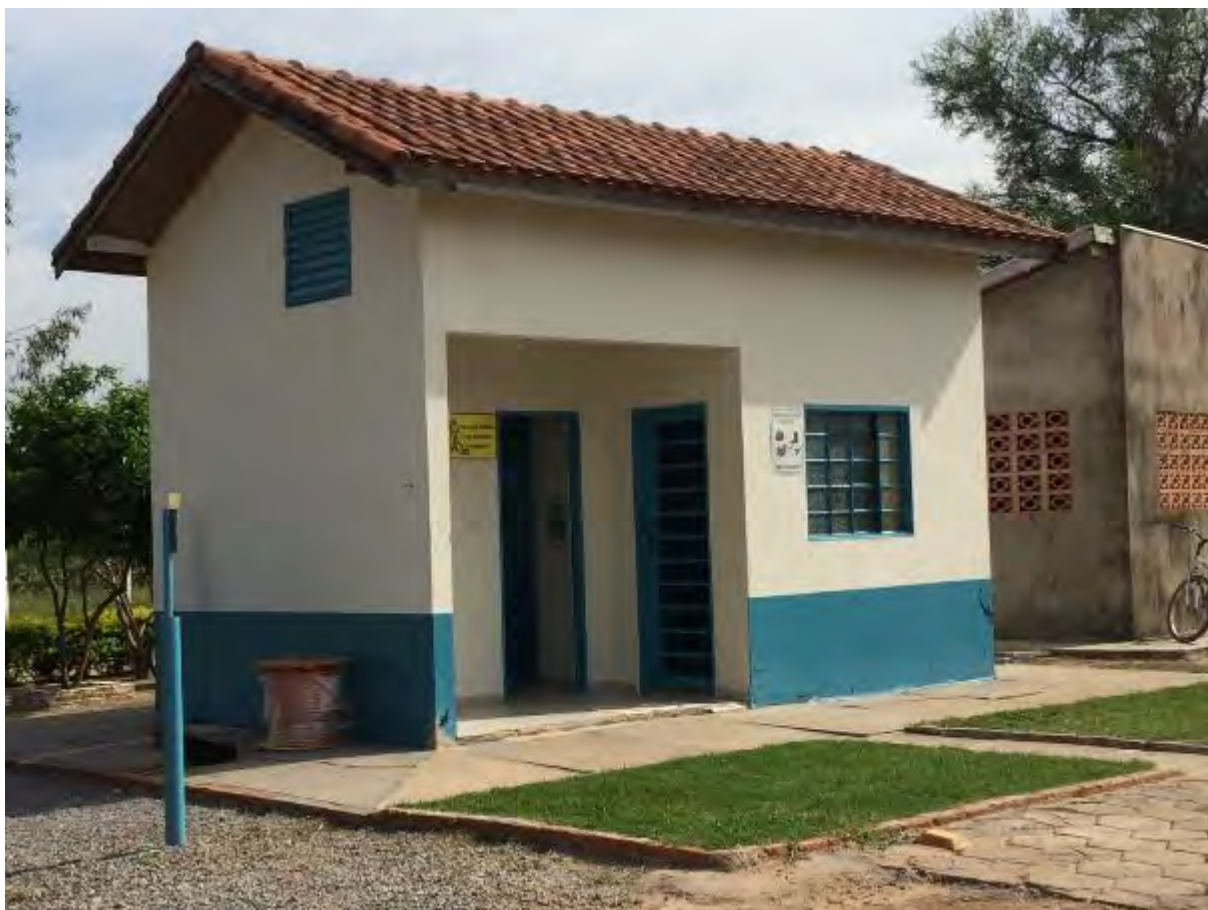
Figura 29: Vista do prédio do laboratório da ETE de Porto Murtinho.
