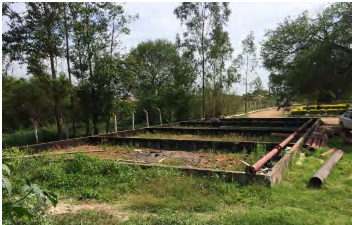
Figura 43: Vista da obra de execução de 3 células de leitos de secagem de lodo da ETE de Porto Murinho, inconclusa.
