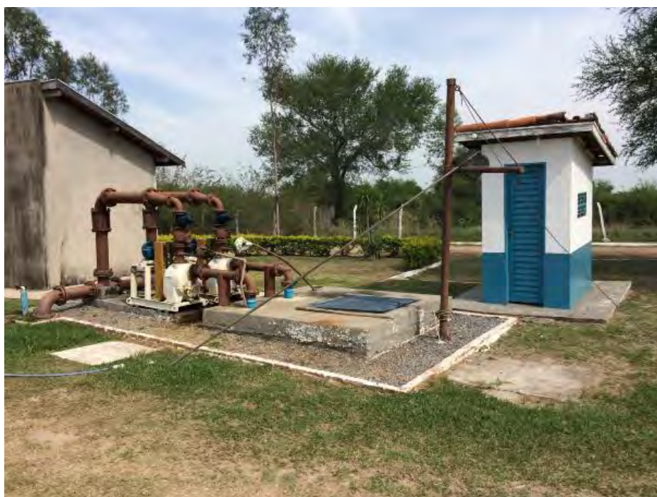
Figura 6: Vista da EEEB 01 - Final (ETE) de Porto Murtinho.
