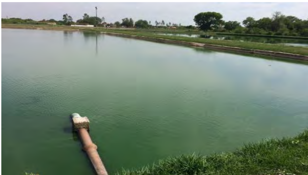
Figura 26: Vista da saída da Lagoa de Maturação 1 - ETE Porto Murinho
