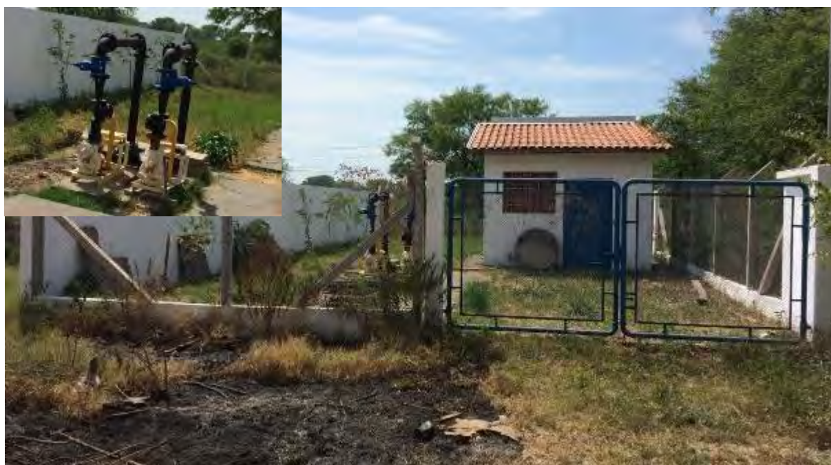
Figura 20: Vistas da EEEB 10 - Camalote de Porto Murтинho.
