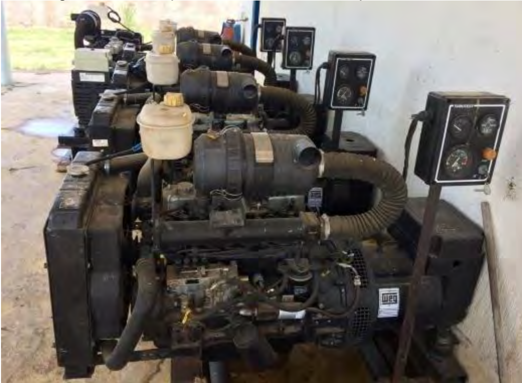
Figura 38: Foto de 5 grupos geradores que não foram instalados nas elevatórias.
