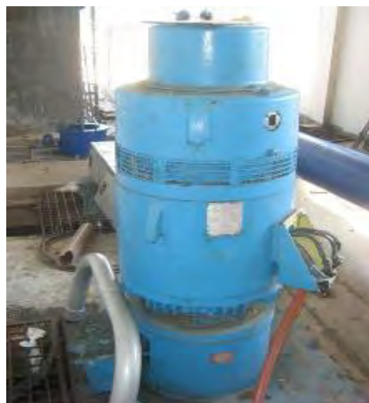
Figura 34: Vista de uma das bombas de drenagem, utilizada para ocasião de cheia do Rio Paraguai
