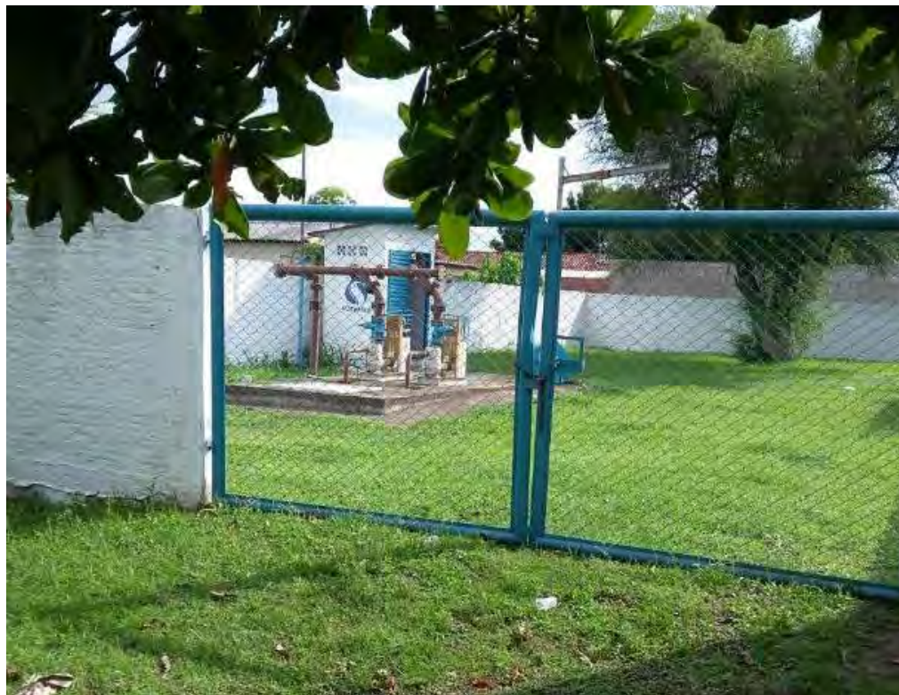
Figura 10: Vista da EEEB 04 - Florestal de Porto Murтинho.
