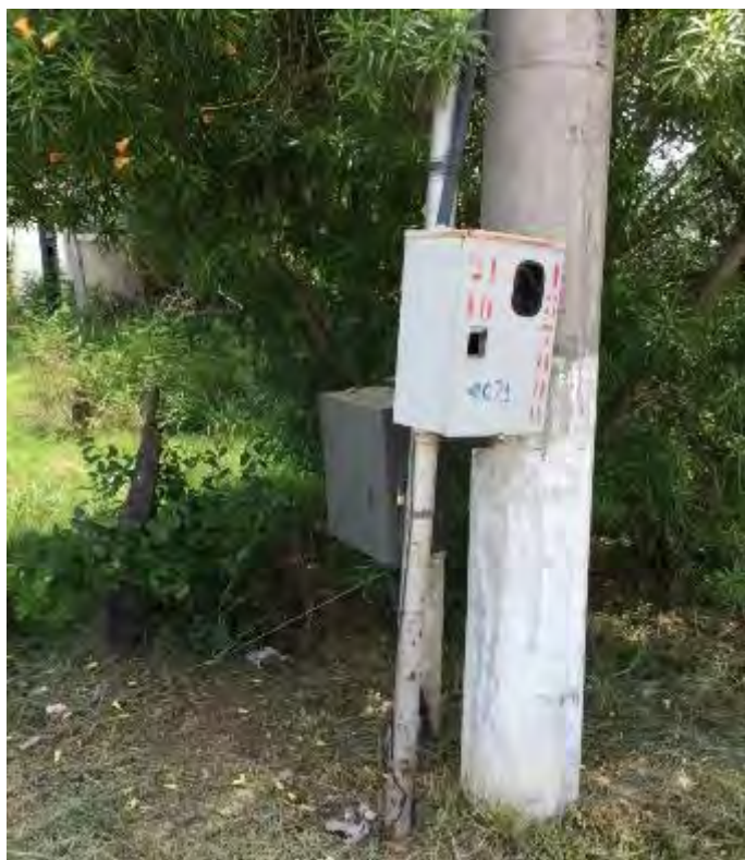
Figura 16: Poste onde estão instalados paliativamente a entrada de energia e o quadro de comando da elevatória provisória do subsistema 08.
