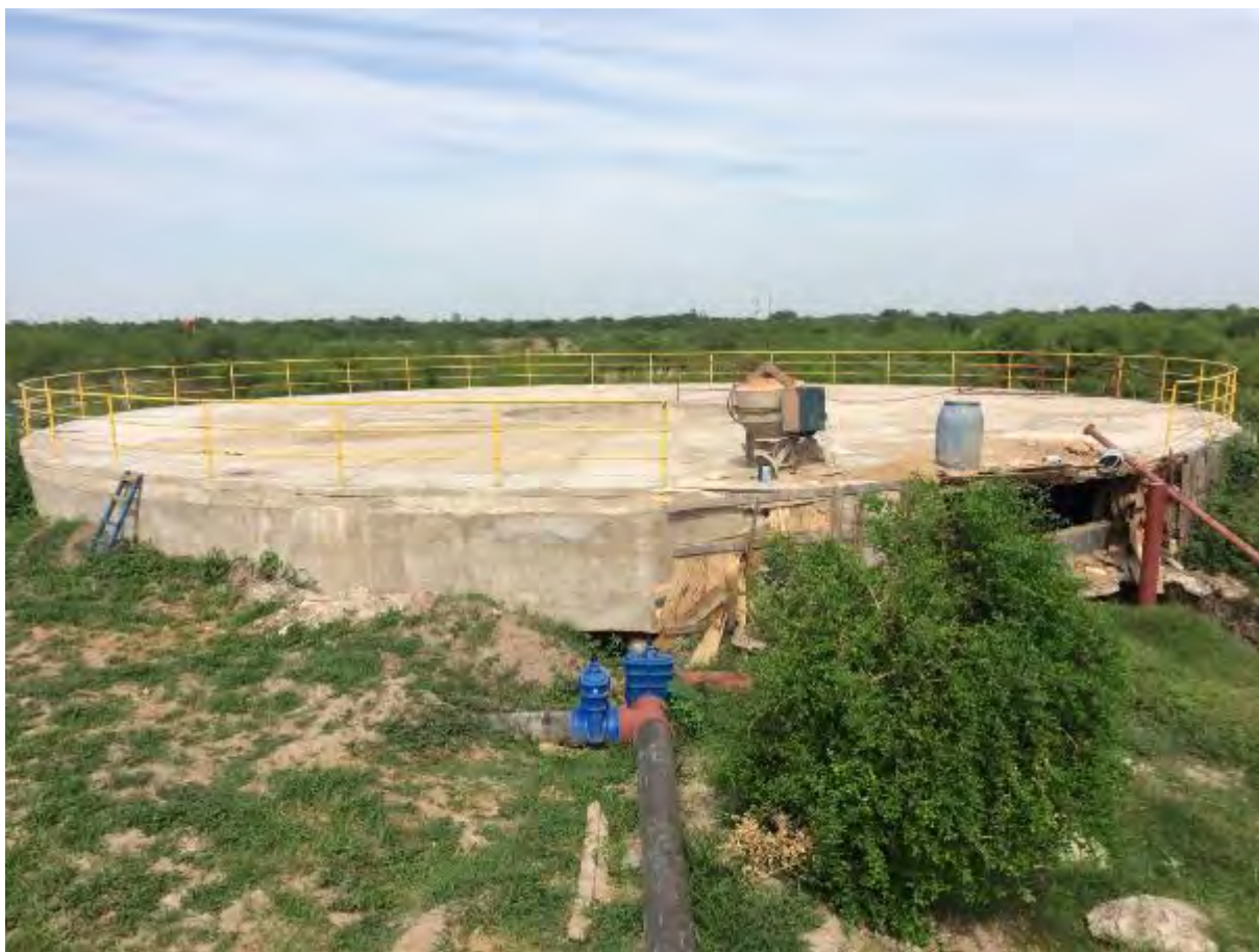
Figura 42: Vista da obra de execução do RALF da ETE de Porto Murinho, inconclusa, faltando a instalação dos dispositivos hidráulicos.
