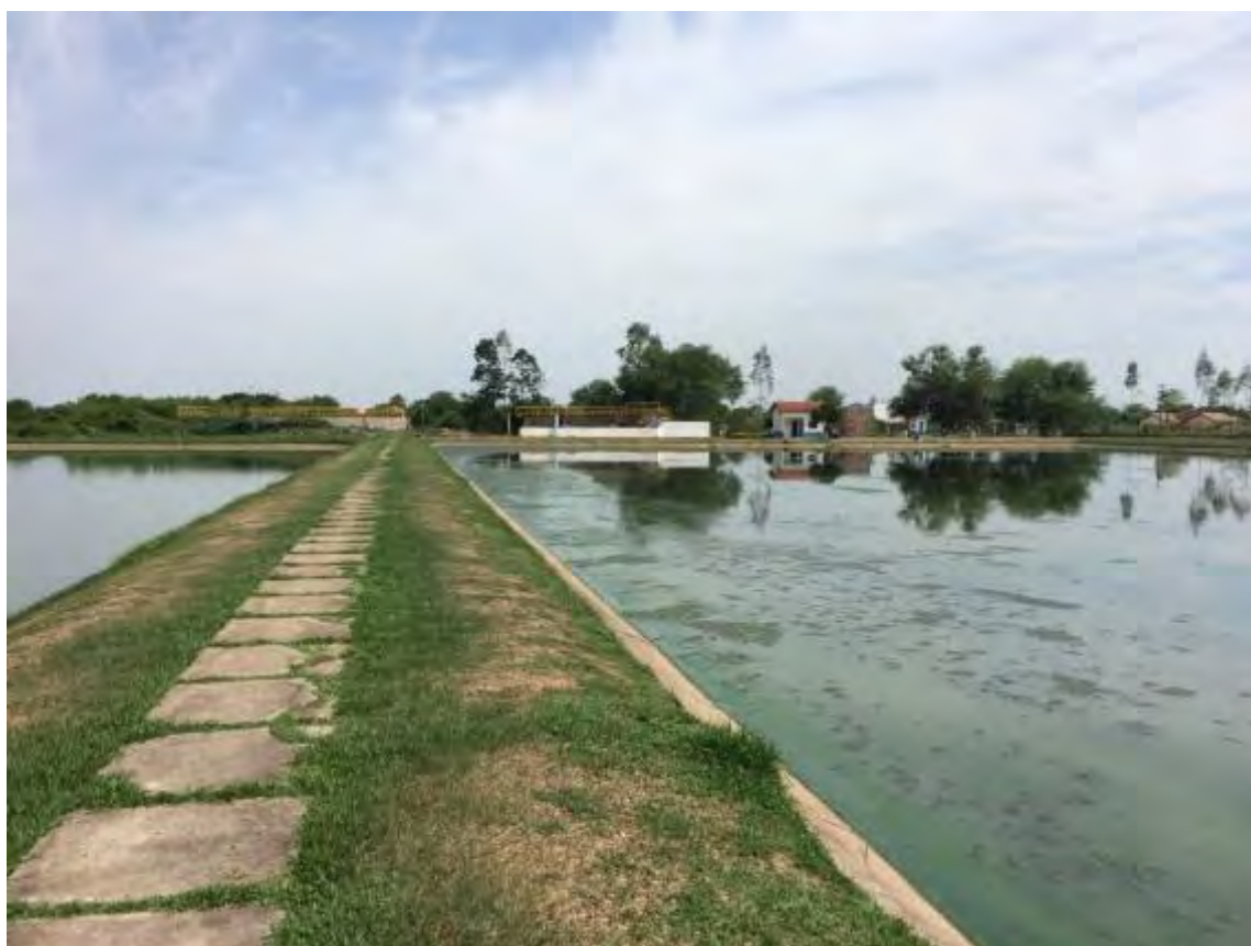
Figura 25: Outra vista das Lagoas Facultativas, ao fundo vê-se o desarenador e laboratório ETE Porto Murinho.
