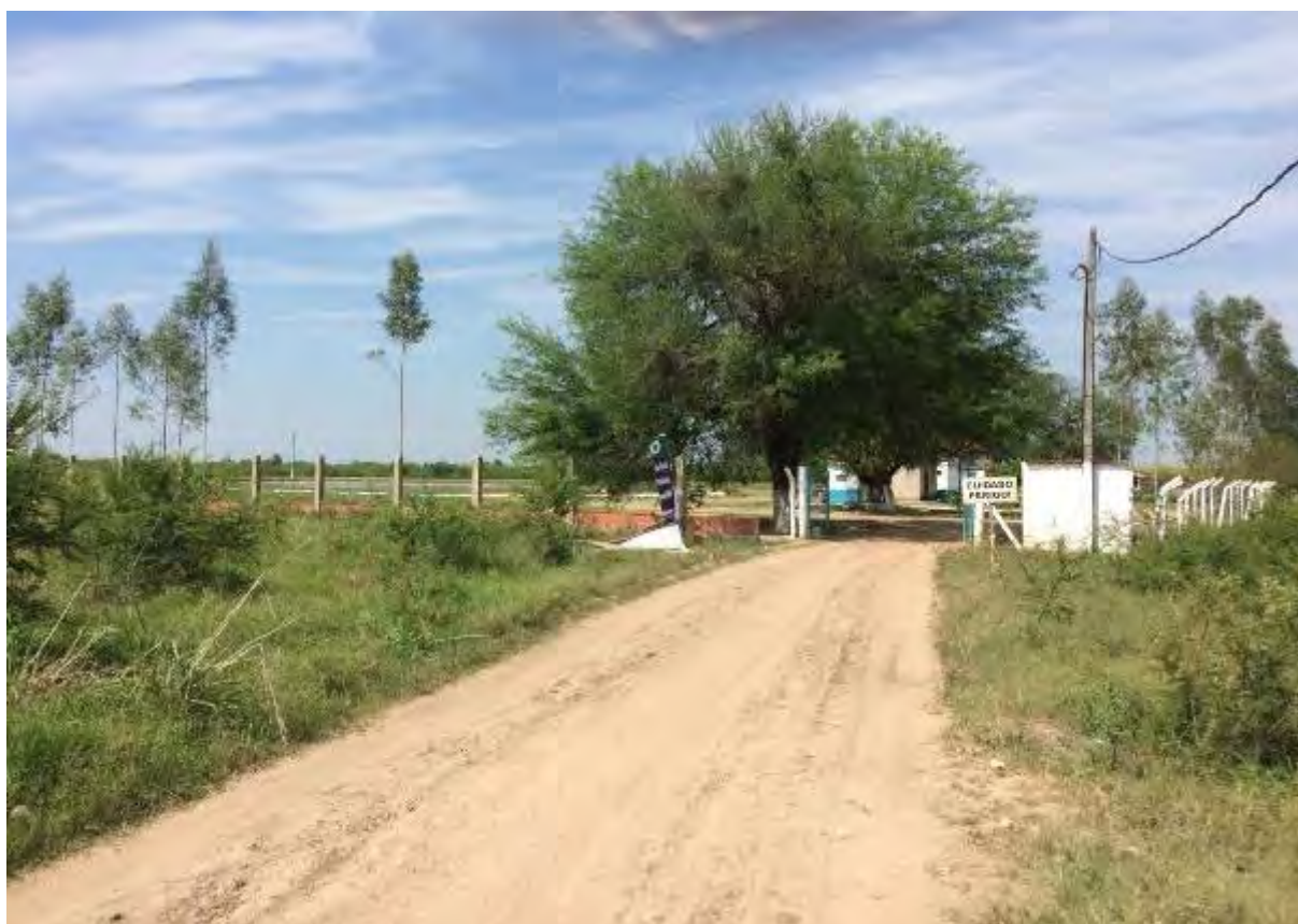
Figura 30: Vista do acesso da ETE de Porto Murinho, com cercamento da área com fios de arame liso sem urbanização com sansão-do-campo (cerca viva).
