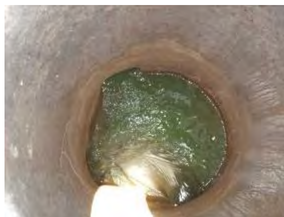
Figura 28: Vista do efluente final do esgoto tratado, saída das Lagoas de Maturação da ETE Porto Murinho.
