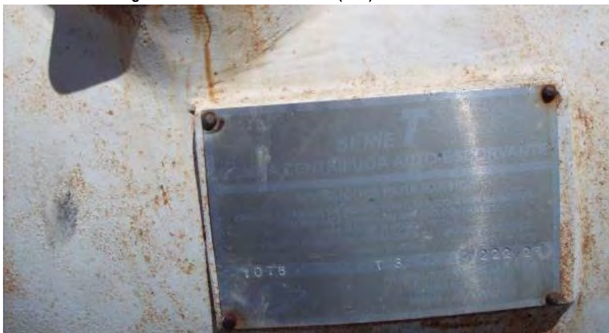
Figura 7: Plaqueta da bomba da EEEB 01 - Final (ETE) de Porto Murtinho.
