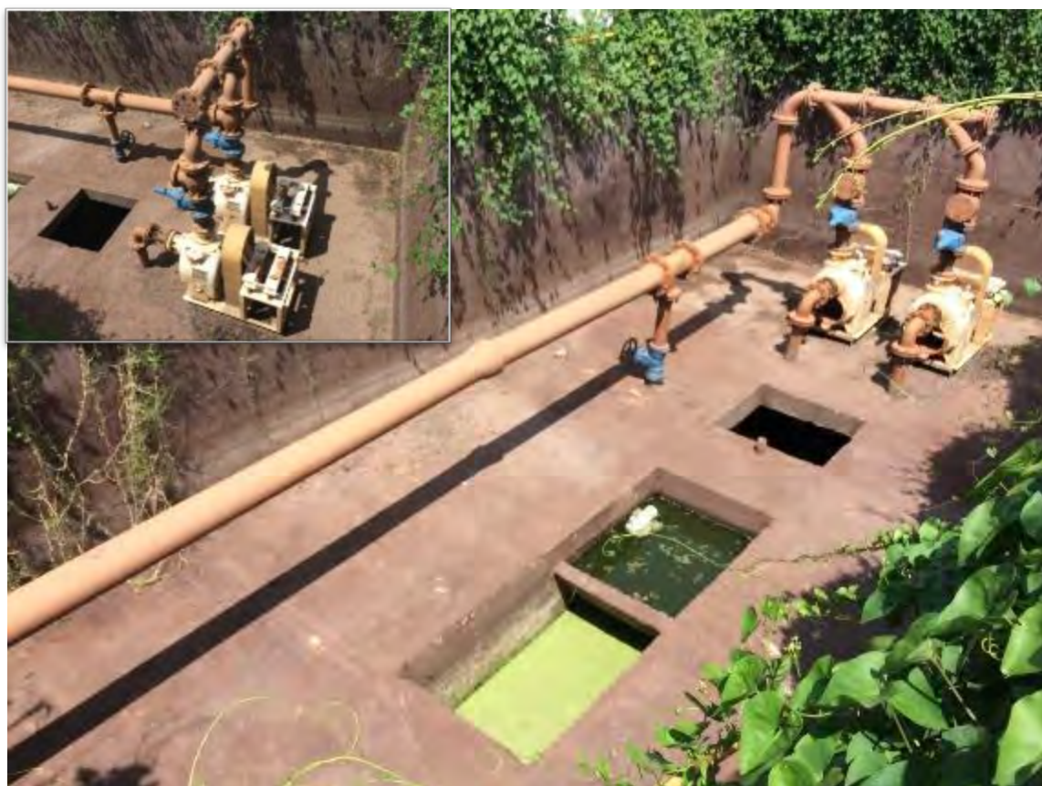
Figura 15: Vistas da EEEB 08 - Dom Pepe de Porto Murtinho. No detalhe nota-se a ausência dos motores e conjuntos girantes.
