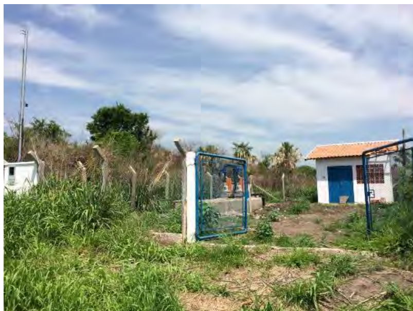
Figura 17: Vista da EEEB 09 - Che Roga Mi de Porto Murinho.
