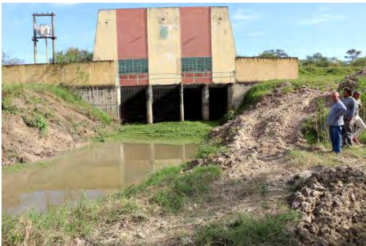
Figura 32: Vista da estrutura da casa de bombas, dotada de dispositivos para lançamento das águas da vala de drenagem da cidade de Porto Murtinho para o Rio Paraguai.
