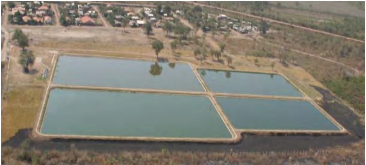
Figura 21: Vista aérea da Estação de Tratamento de Esgoto, Prefeitura Municipal - 2008.
