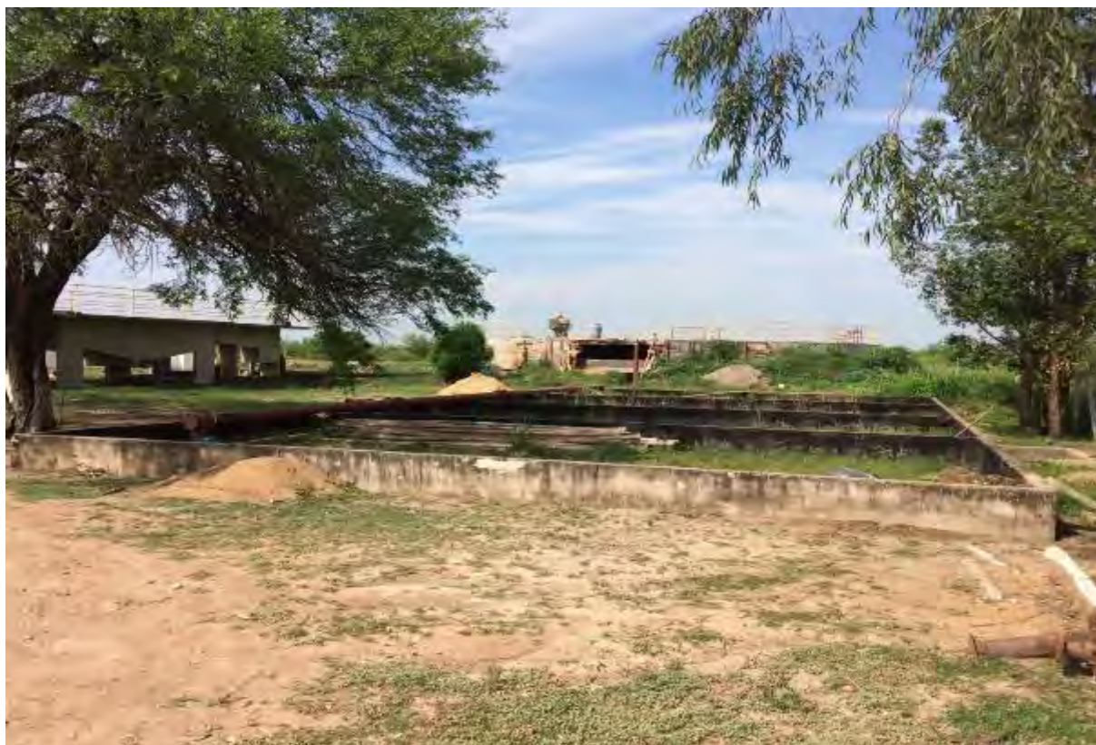
Figura 40: Vista da obra de ampliação e melhoria da ETE de Porto Murтинho, em primeiro planos leitos de secagem de lodo, à esquerda desarenador novo e ao fundo RALF.
