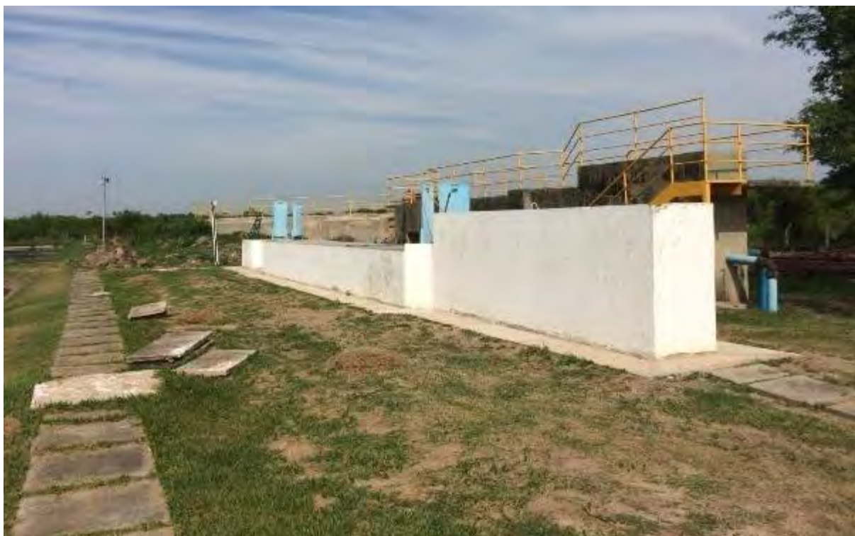
Figura 23: Vista do tratamento preliminar da ETE de Porto Murinho.
