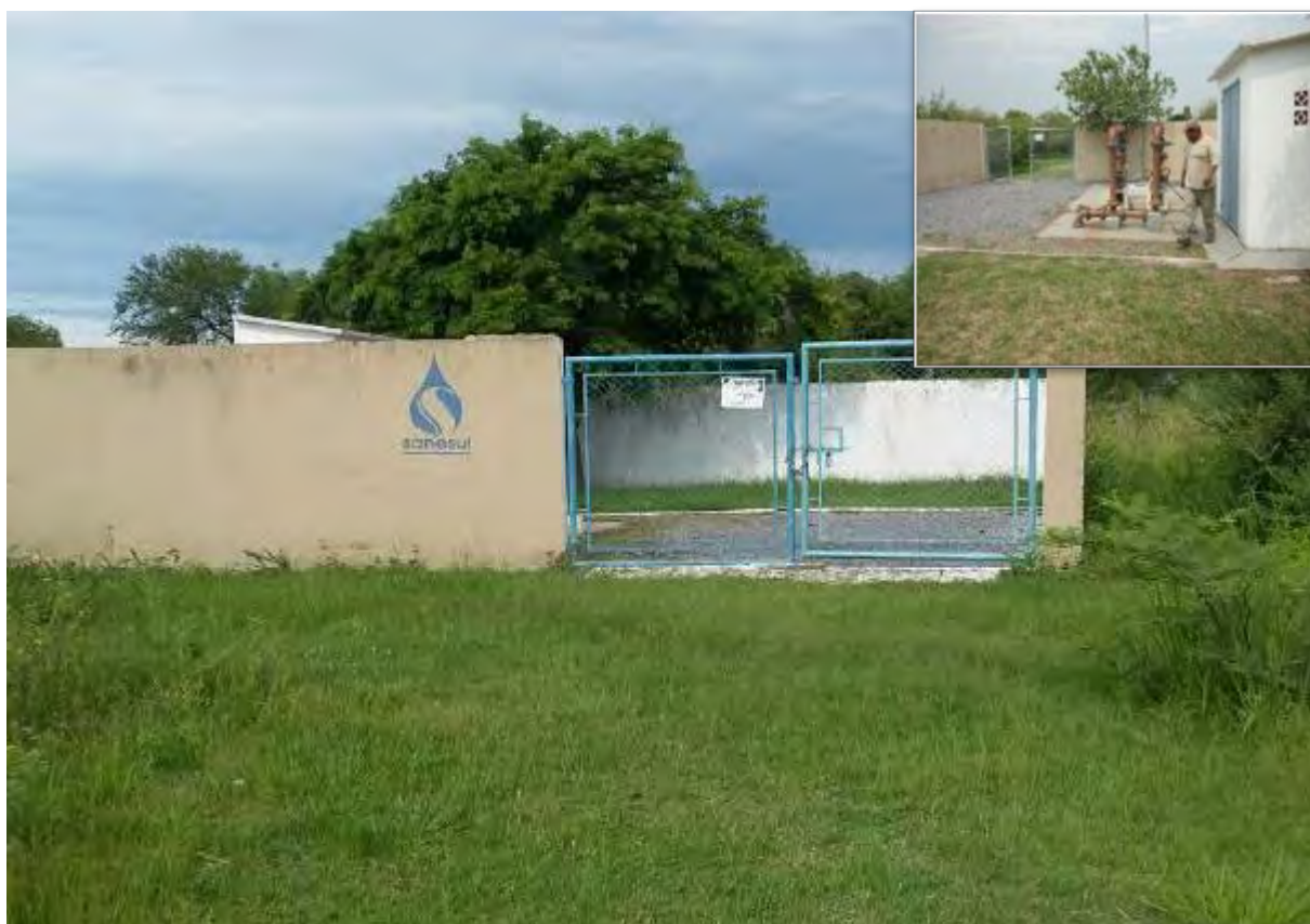
Figura 13: Vistas da ETEB 07 - Novo Habitar de Porto Murtinho.
