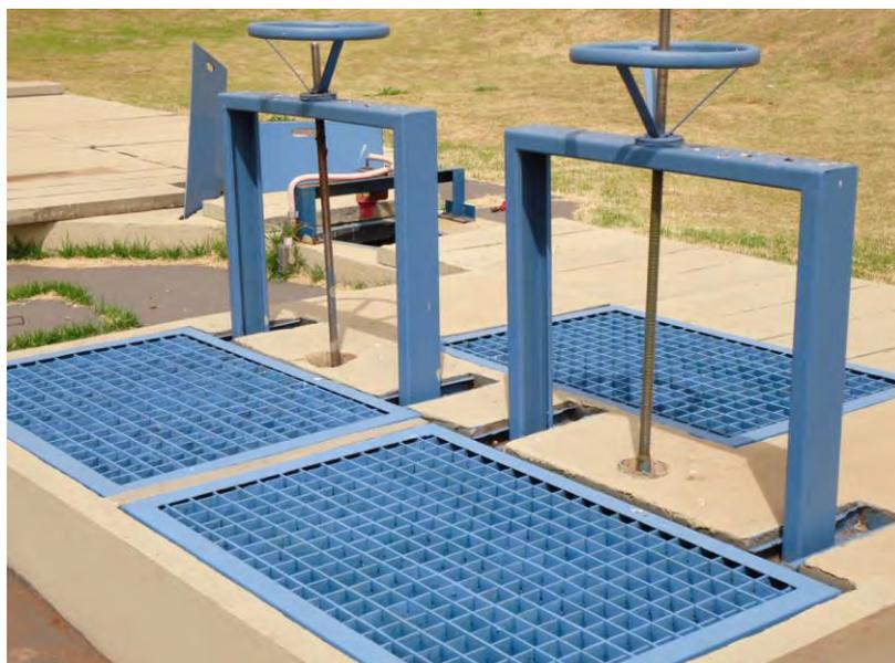
**Figura 37: Caixa distribuidora de vazão (CDFL1)**
