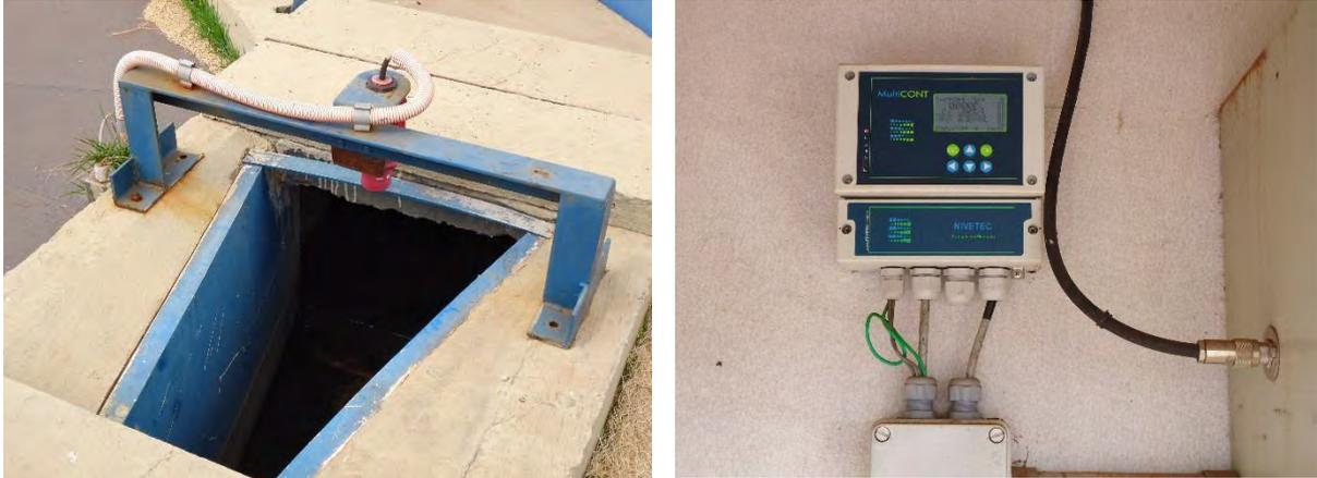
**Figura 36: Calha Parshall e Medidor de vazão Ultrassônico**
