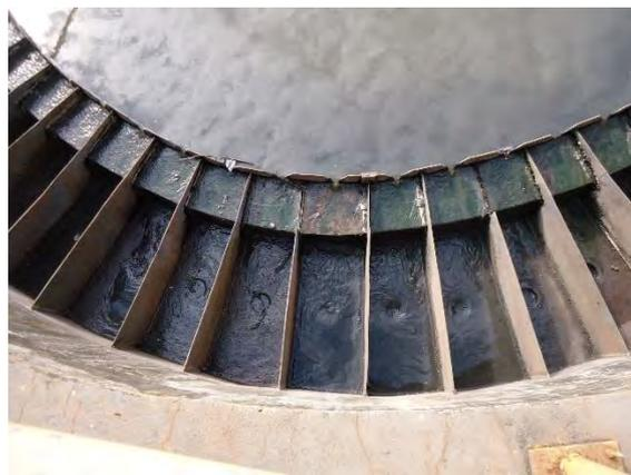
**Figura 22: Detalhe entrada do esgoto no RALF – ETE Estoril**
