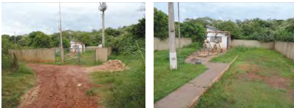
Figura 9: Vista geral da EEEB 007, Ponta Porã, MS.
