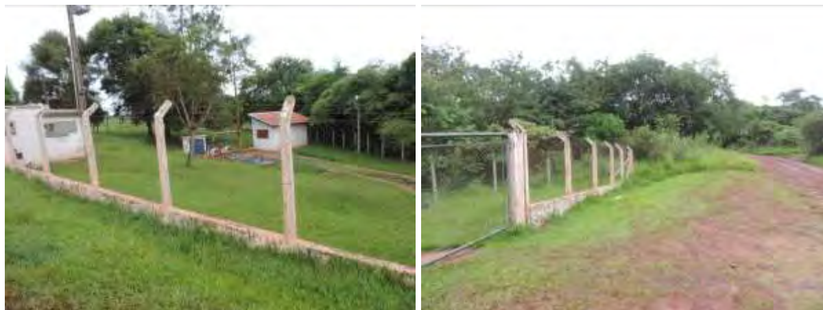
Figura 6: Vista geral da EEEB 4.1, Ponta Porã, MS.
