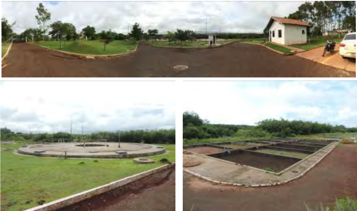
Figura 2: Vista da geral da ETE Estoril, Ponta Porã, MS.
