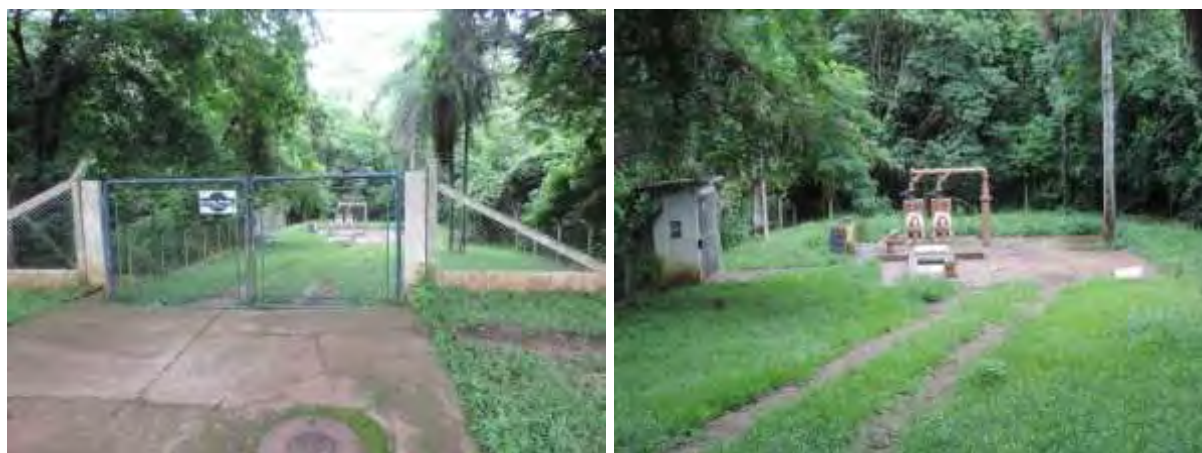
Figura 7: Vista geral da EEEB 5.1, Ponta Porã, MS.
