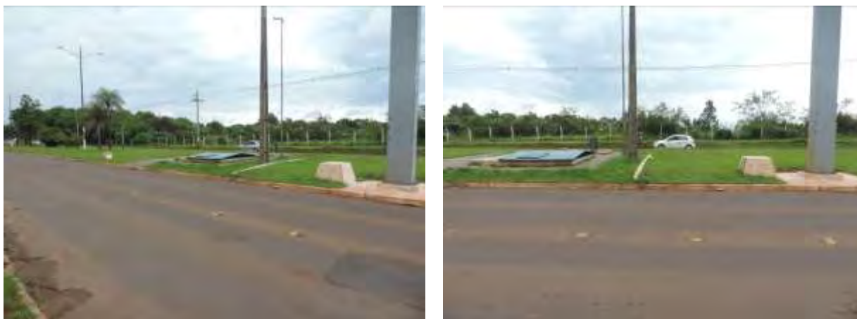
Figura 8: Vista geral da EEEB 006, Ponta Porã, MS.
