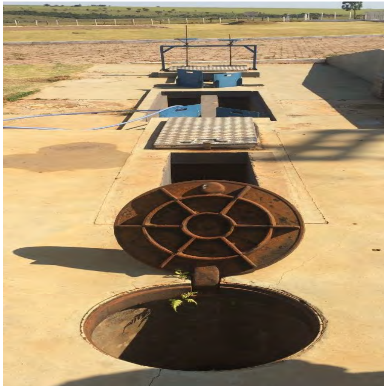
Figura 12: Vista geral do Tratamento Preliminar.
