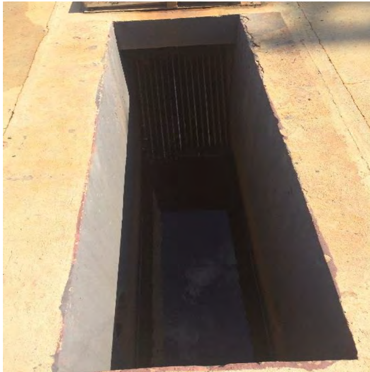
Figura 13: Gradeamento da ETE.
