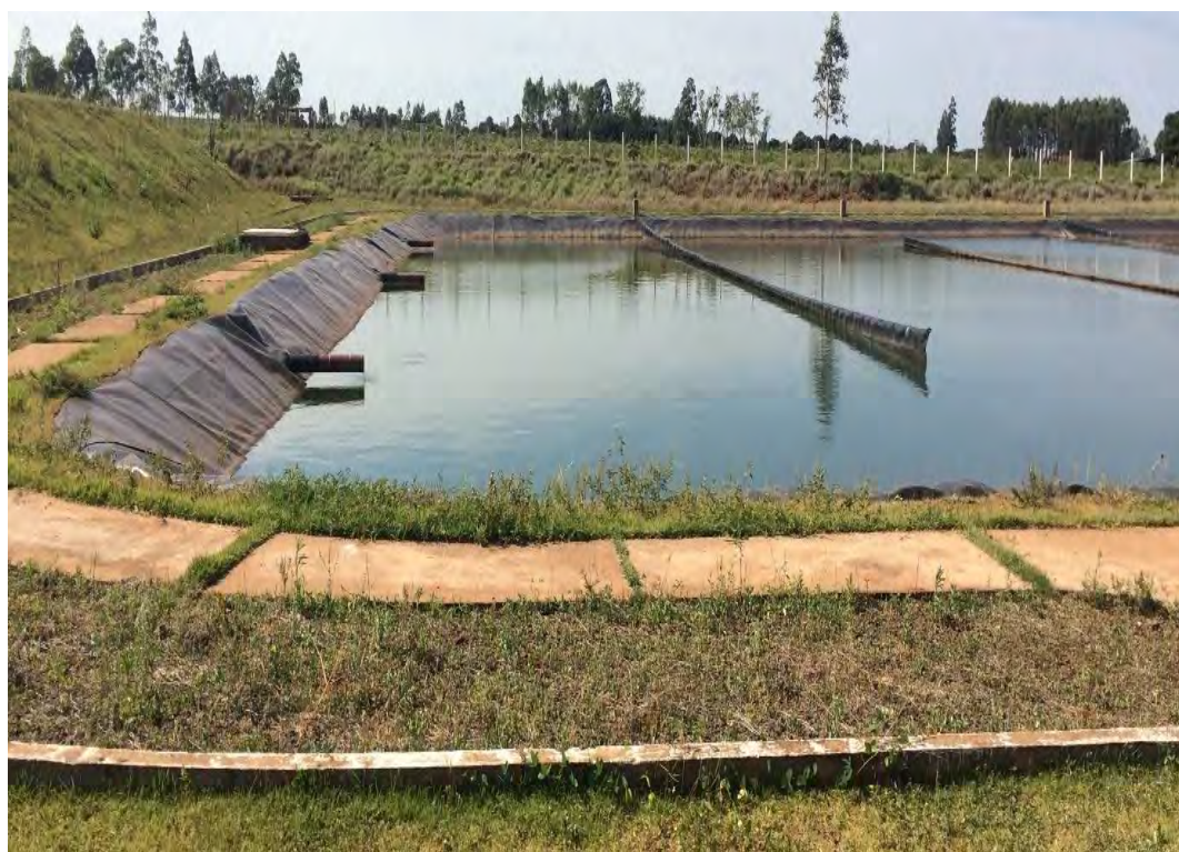
Figura 22: Entradas Lagoa de Maturação.
