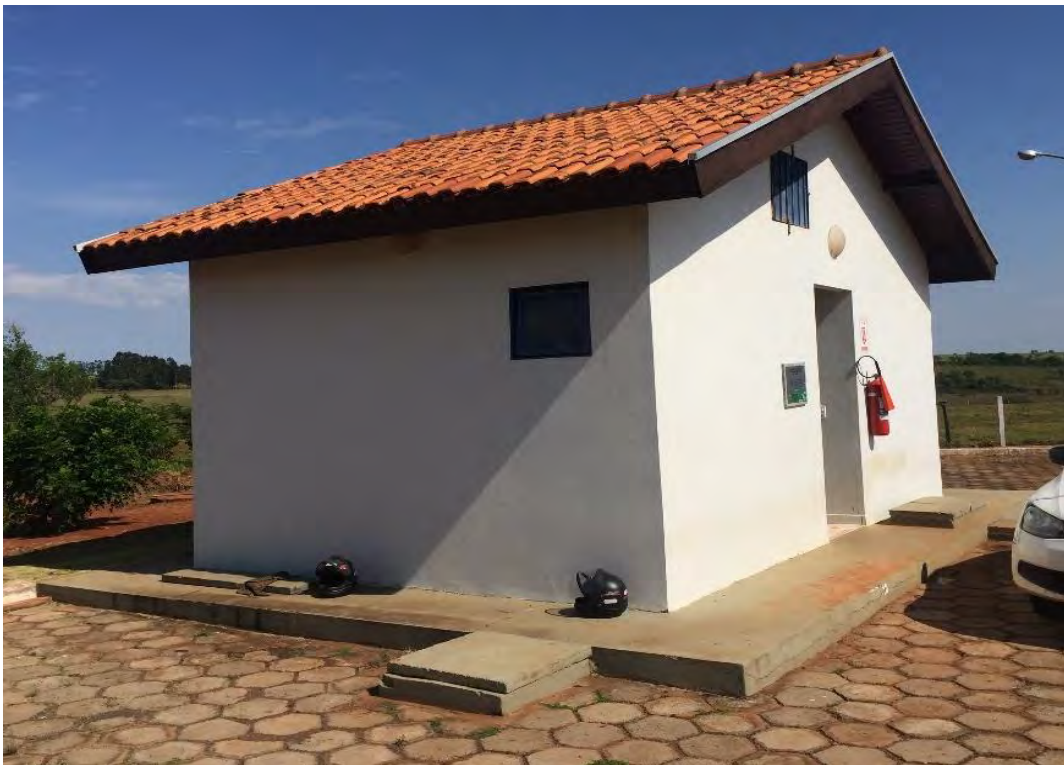
Figura 23: Prédio administrativo e laboratório.
