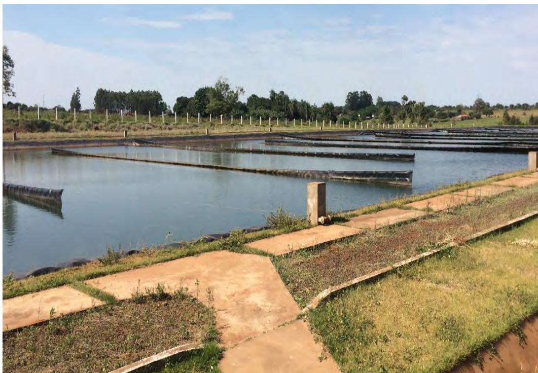
Figura 21: Chicanas Lagoa de Maturação.
