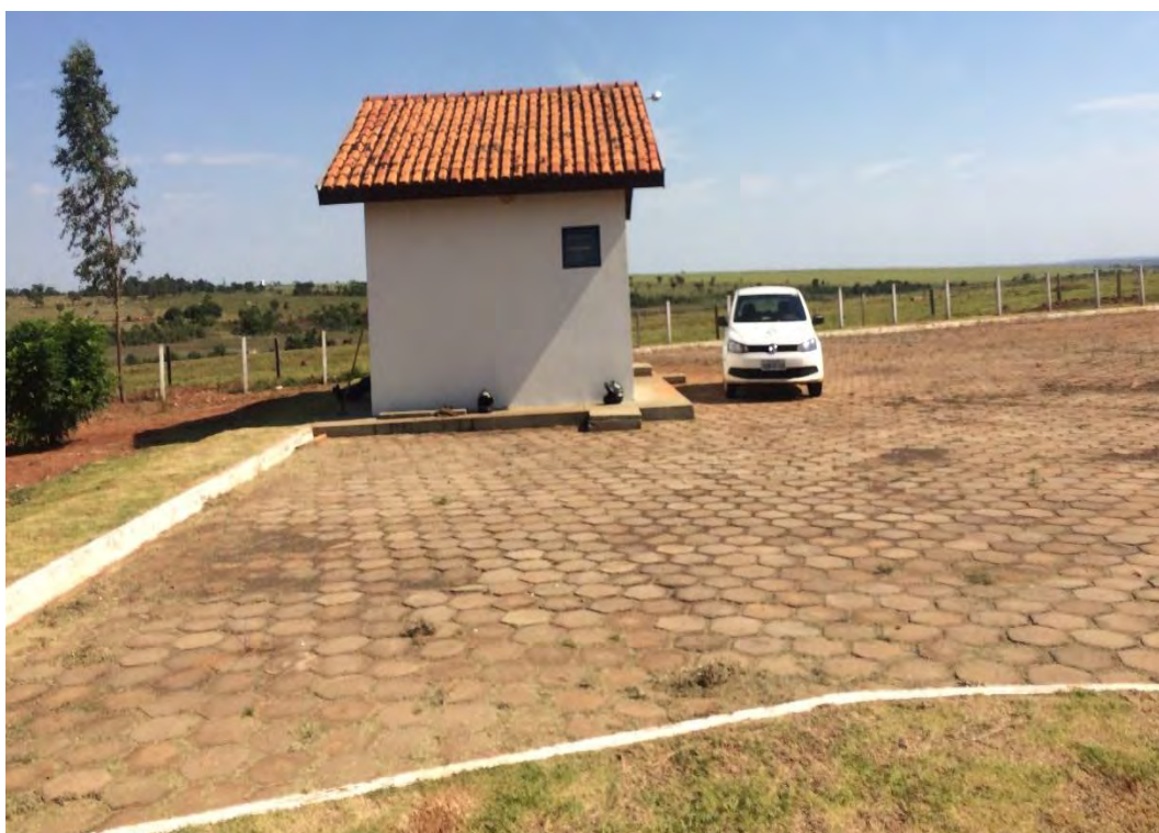
Figura 27: Rua interna e prédio administrativo da ETE.
