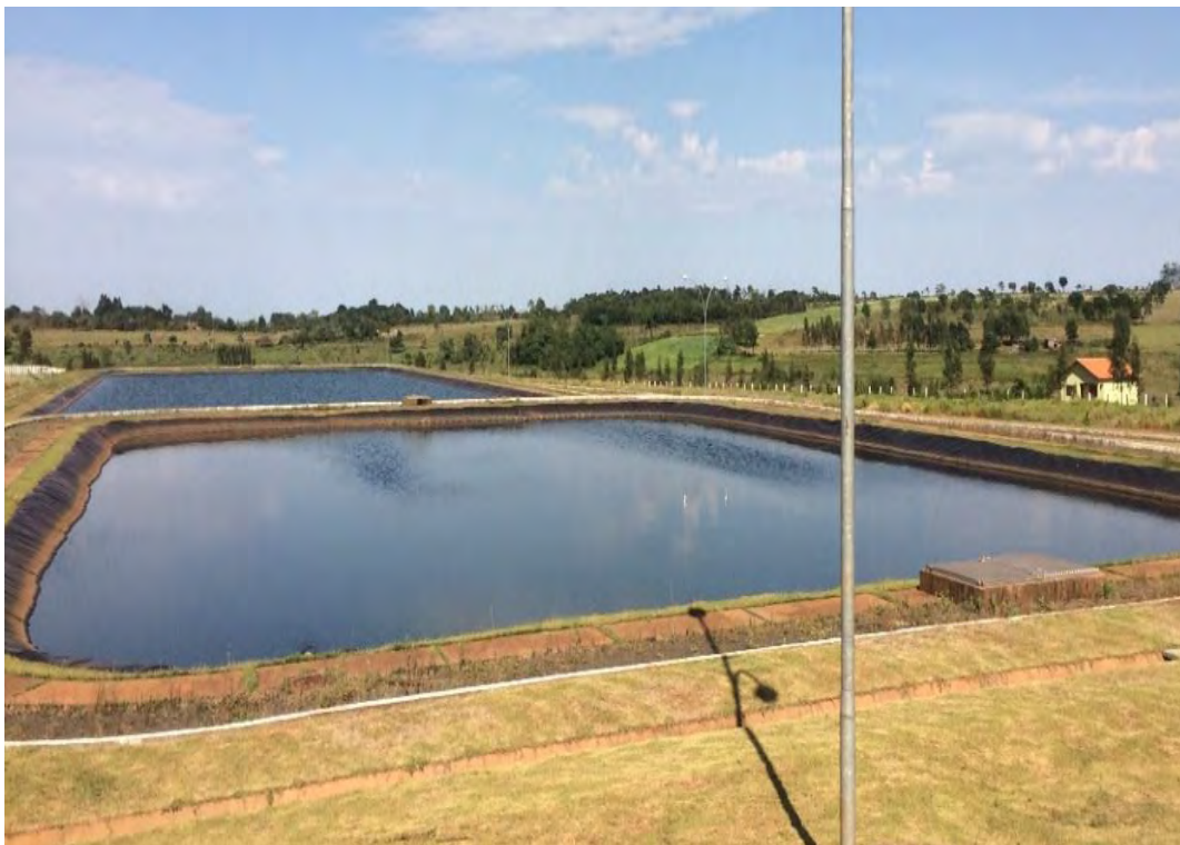
Figura 16: Lagoa Anaeróbia e caixa de distribuição.
