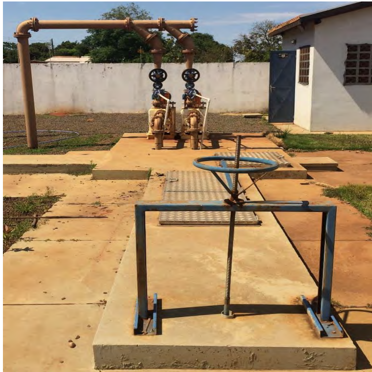
Figura 8: Vista superior do PV de chegada, poço de sucção e bombas Re-autoescorvantes.
