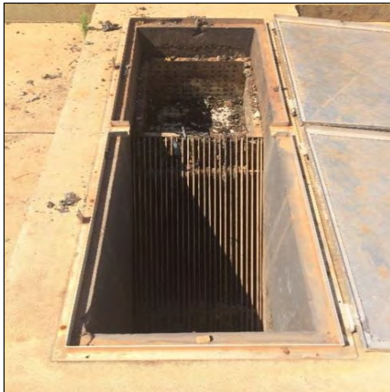
Figura 7: Gradeamento da EEEB.
