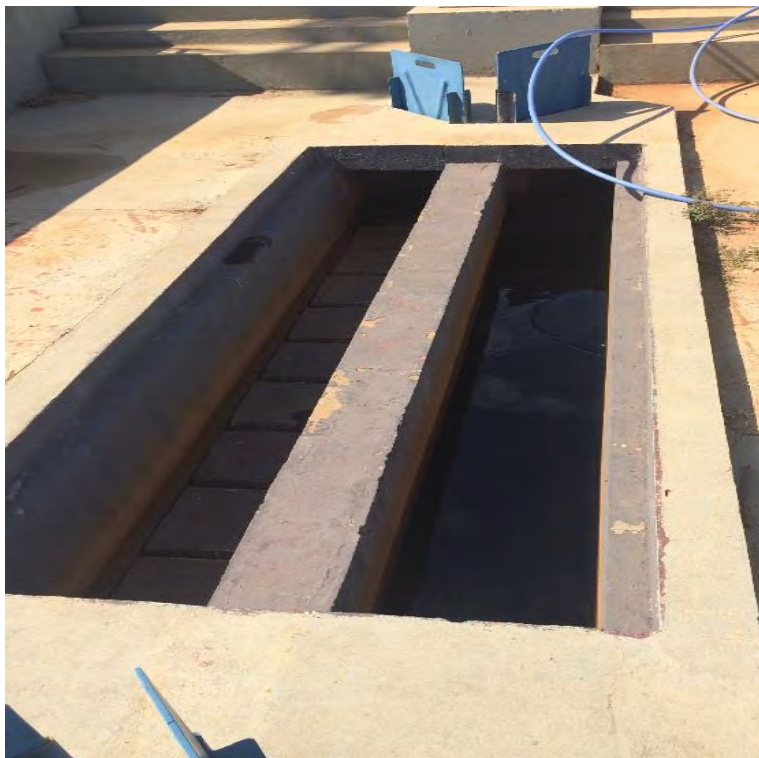
Figura 14: Desarenador.
