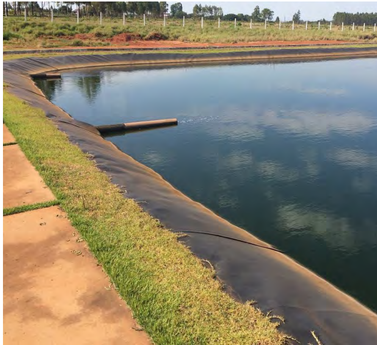
Figura 17: Entrada do efluente na Lagoa Anaeróbia.
