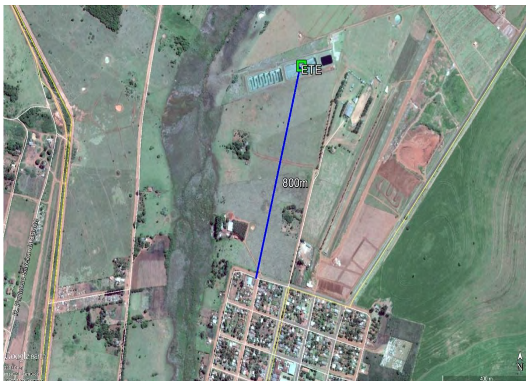
Figura 25: Visão geral da ETE Paranhos.
