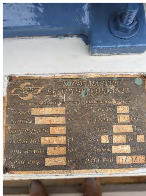
Placa de identificação da bomba
