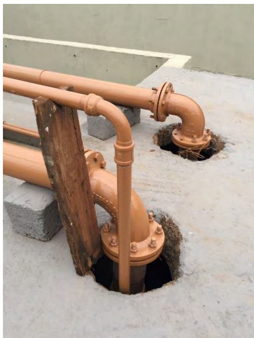
Vista externa poço de sucção
