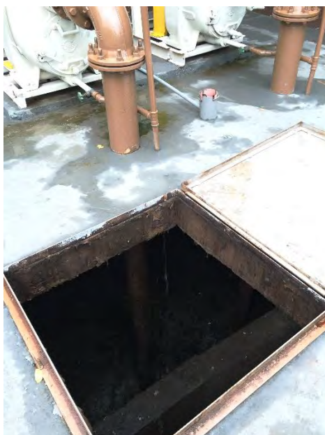
Poço de sucção
