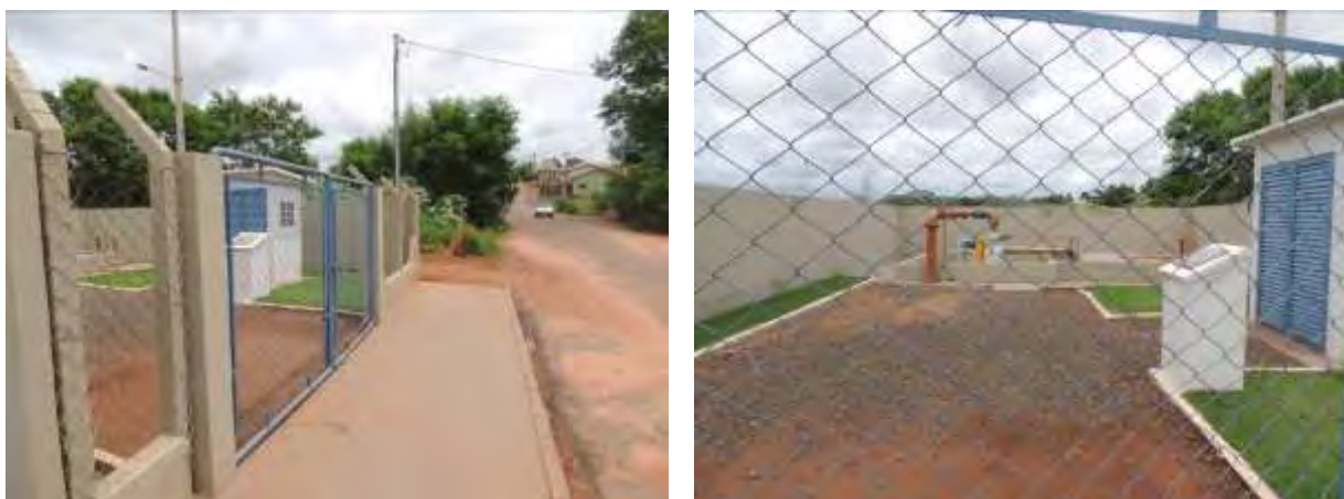
Figura 5: Vista geral da EEEB 01, Paranaíba, MS.
