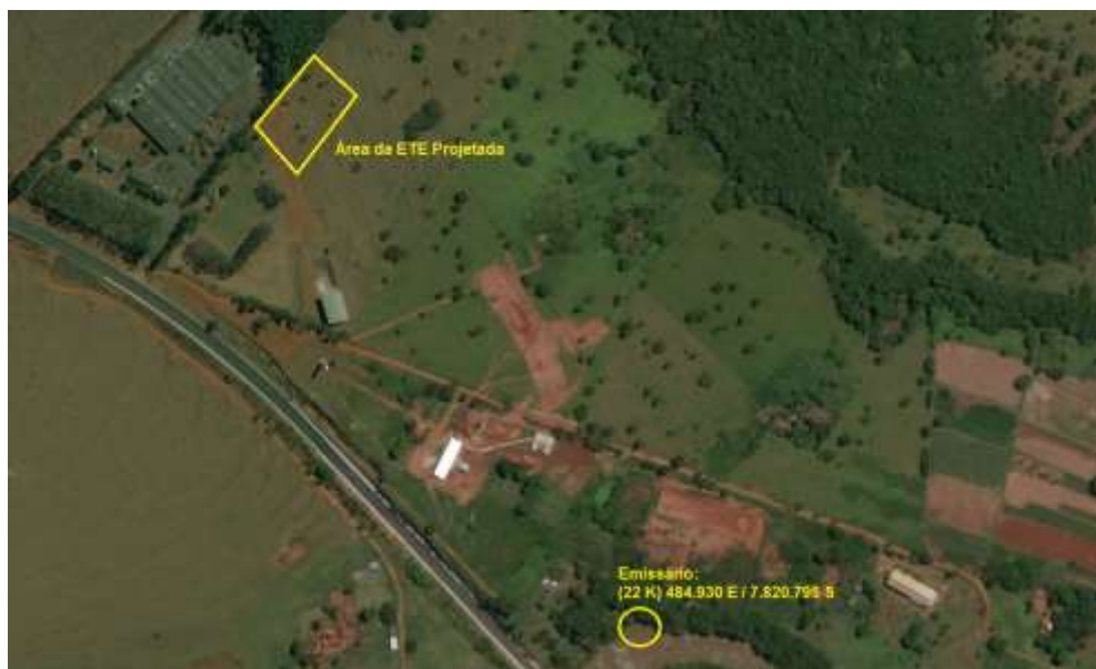
Figura 8: Vista da área pretendida da ETE Paranaíba Projetada, Paranaíba, MS.
