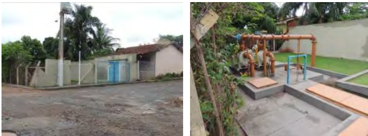
Figura 6: Vista geral da EEEB 002, Paranaíba, MS.
