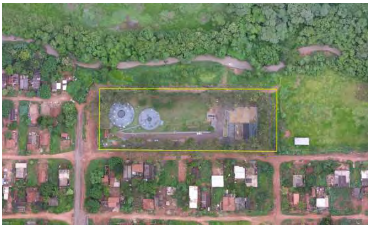
Figura 2: Vista aérea da ETE Paranaíba, Paranaíba, MS.
