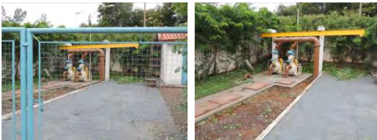
Figura 7: Vista geral da EEEB 03, Paranaíba, MS.
