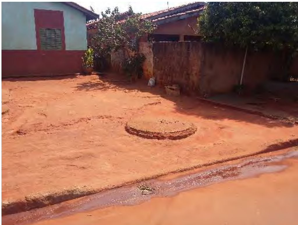
Figura 6: Vista da fossa-sumidouro de Anaurilândia.
