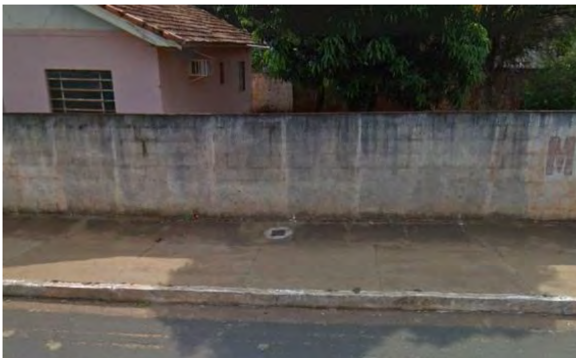
Figura 4: Caixa do Ramal Condominial existente em Anaurilândia.
