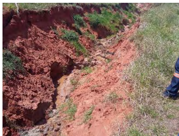
Figura 10: Erosão causada pela enxurrada no percurso da linha de recalque da EEET – NEP-ETE.
