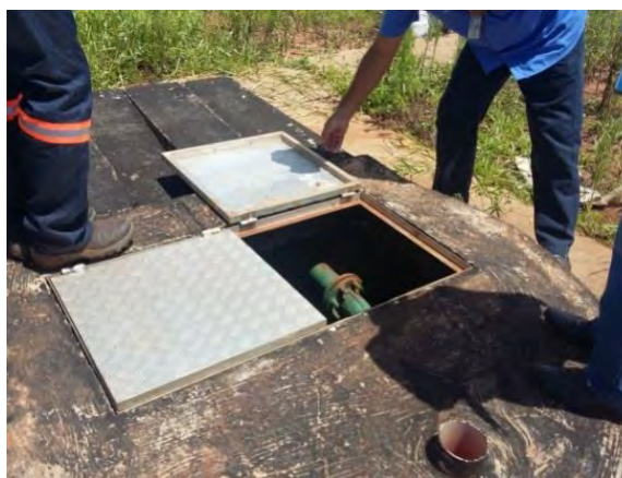
Figura 8: Caixa de Barrilete da EEET – NEP-ETE.
