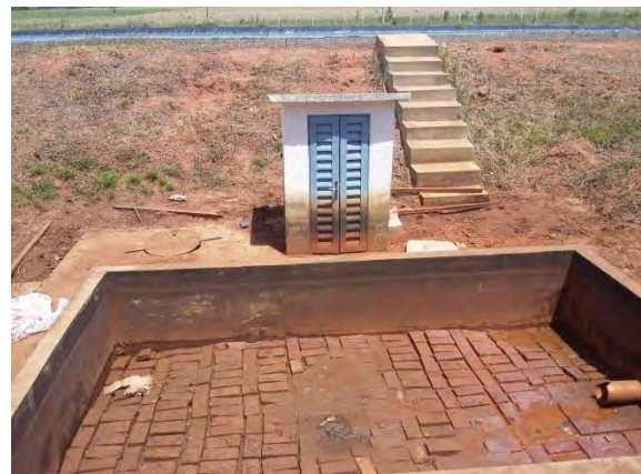
Figura 14: Caixa de areia da ETE de Nova Esperança.
