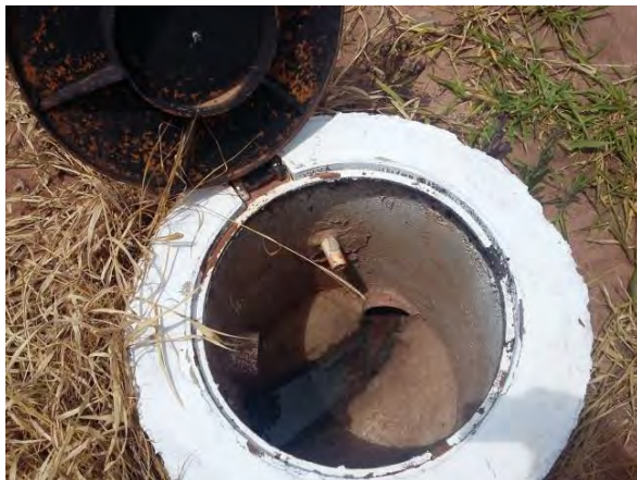
Figura 11: PV de entrada na ETE Nova Esperança.
