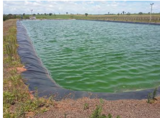
Figura 16: Vista 2 da lagoa facultativa da ETE Nova Esperança.
