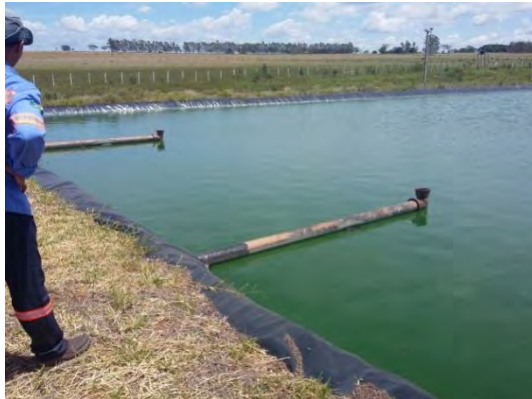
Figura 15: Vista 1 da lagoa facultativa da ETE Nova Esperança.
