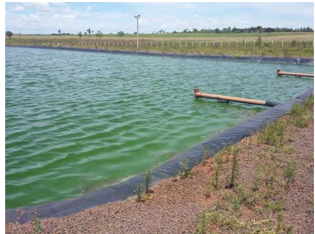
Figura 21: Área interna da ETE Nova Esperança.
