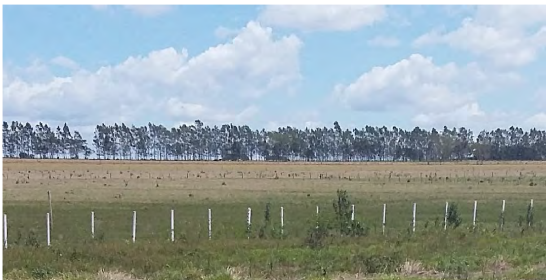
Figura 22: Cercamento lateral e de fundo da ETE Nova Esperança.
