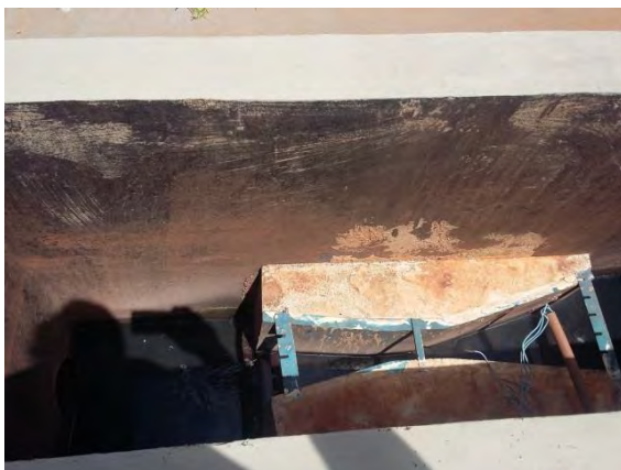
Figura 13: Calha Parshall 3" da ETE de Nova Esperança.
