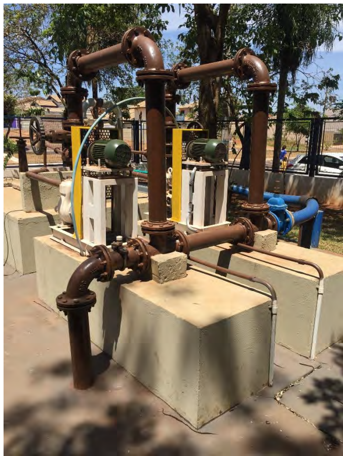
Figura 7: Conjunto Moto-bomba e barrilete de recalque
