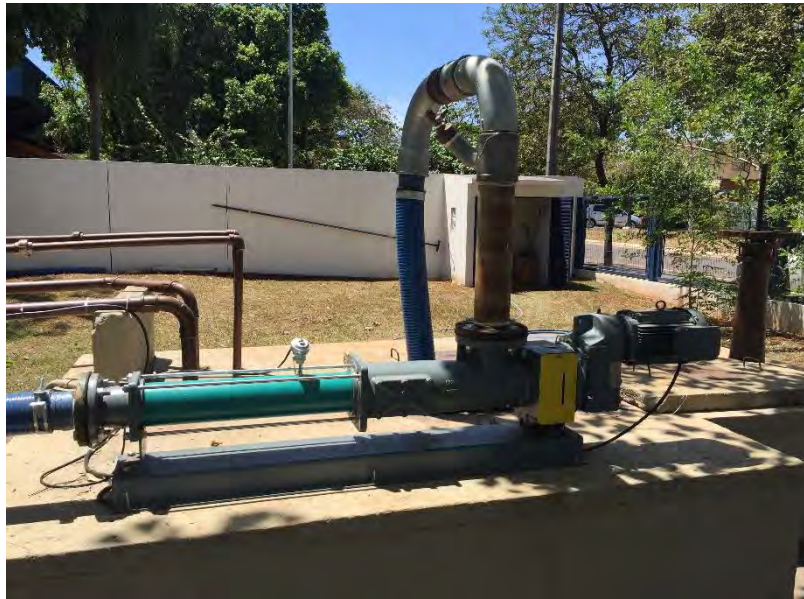
Figura 6: Bomba Nemo em teste
