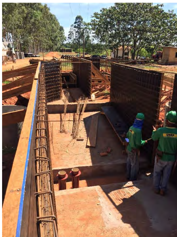
Novo tratamento preliminar em execução
