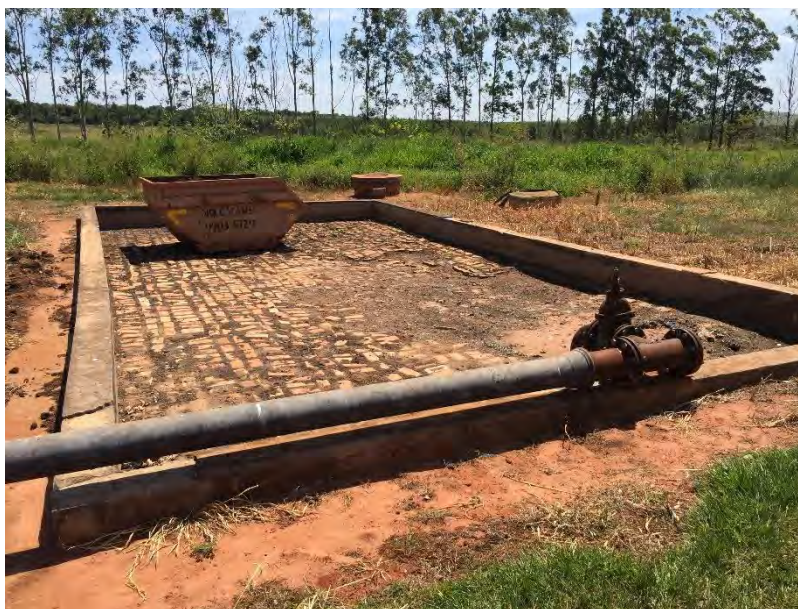
Figura 17: Leito de secagem
