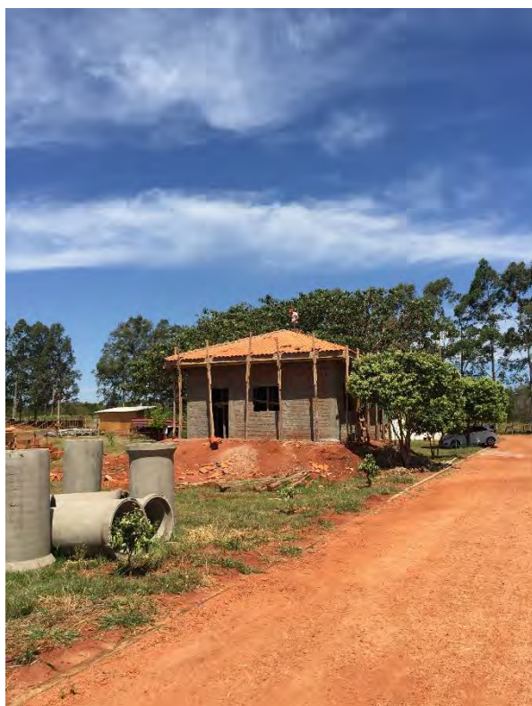
Nova sede operacional em execução
