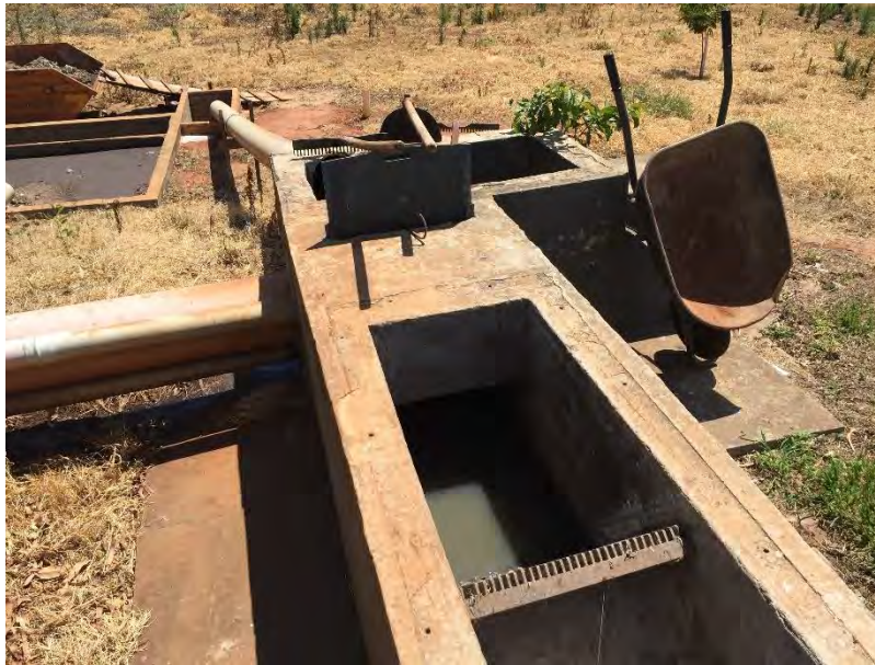
Figura 12: Gradeamento Manual e Caixa de Manobra para extravazão
