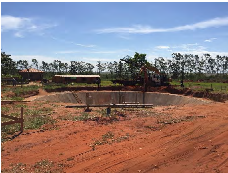
Figura 20: Novo reator tipo RALF em construção
