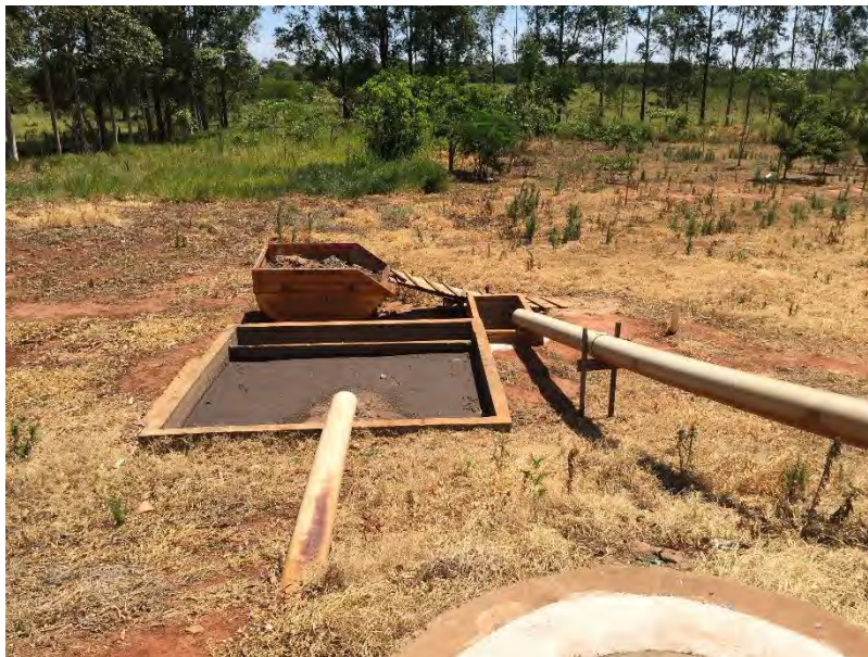
Figura 13: Caixa para acúmulo e secagem da areia retida no desarenador
