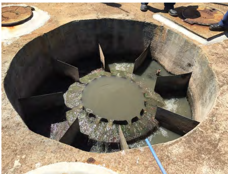
Figura 16: Entrada do reator
