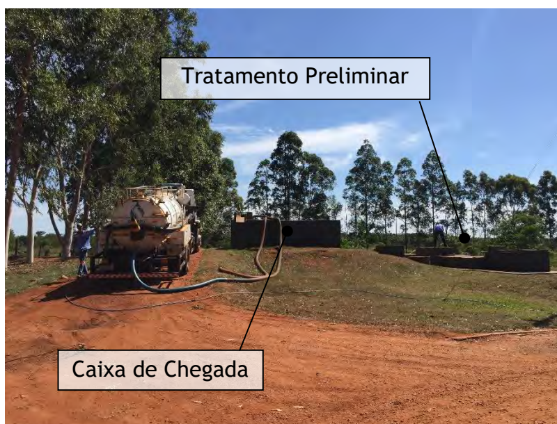
Figura 11: Caixa de Chegada e Tratamento Preliminar
