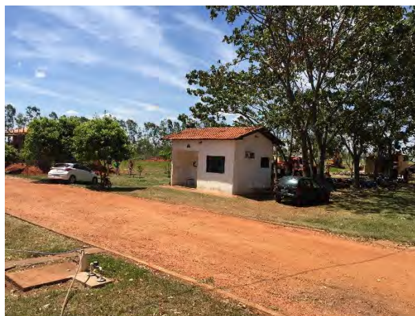
Centro Operacional da ETE
