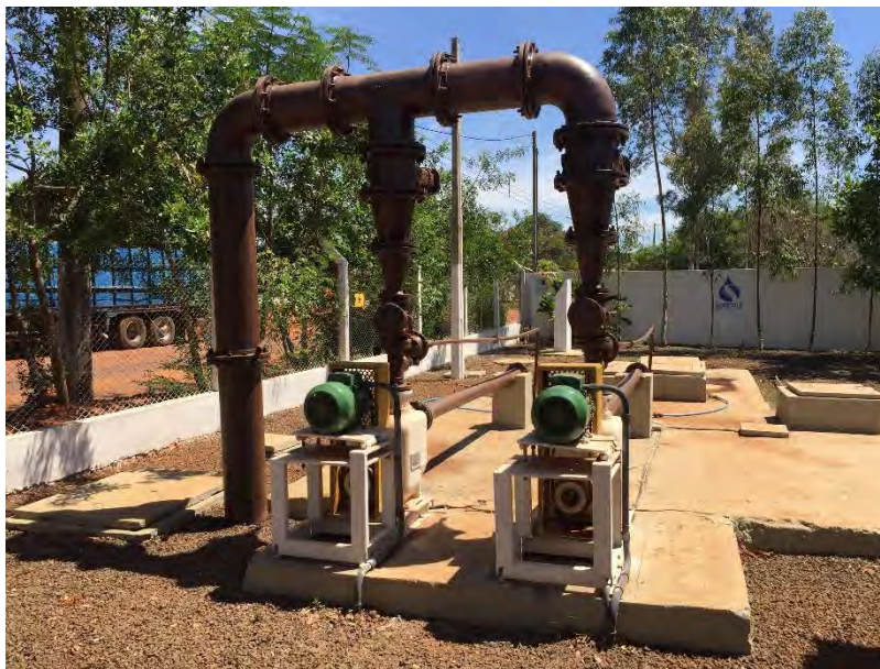
Figura 9: Conjunto Moto-bomba e barrilete de recalque
