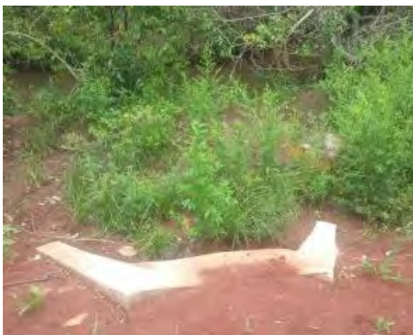
Figura 21: Vista 1 da estrutura do emissário da ETE Nova Alvorada do Sul no ponto de lançamento.
