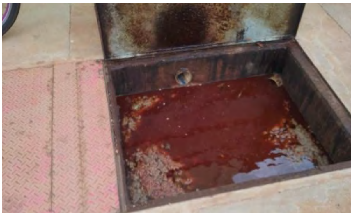
Figura 6: Caixa de gordura do restaurante, em Nova Alvorada do Sul.
