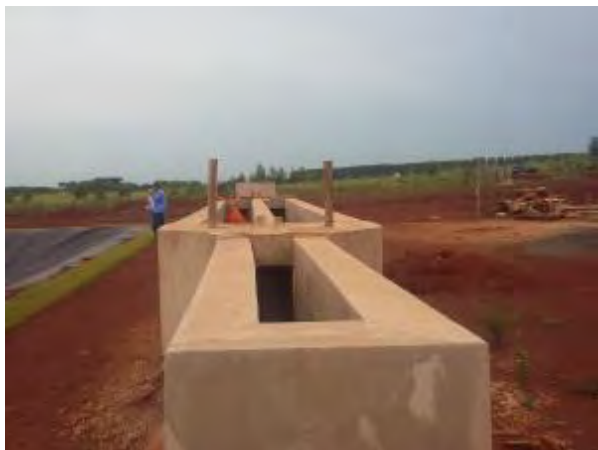
Figura 11: Vista do tratamento preliminar da ETE Nova Alvorada do Sul.
