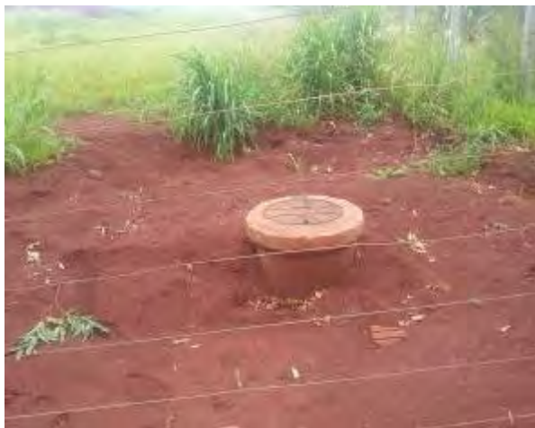
Figura 19: Vista do PV do emissário de efluente tratado de Nova Alvorada do Sul.
