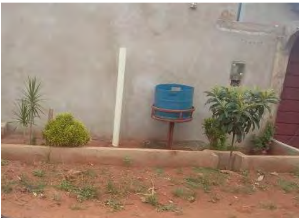
Figura 5: Fossa-sumidouro situada no passeio, em Nova Alvorada do Sul.
