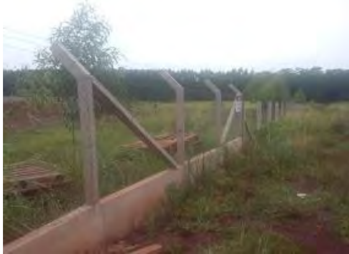
Figura 17: Vista do fechamento da área da ETE Nova Alvorada do Sul.
