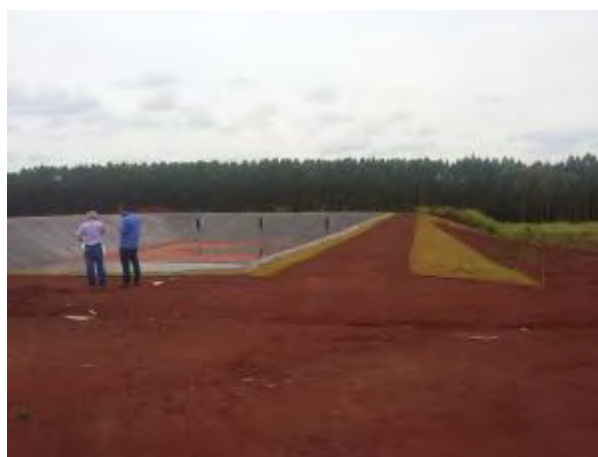
Figura 13: Lagoa Anaeróbia da ETE Nova Alvorada do Sul.
