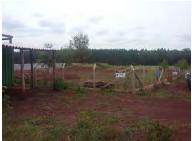
Figura 10: Vista geral da ETE Nova Alvorada do Sul.
