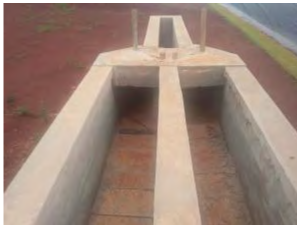
Figura 12: Vista do desarenador retangular da ETE Nova Alvorada do Sul.
