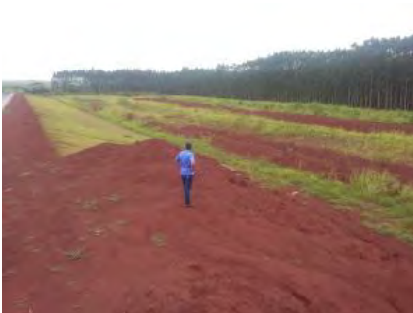
Figura 15: Vista da área prevista para implantação da Lagoa de Maturação da ETE Nova Alvorada do Sul.
