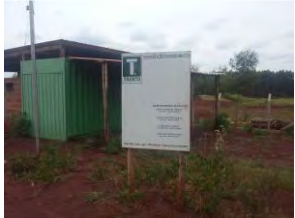
Figura 8: Entrada provisória de energia na ETE Nova Alvorada do Sul.
