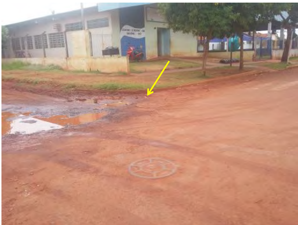
Figura 4: Vista do PV de esgoto no eixo da rua de Nova Alvorada do Sul.
