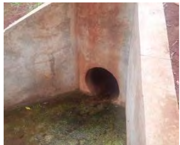
Figura 22: Vista 2 da estrutura do emissário da ETE Nova Alvorada do Sul no ponto de lançamento.
