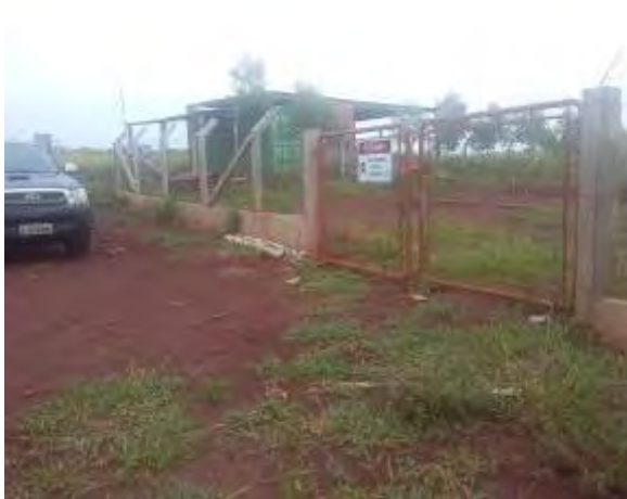
Figura 9: Portão de acesso da ETE de Nova Alvorada do Sul.
