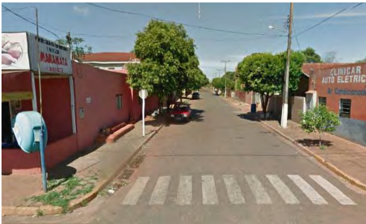
Figura 2: Vista do arruamento asfaltado com sistema de drenagem de águas pluviais e passeio de Nova Alvorada do Sul.
