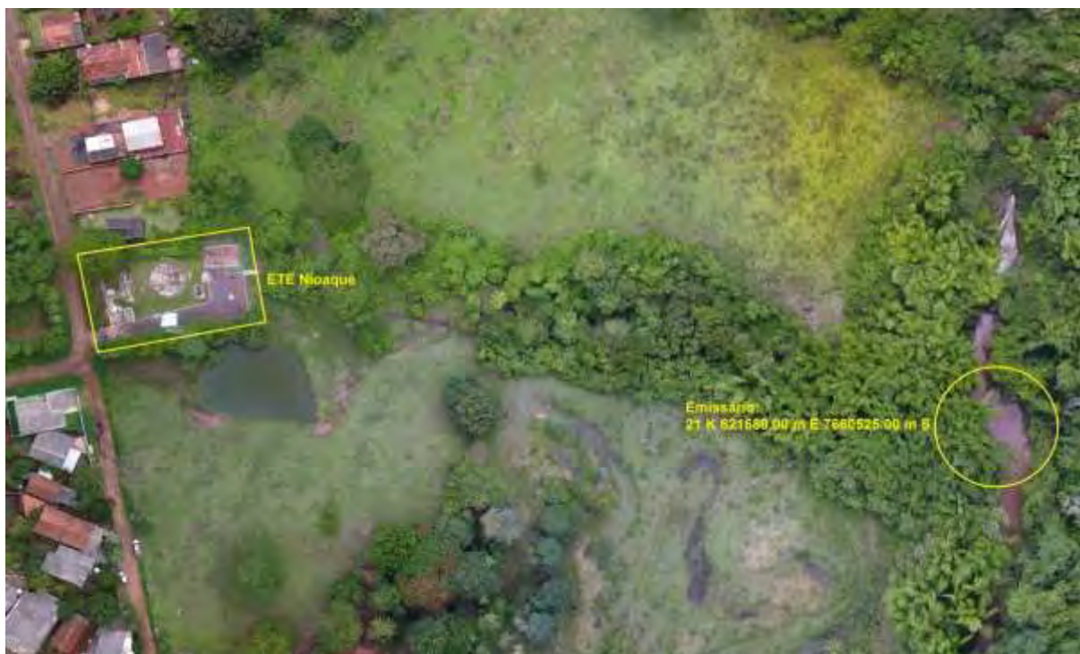
Figura 3: Vista aérea da ETE Nioaque e entorno, Nioaque, MS
