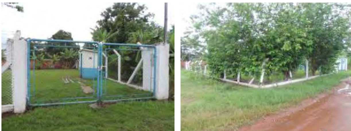
Figura 7: Vista geral da EEEB 006, Nioaque, MS.
