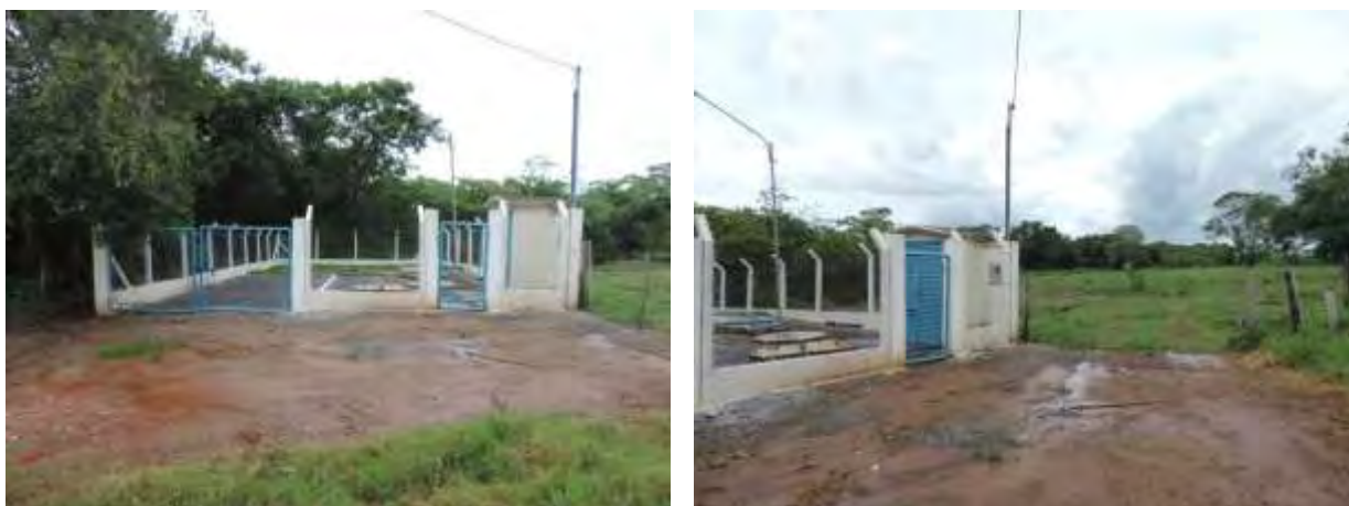
Figura 6: Vista geral da EEEB 005, Nioaque, MS.
