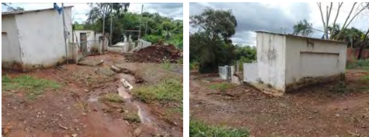
Figura 9: Vista geral do entorno da EEEB 009 mostrando o início do processo erosivo, Nioaque, MS.
