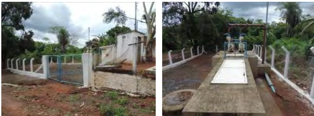
Figura 8: Vista geral da EEEB 009, Nioaque, MS.
