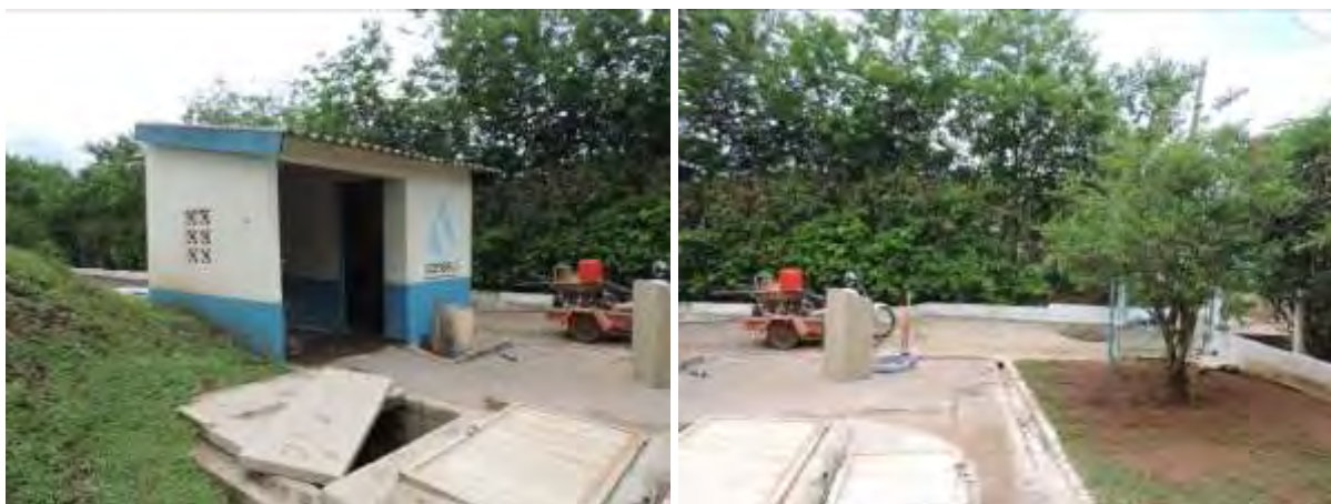
Figura 5: Vista geral da EEEB 004, Nioaque, MS.
